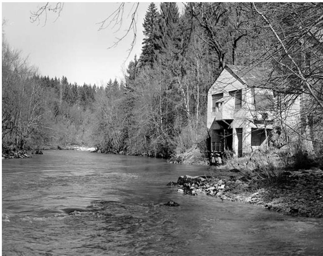
Salle des machines de la centrale, vue de trois quarts.
