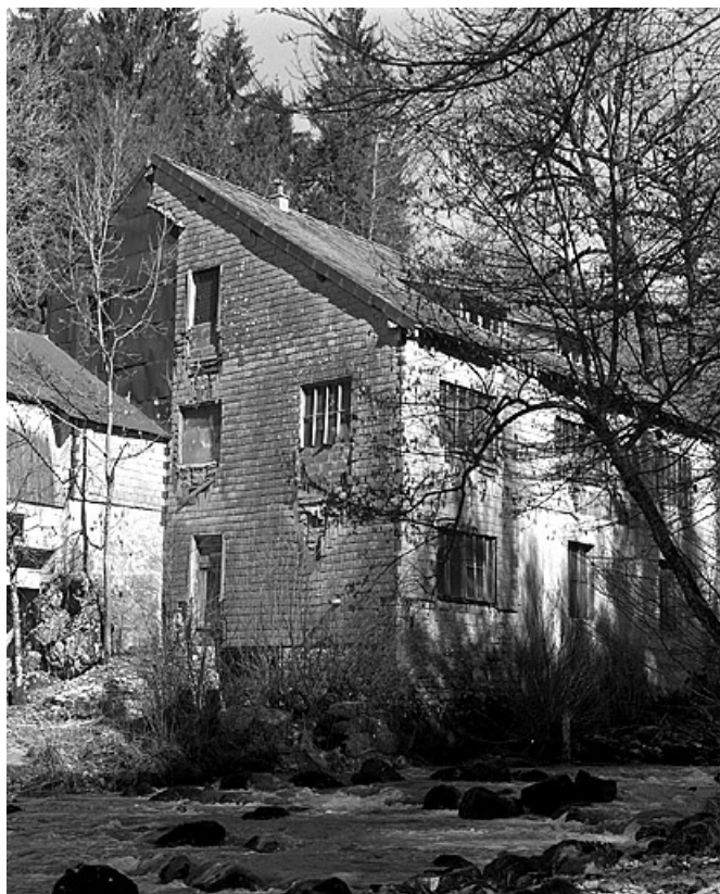
Ancien atelier de fabrication depuis le sud.
