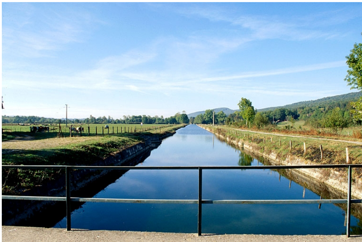
Le canal d'amenée depuis la prise d'eau.
