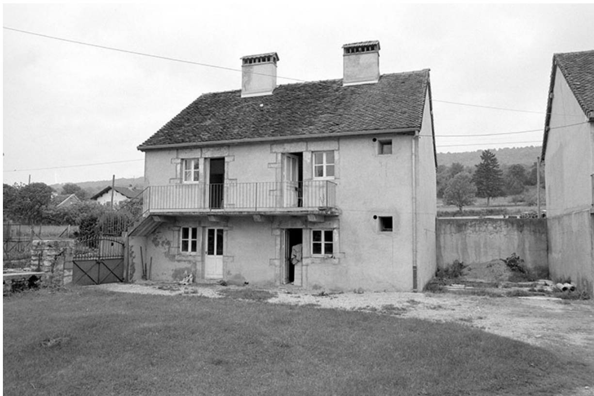
Façade sur cour d'un logement ouvrier.
