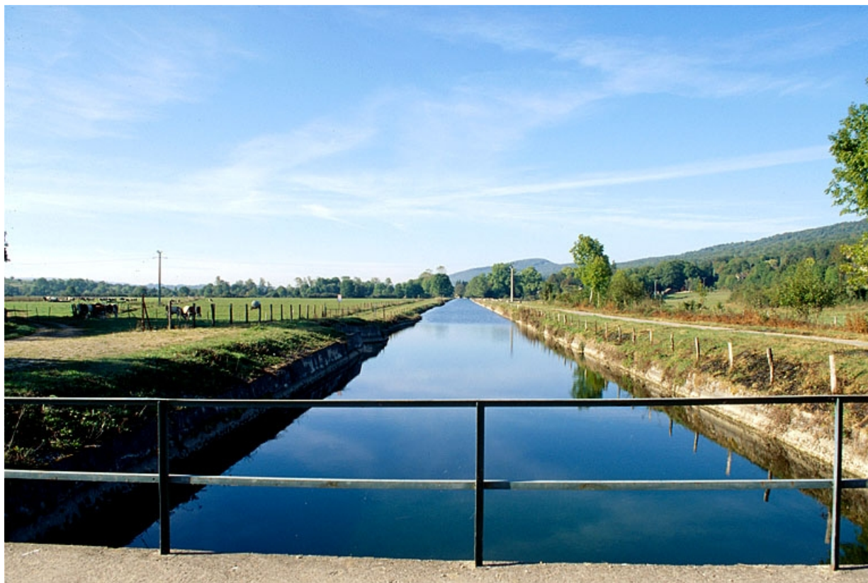
Le canal d'amenée depuis la prise d'eau.
