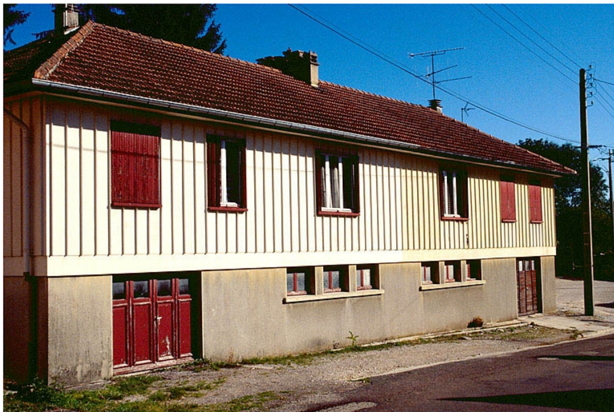
Logement double à étage (maison Fillod). 39, Ardon R.D. 27
