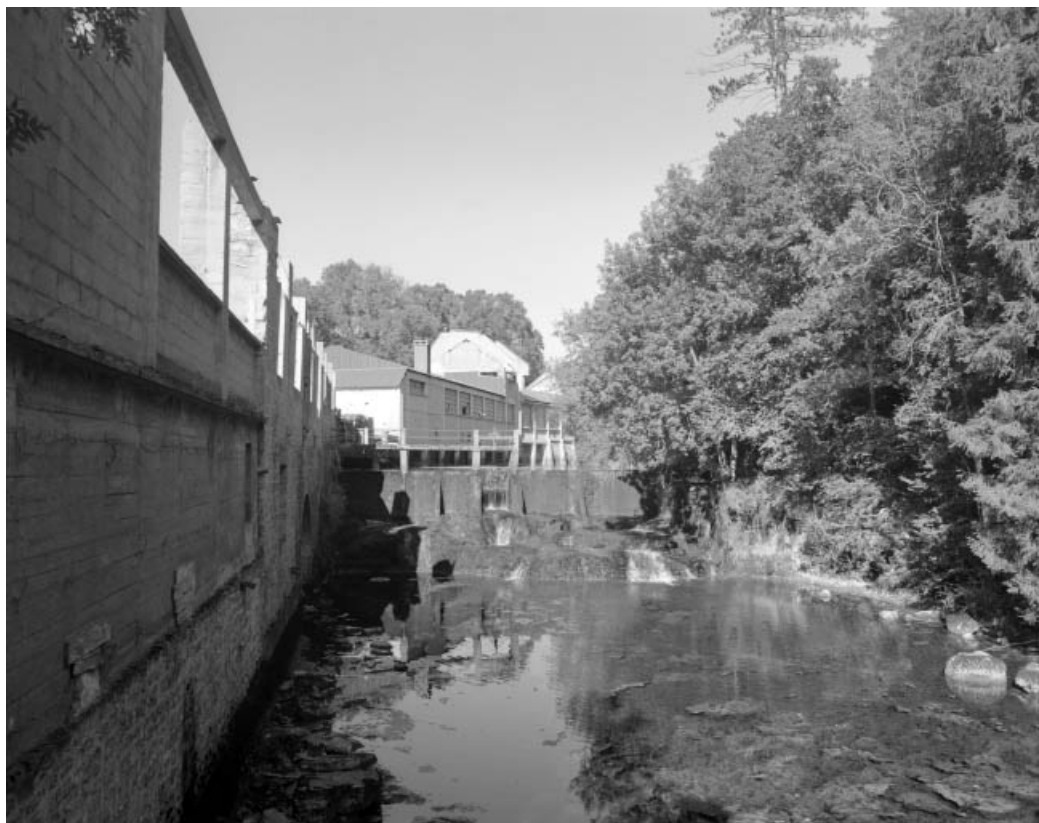
Façades de l'usine sur l'Angillon et barrage.
