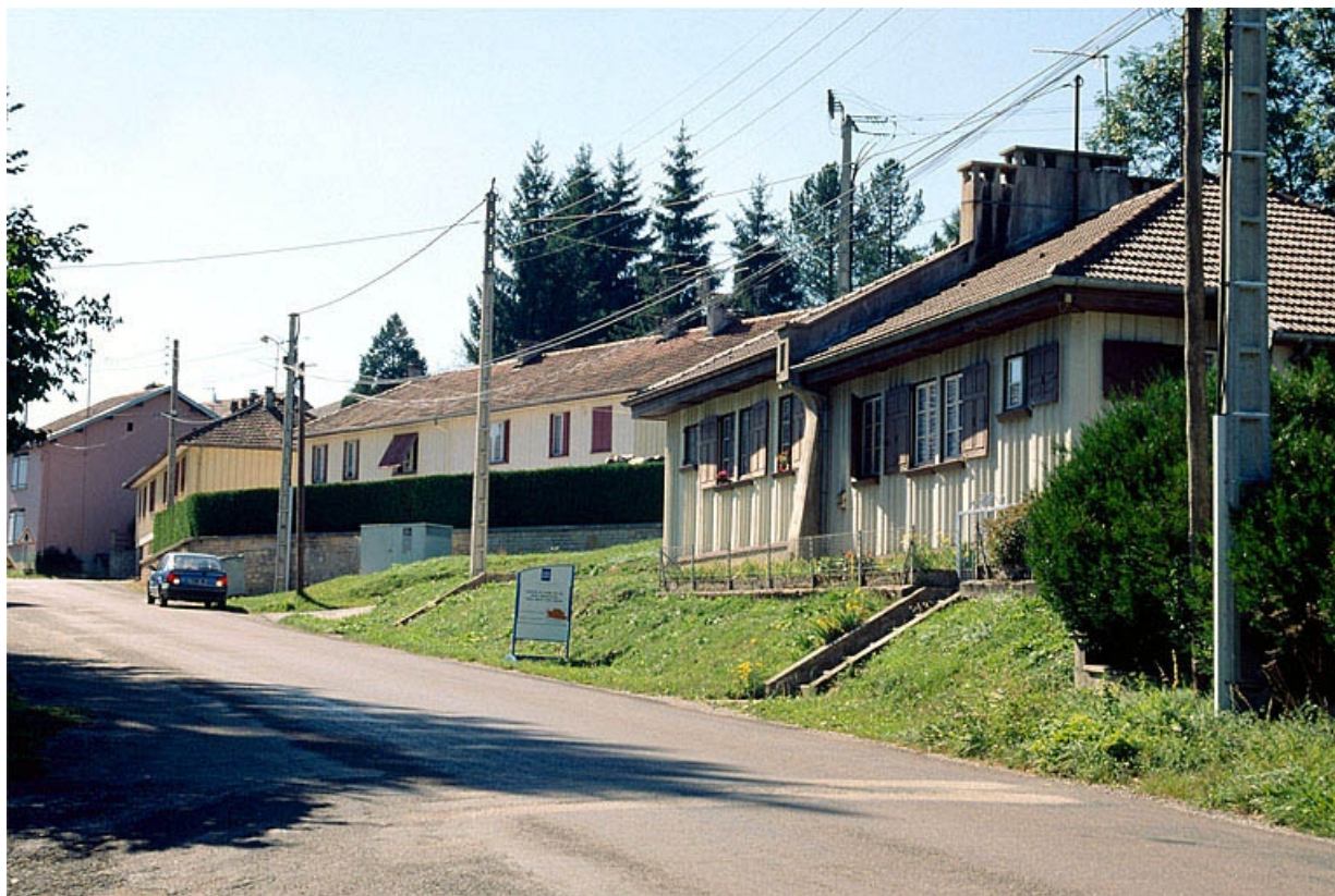
Vue d'ensemble des logements depuis l'est.
