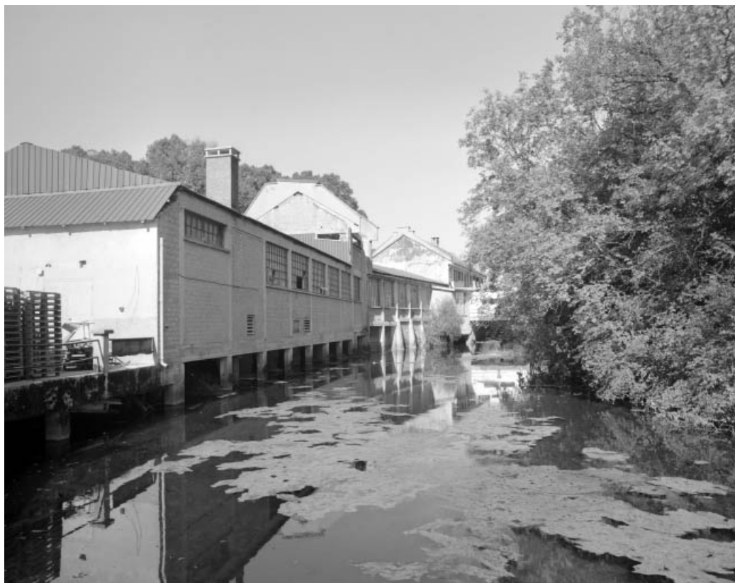
Façades des ateliers de fabrication sur l'Angillon.
