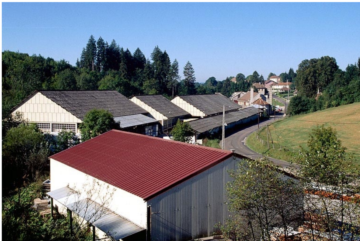
Vue d'ensemble depuis la voie ferrée. 39, Ardon R.D. 27
