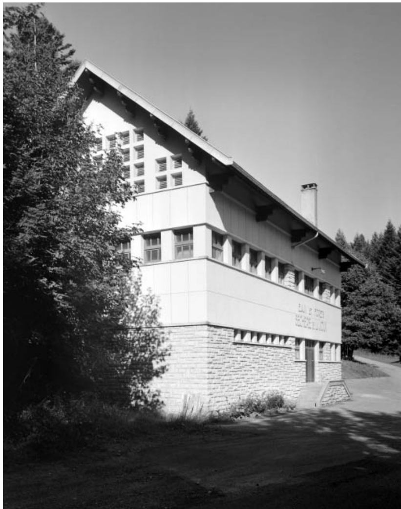
La sécherie résineuse vue de trois quarts gauche.
