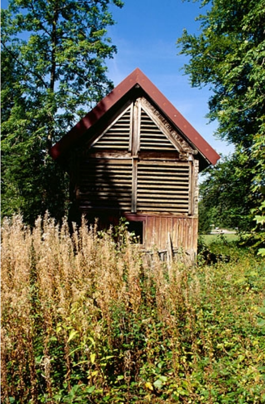
Façade sud du hangar séchoir.
