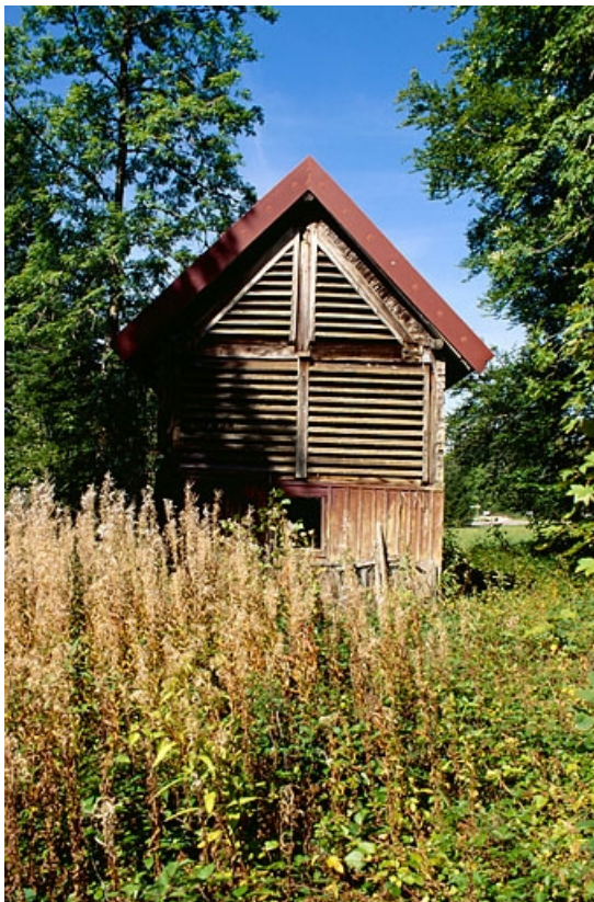
Façade sud du hangar séchoir.
