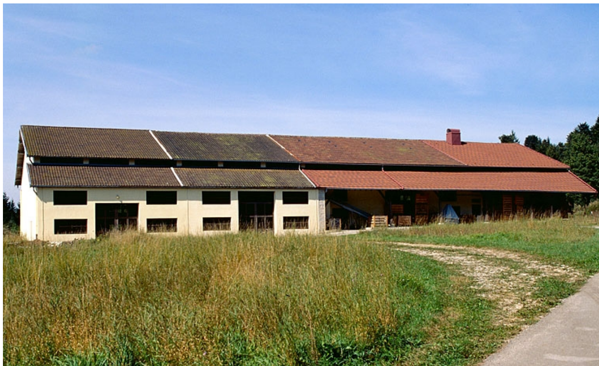
Façade antérieure du séchoir (ancienne ferme de Montrainçon).
