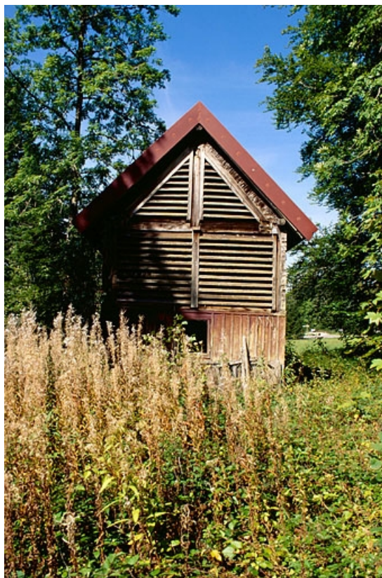
Façade sud du hangar séchoir.
