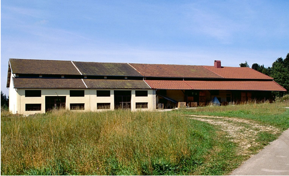
Façade antérieure du séchoir (ancienne ferme de Montrainçon). 39, Supt, lieudit : la Joux
