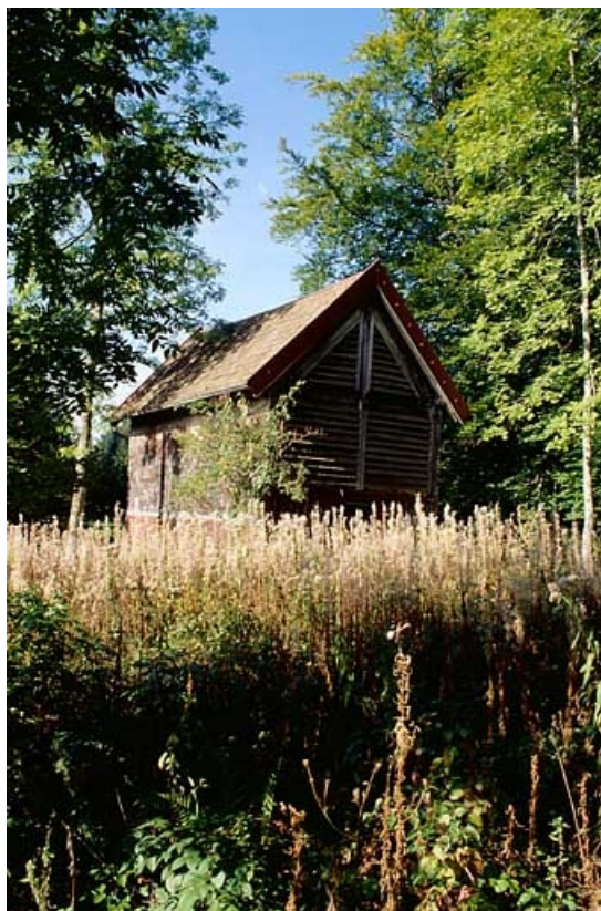
Vue de trois quarts du hangar séchoir.
