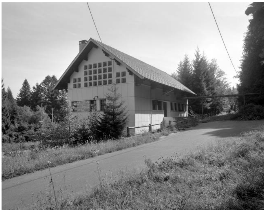
La sécherie résineuse vue de trois quarts arrière.
