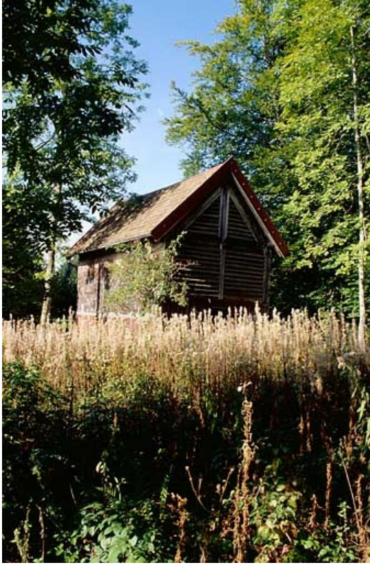
Vue de trois quarts du hangar séchoir.
