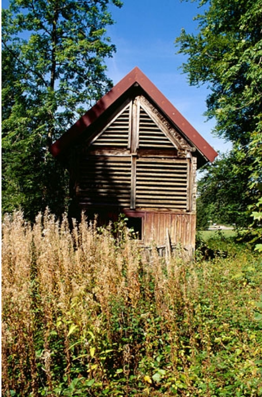
Façade sud du hangar séchoir.
