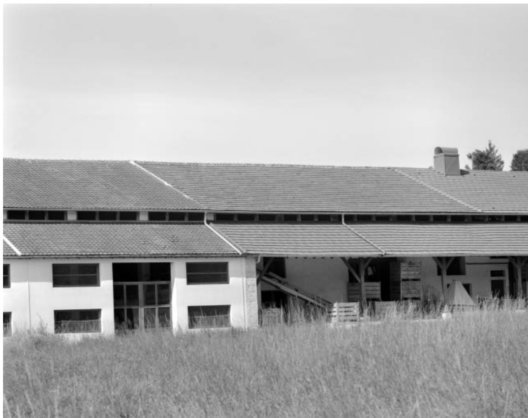
Séchoir : détail de la façade antérieure.
