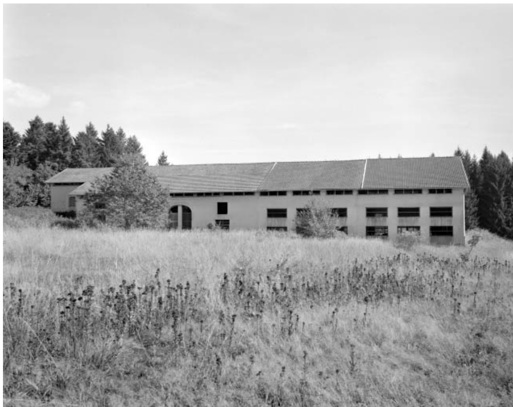
Façade postérieure du séchoir.
