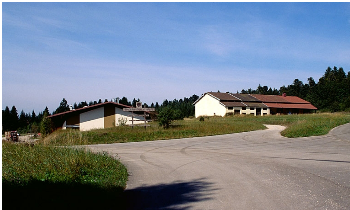
Vue d'ensemble de la sécherie de graines de feuillus et de l'ancienne ferme de Montrainçon.
