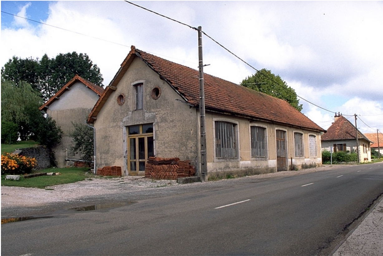
Atelier de fabrication depuis la route.
