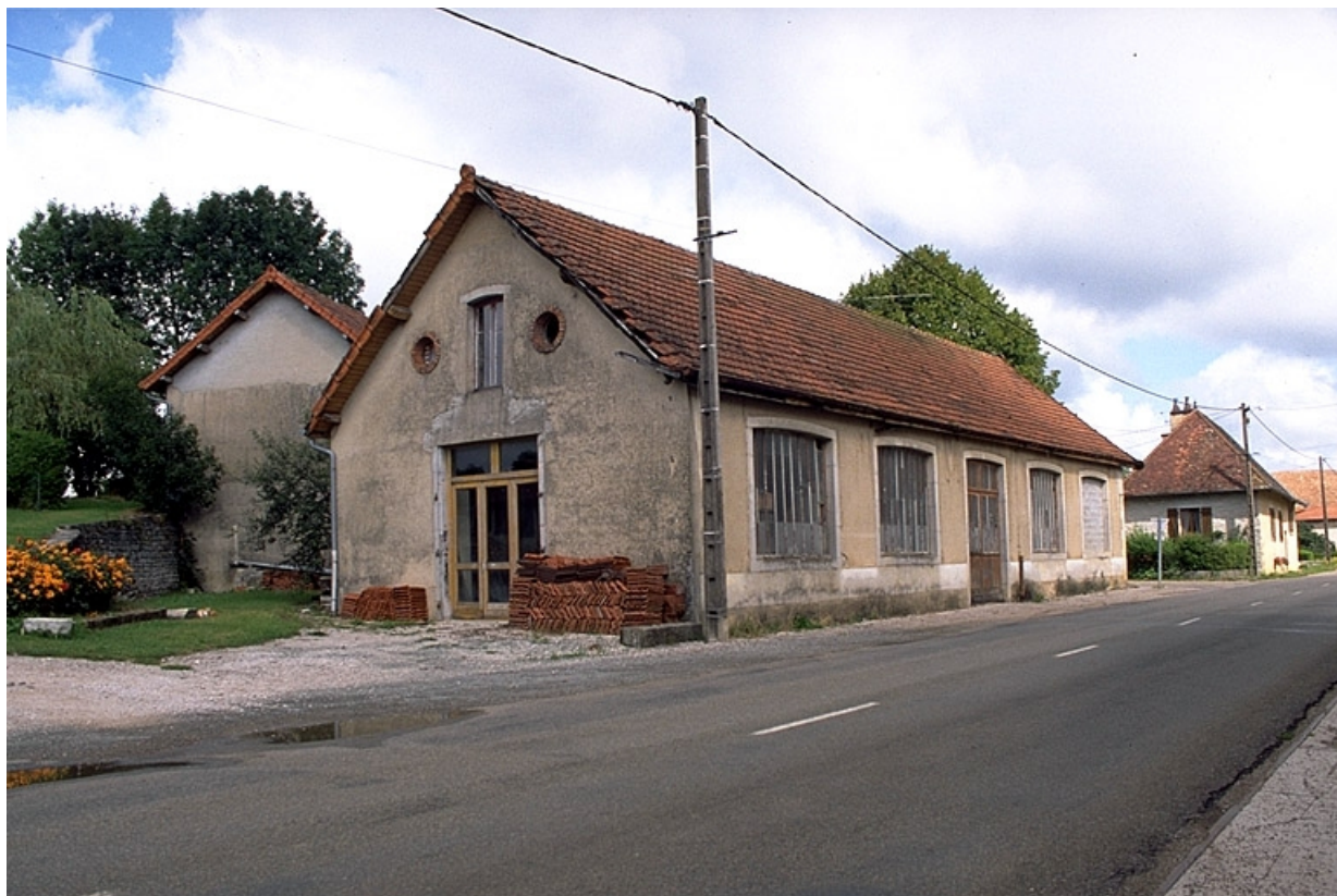
Atelier de fabrication depuis la route.
