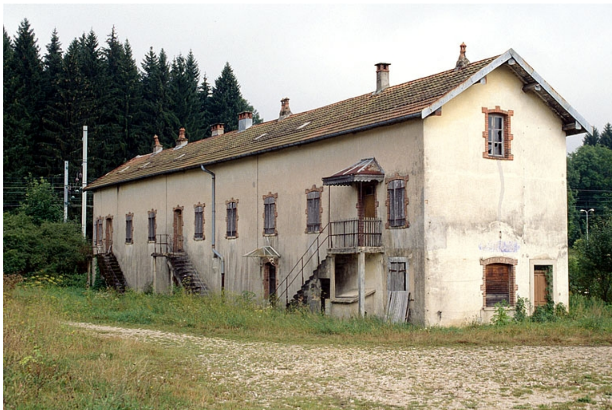
Façade antérieure du logement ouvrier. 39, Andelot-en-Montagne, lieudit : la Gare
