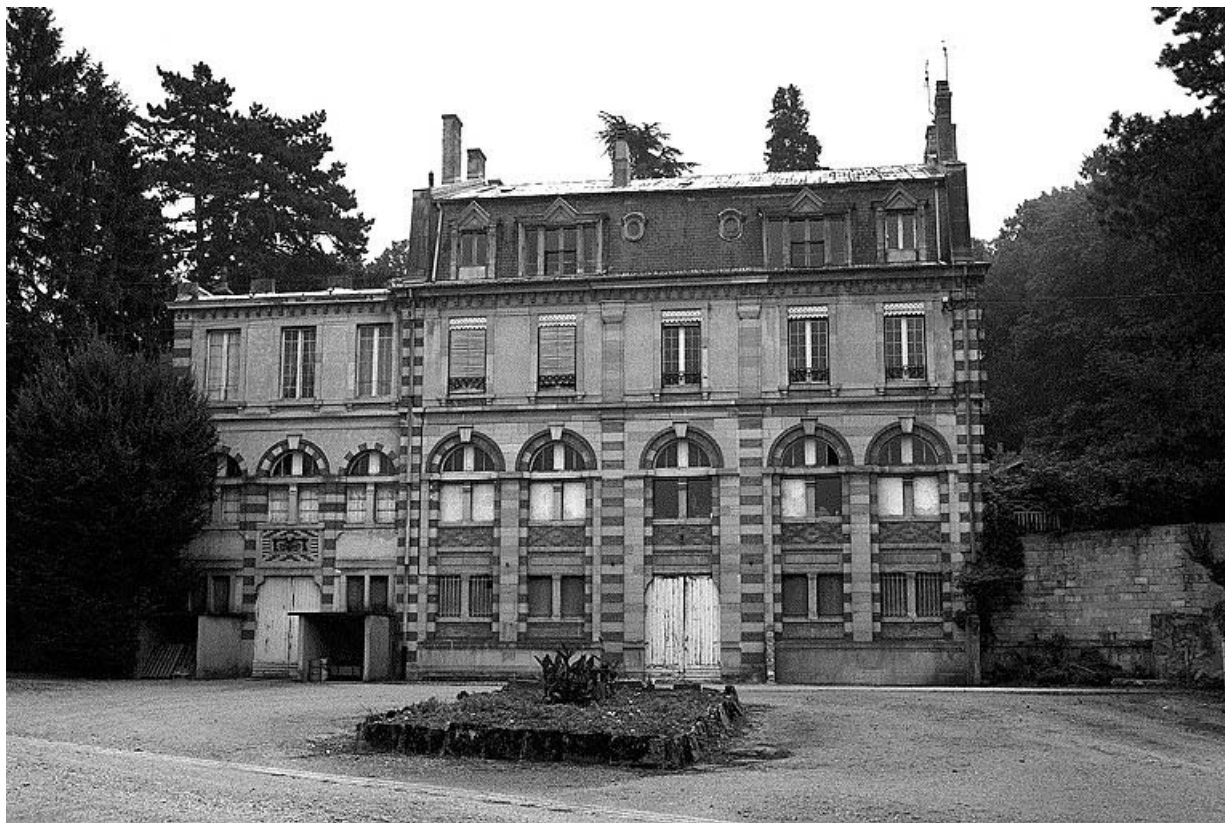
Bâtiment abritant un chai, l'atelier de conditionnement et le logement patronal.
