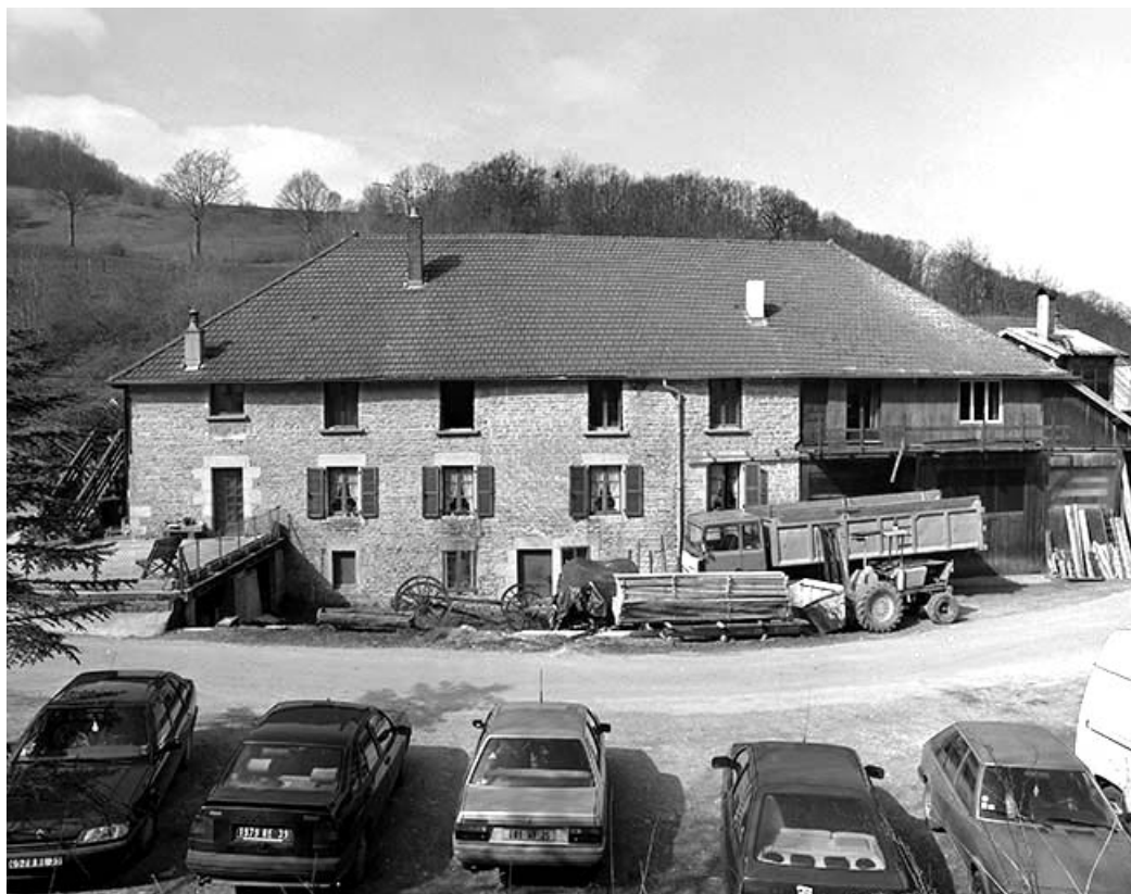
Logement et atelier de fabrication : façade antérieure.
