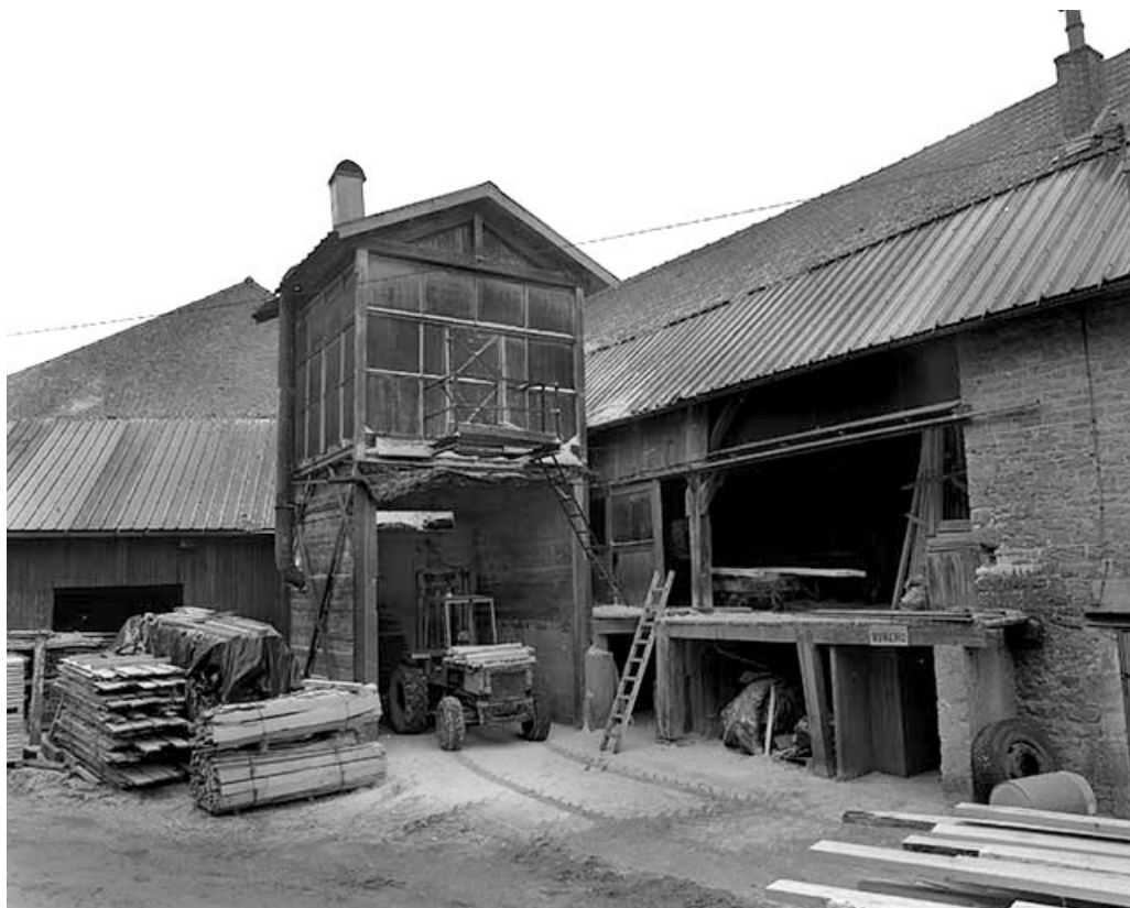
Silo à sciure et atelier de fabrication.
