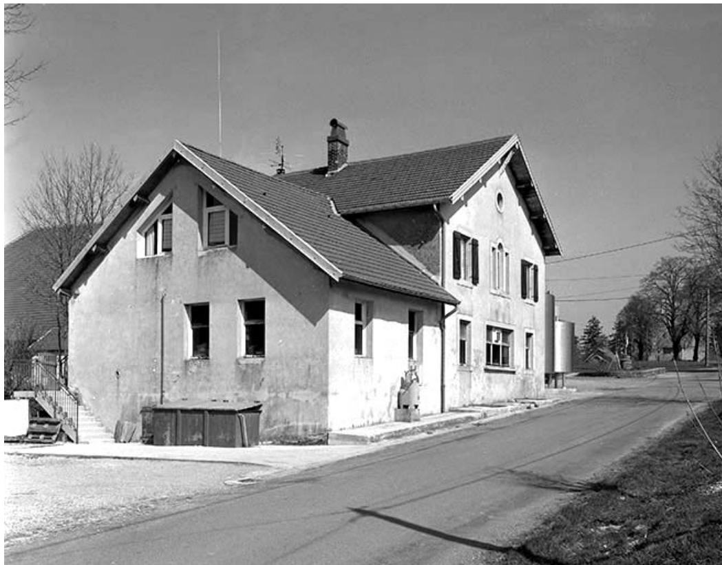
Façade sur rue de trois quarts gauche. 39, Chilly-sur-Salins, lieudit : Village Haut
