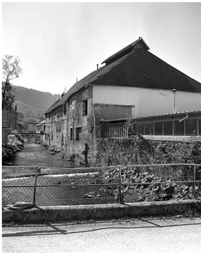
Façade postérieure de l'atelier de fabrication. 39, Salins-les-Bains, 6, 8 avenue Aristide Briand
