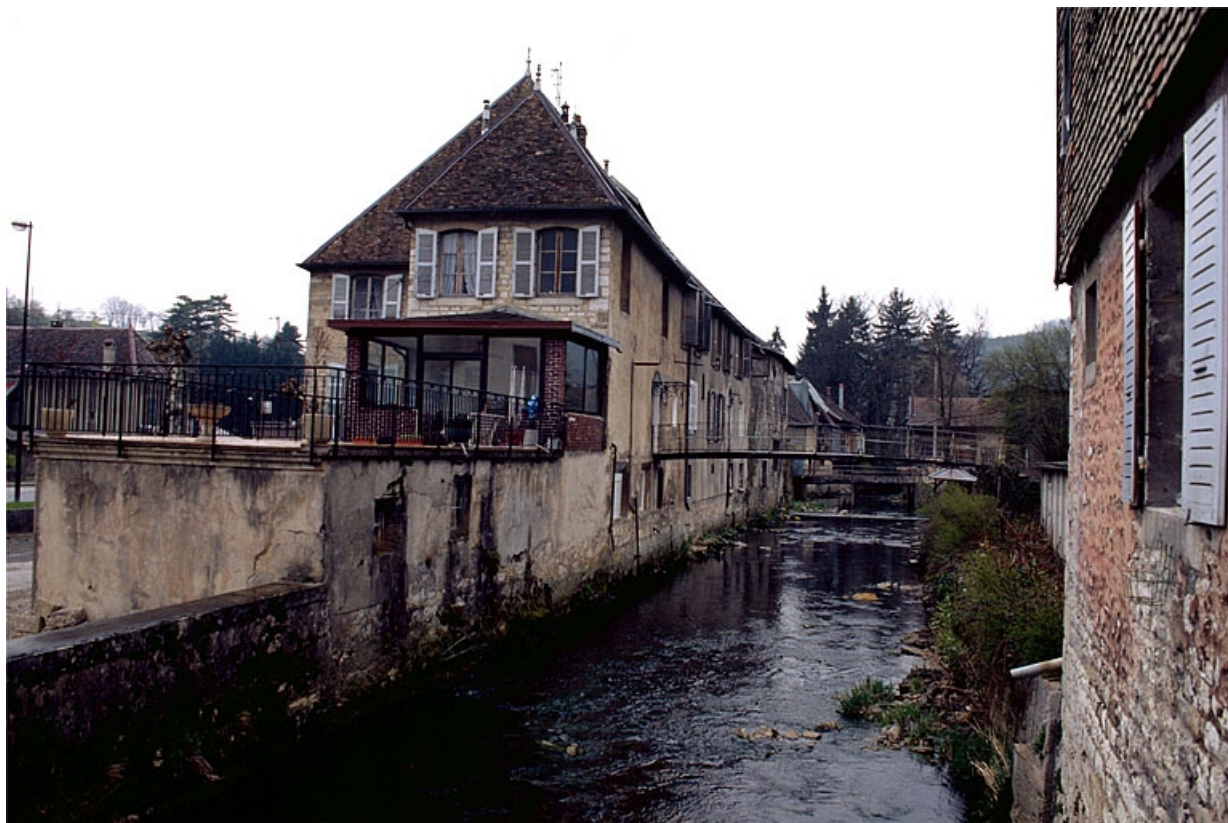
Façade sur rivière des bureaux et de l'atelier de fabrication.
