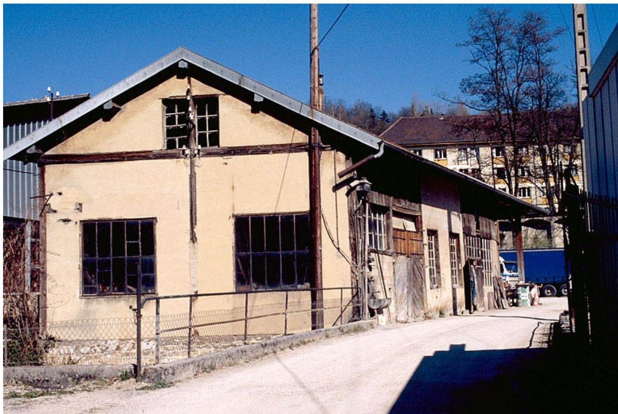
Atelier de réparation depuis la rive gauche. 39, Salins-les-Bains, 6, 8 avenue Aristide Briand
