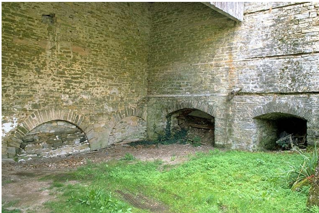
Gueules des fours. Les 2 ouvertures de droite correspondent aux gueules des fours à chaux.
