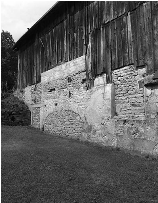
Façade sud de l'atelier de fabrication.
