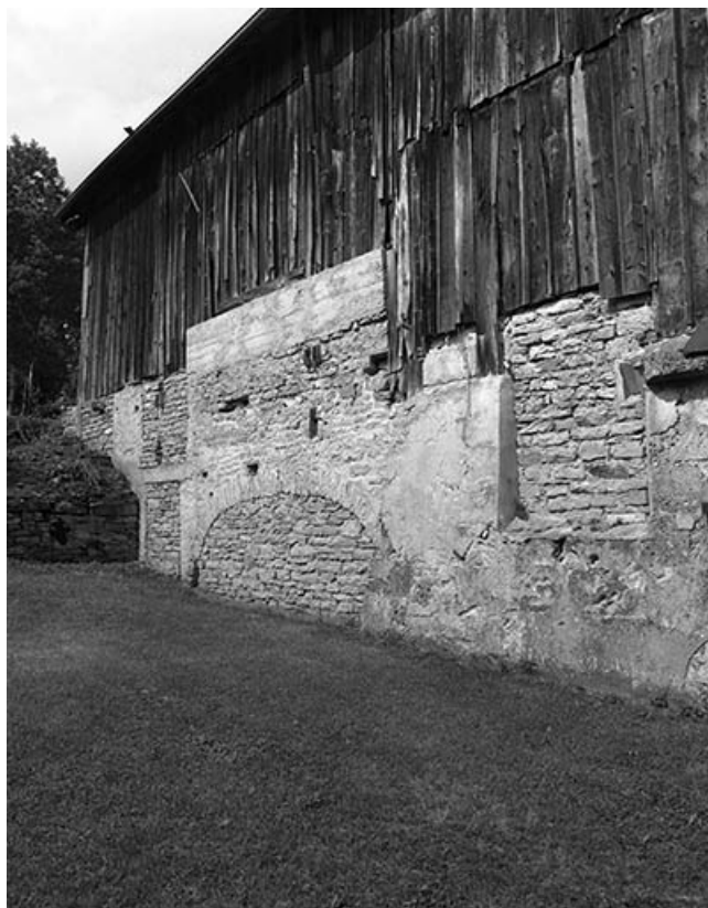
Façade sud de l'atelier de fabrication.
