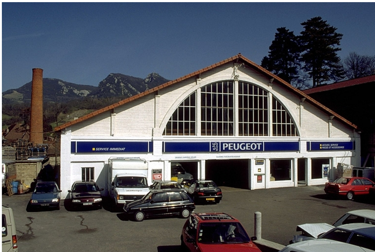
Pignon sud de l'atelier de fabrication. 39, Salins-les-Bains rue Gambetta
