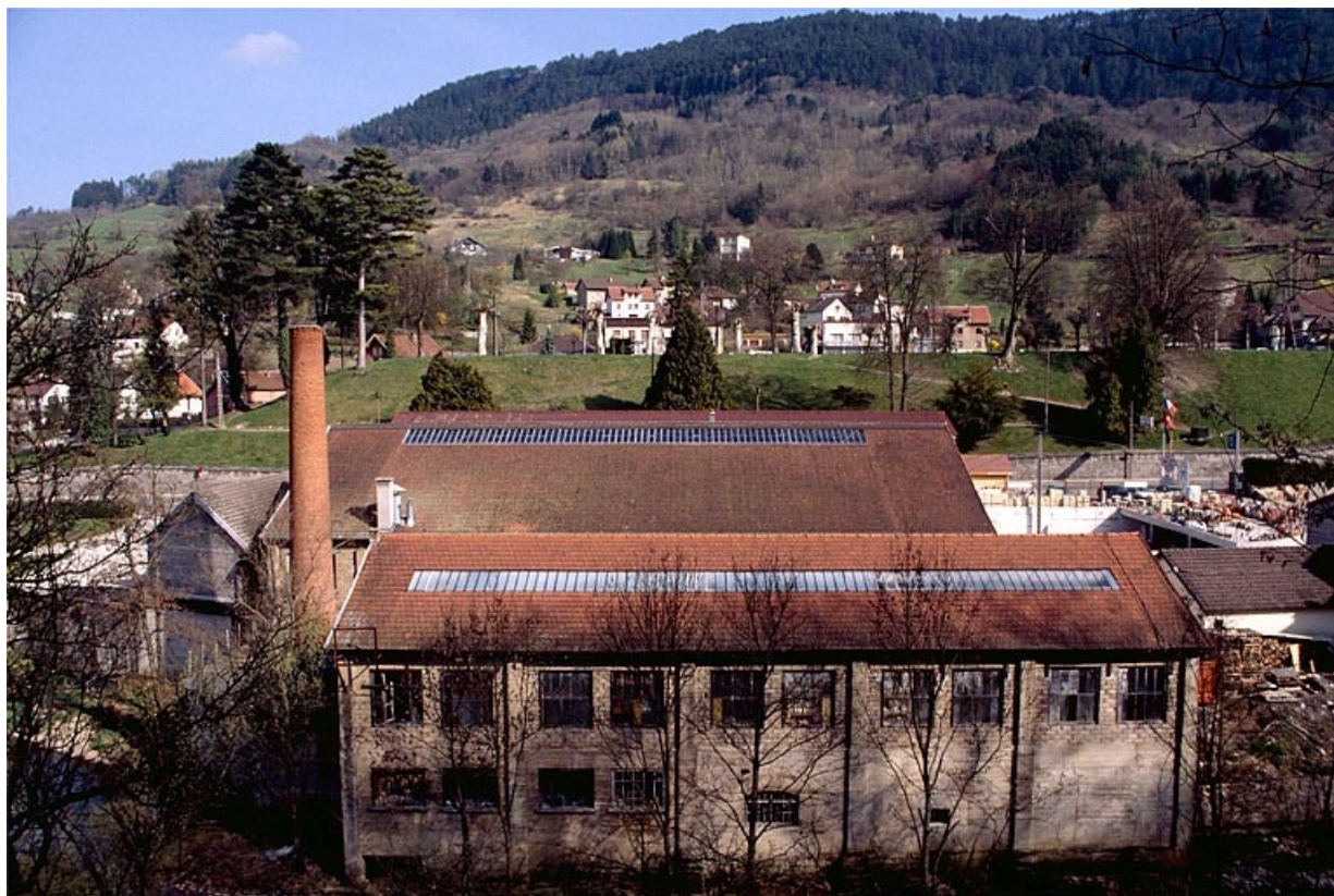
Façade postérieure de l'atelier de mécanique générale.
