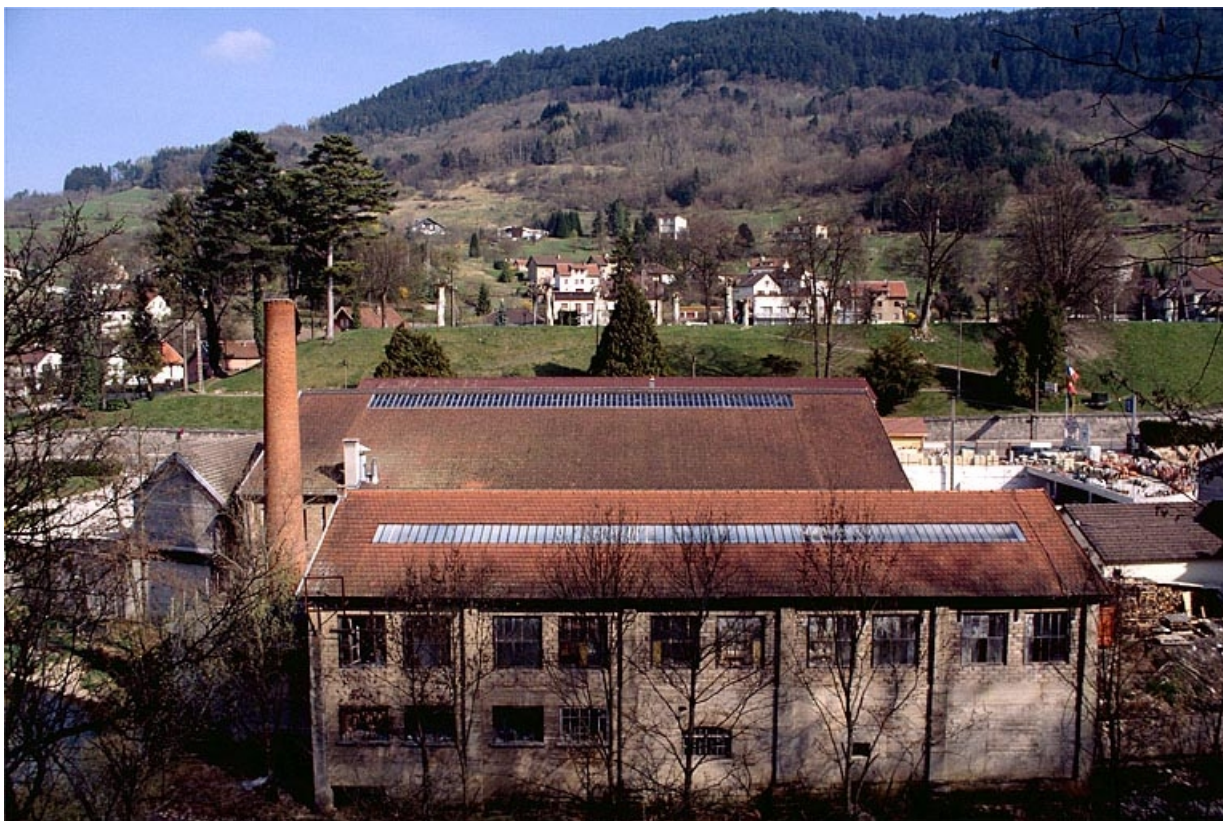
Façade postérieure de l'atelier de mécanique générale.
