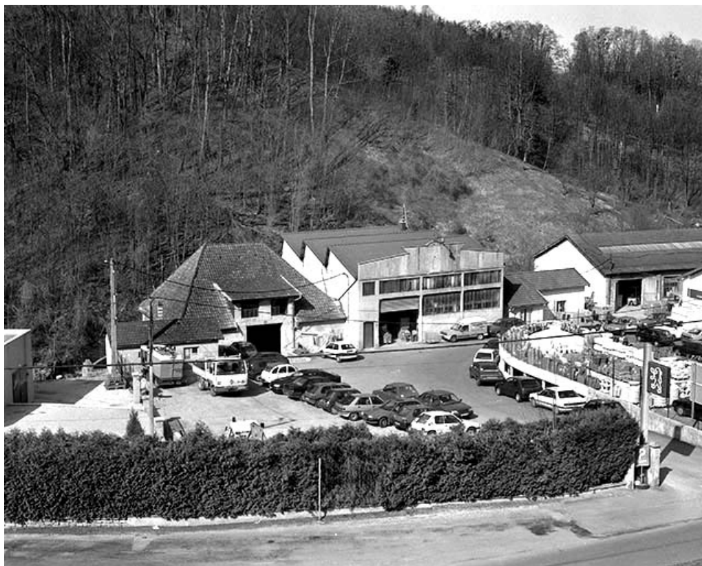
Vue plongeante depuis l'ouest. De gauche à droite : fonderie, garage et atelier de mécanique générale. 39, Salins-les-Bains rue Gambetta
