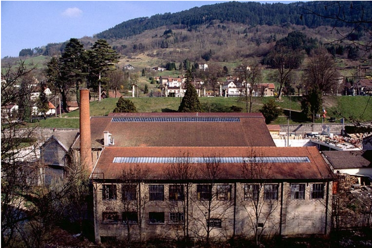
Façade postérieure de l'atelier de mécanique générale.
