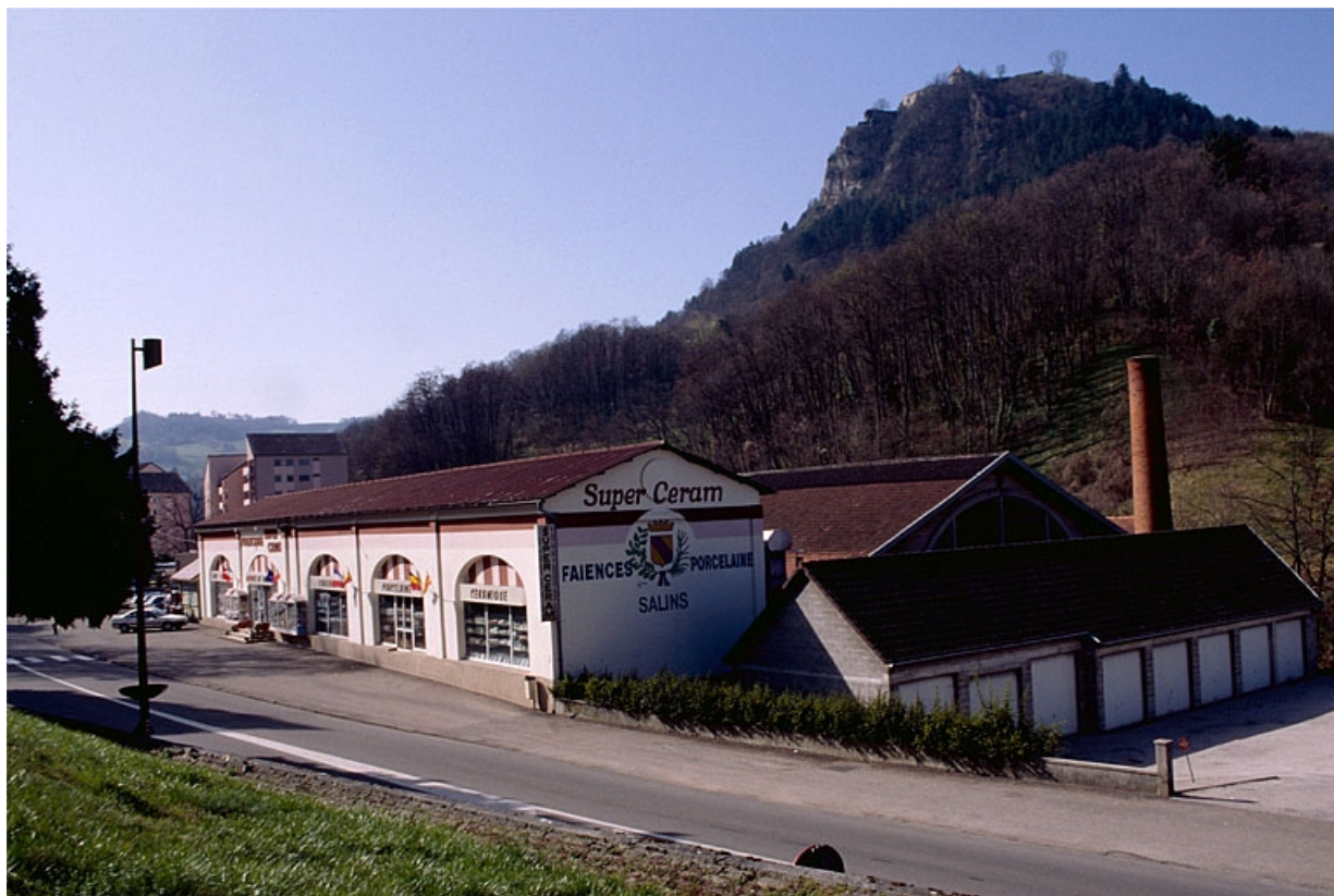
Pièce de séchage et atelier de fabrication depuis le nord-est.
