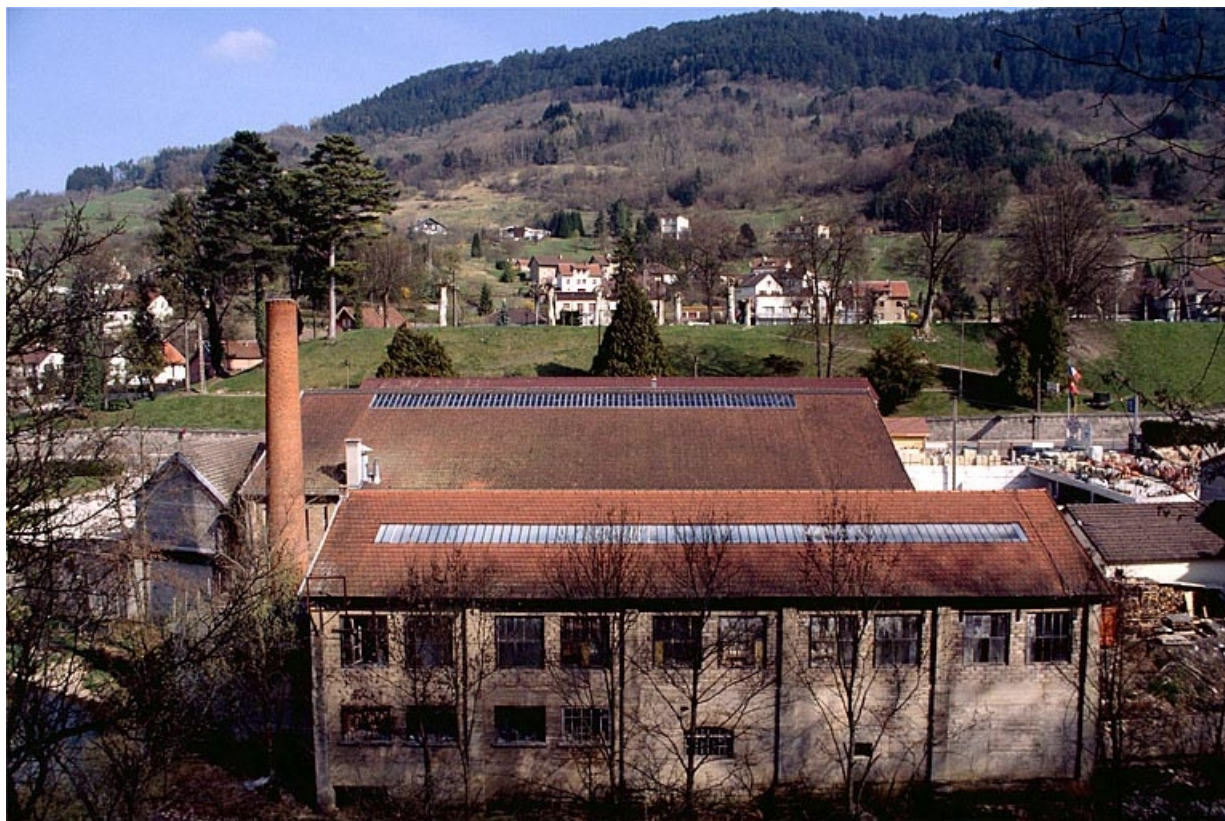
Façade postérieure de l'atelier de mécanique générale.
