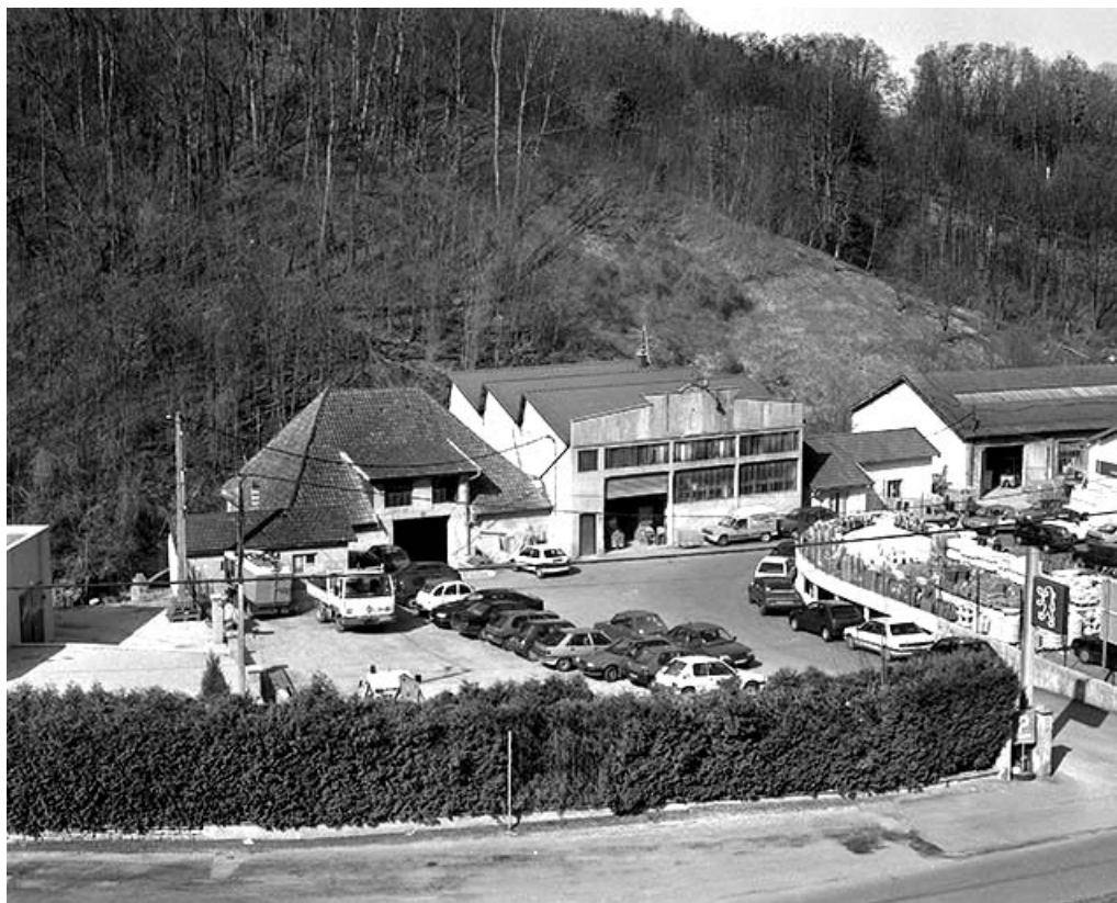
Vue plongeante depuis l'ouest. De gauche à droite : fonderie, garage et atelier de mécanique générale. 39, Salins-les-Bains rue Gambetta
