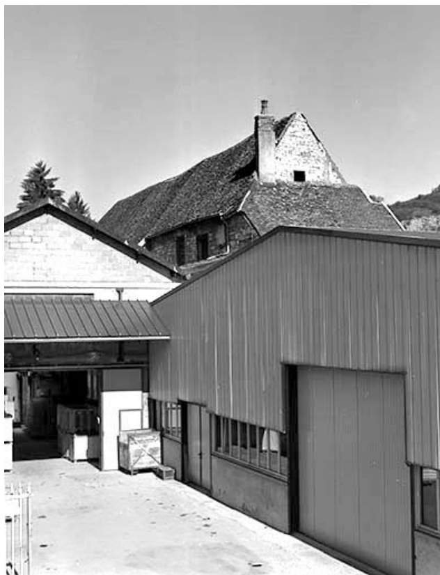
Le bâtiment du four industriel et la toiture de l'ancienne chapelle des Capucins.
