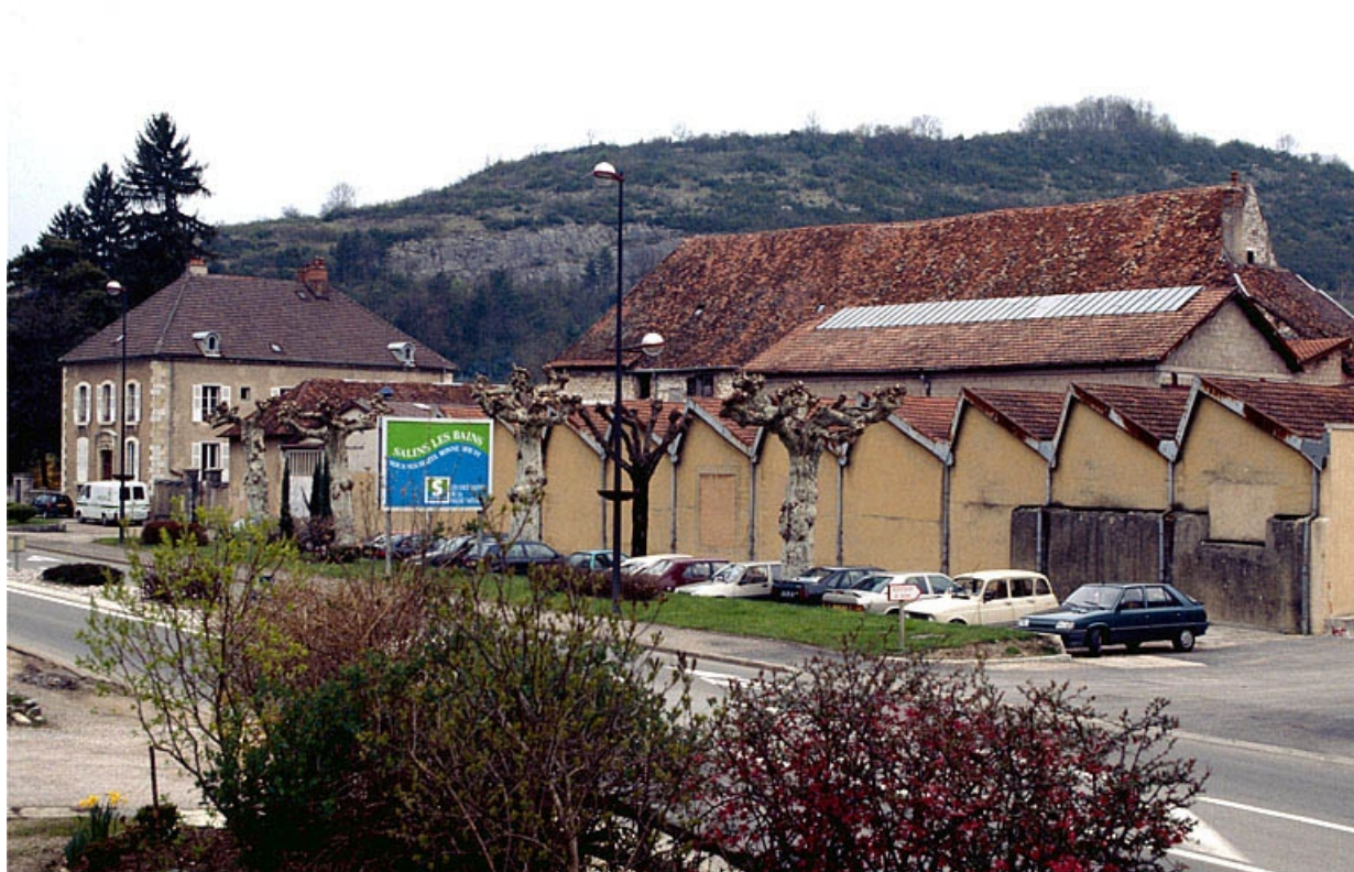
Partie occidentale de l'usine. Logement patronal et magasins industriels.
