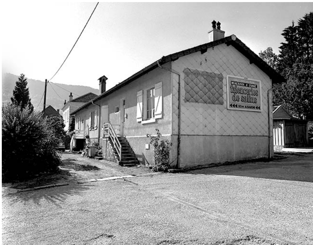
Logement ouvrier : façade antérieure vue de trois quarts.
