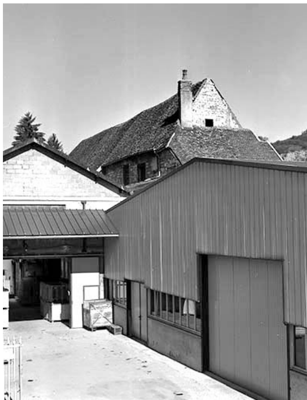
Le bâtiment du four industriel et la toiture de l'ancienne chapelle des Capucins.
