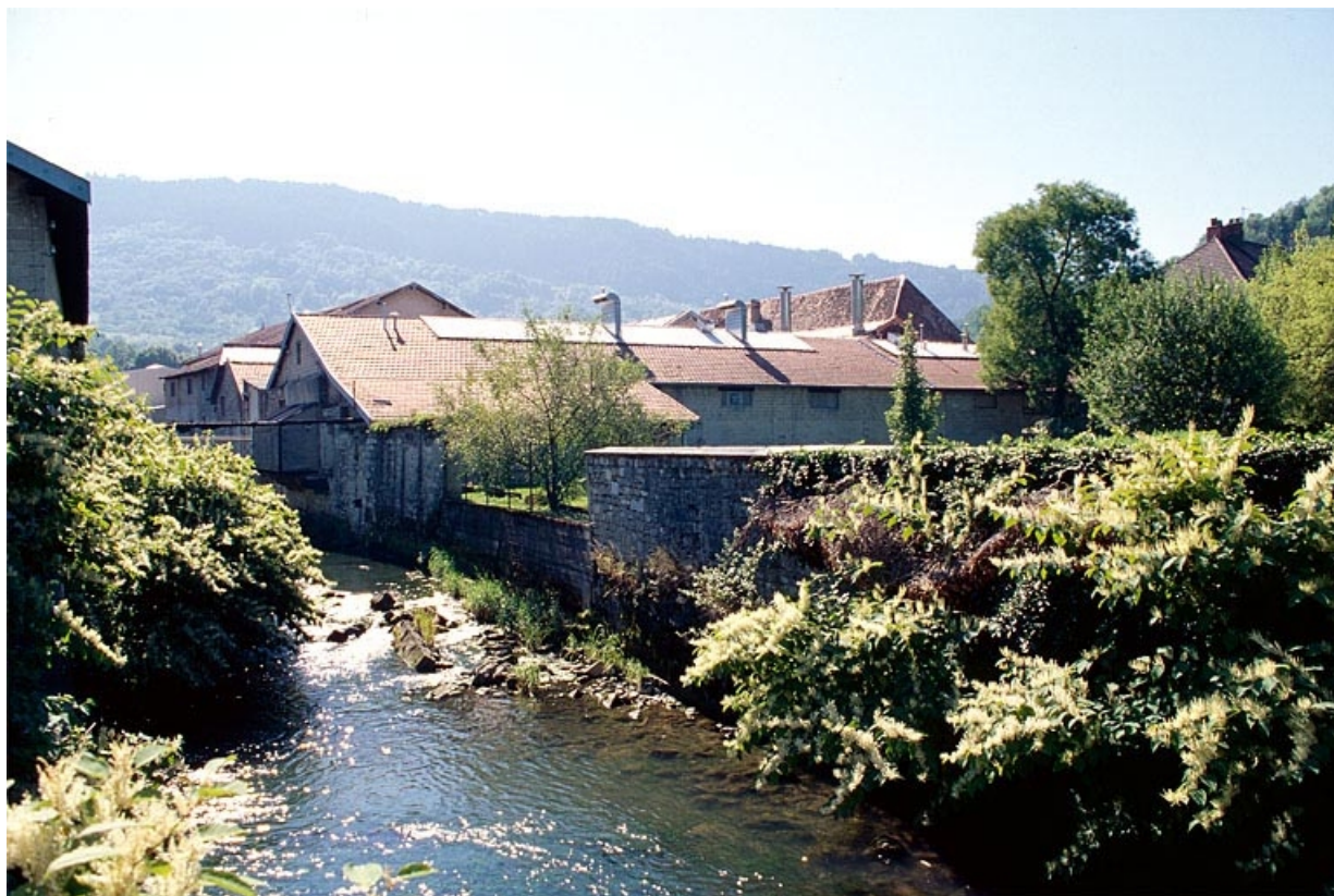
Façades postérieures depuis la Furieuse en aval.
