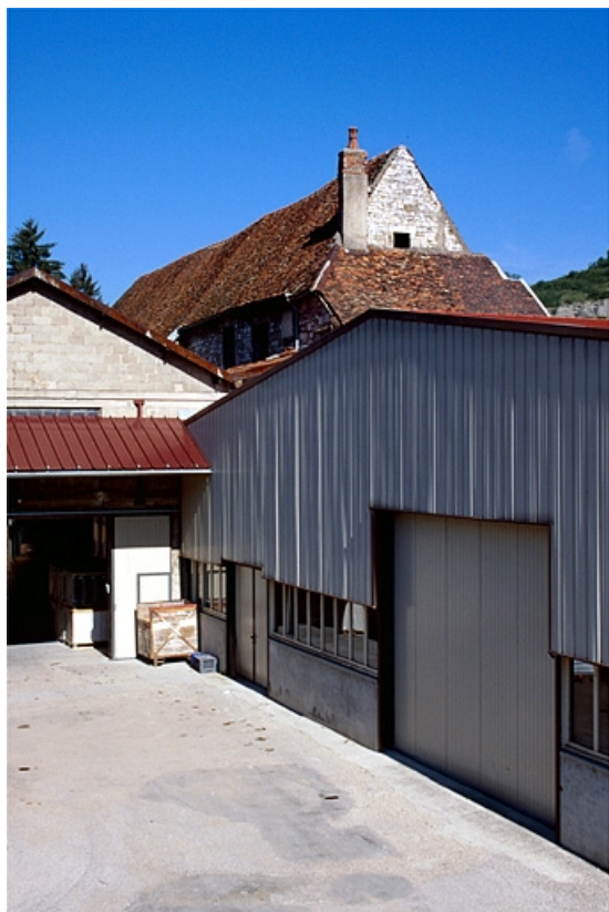
Le bâtiment du four industriel et la toiture de l'ancienne chapelle des Capucins.
