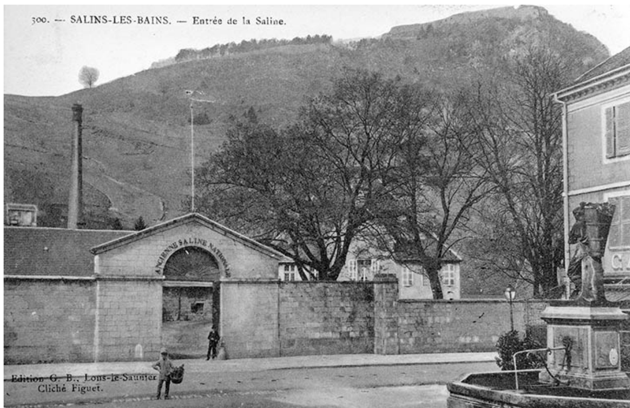
Salins-les-Bains. - Entrée de la Saline.
