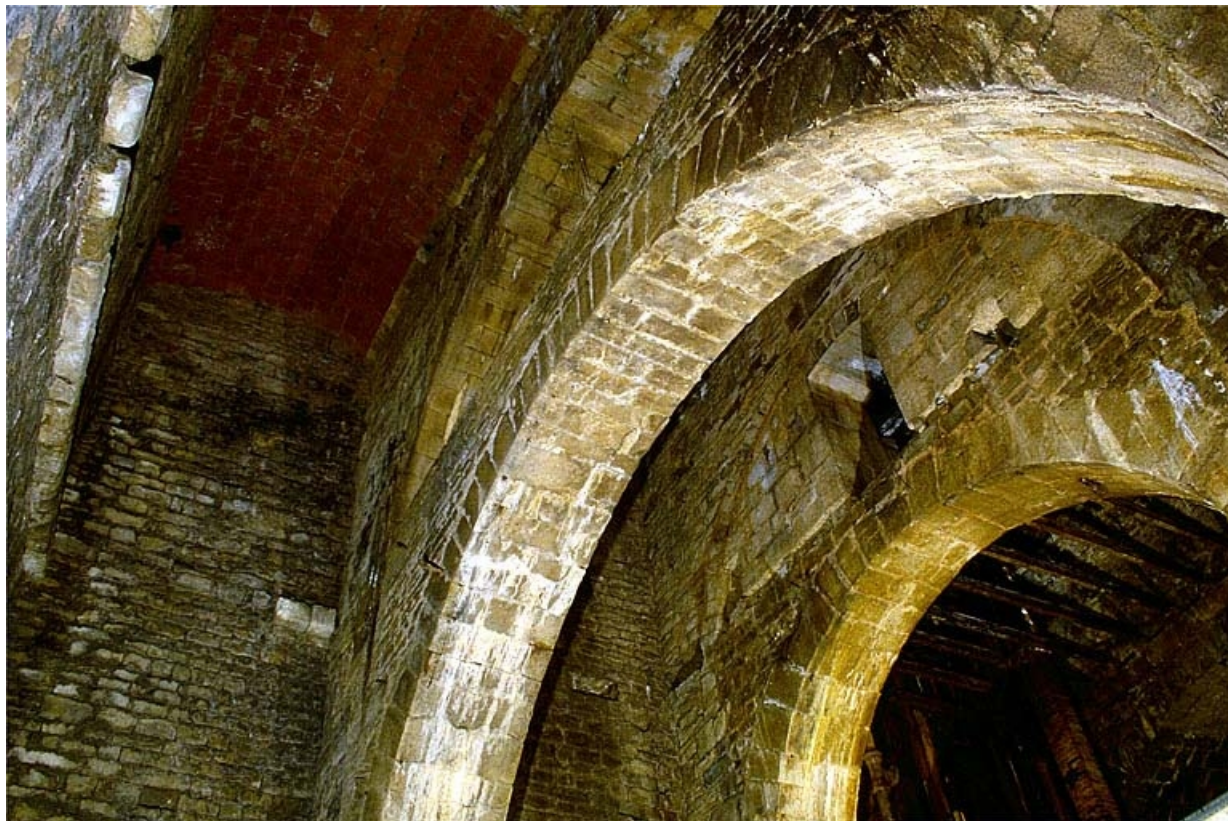
Arcs-diaphragmes et voûtement du puits à Muire.
