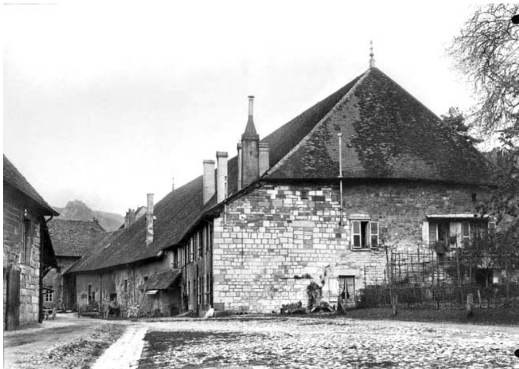
[Le bâtiment du puits à Grès].
