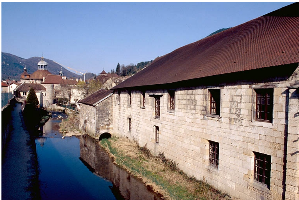
Façade postérieure du bâtiment des poêles et du magasin industriel (dit grenier à sel). 39, Salins-les-Bains place des Salines
