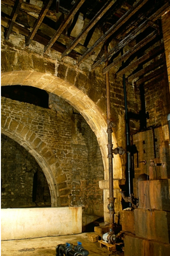
Arcs-diaphragmes sud du puits à Muire. Les 2 baies cintrées visibles dans le mur du fond donnaient accès à une ancienne source. 39, Salins-les-Bains place des Salines
