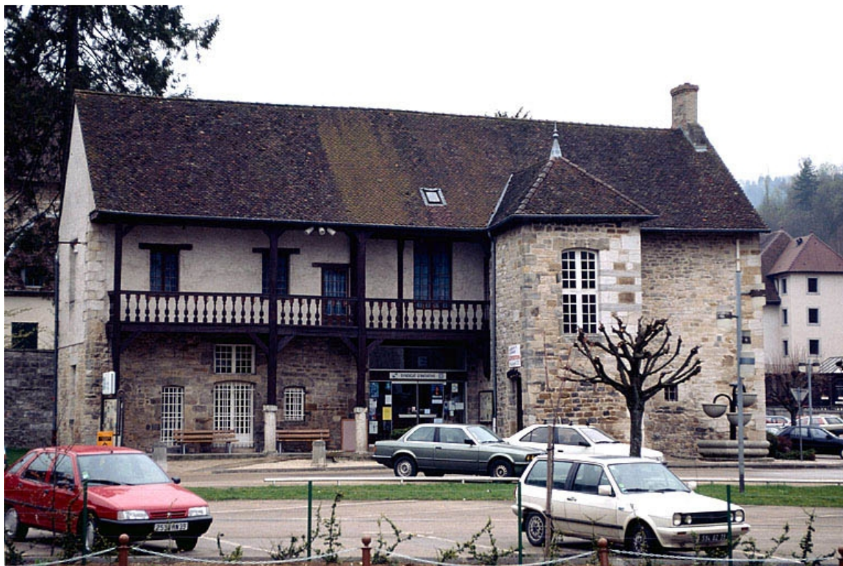
Façade antérieure d'un ancien logement et magasin à fer et à charbon.
