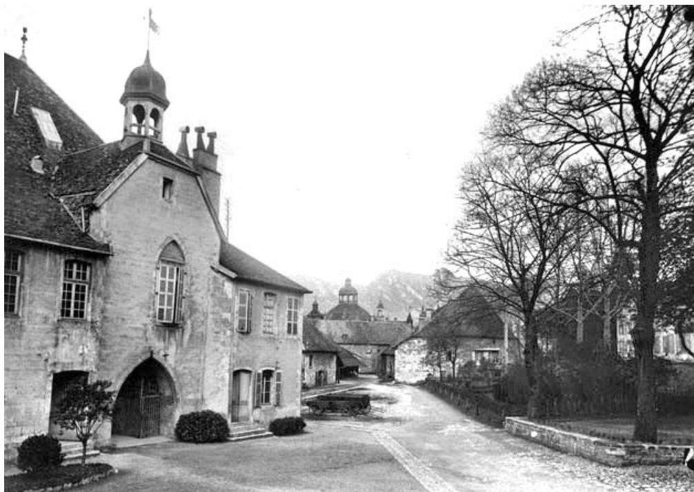
[Vue d'ensemble de la cour depuis le sud-est].
