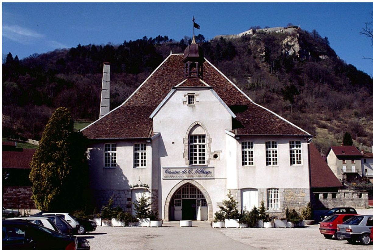
Façade antérieure de la maison du Pardessus.
