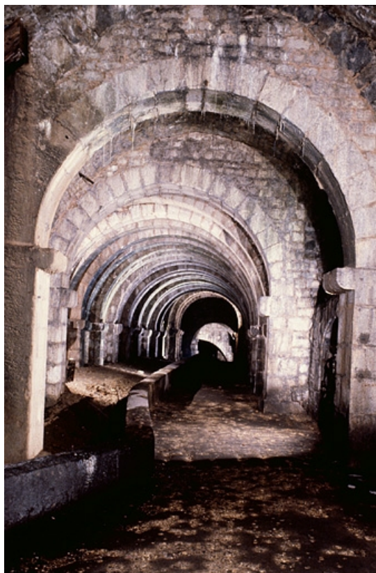
La galerie souterraine voûtée depuis le puits d'Amont.
