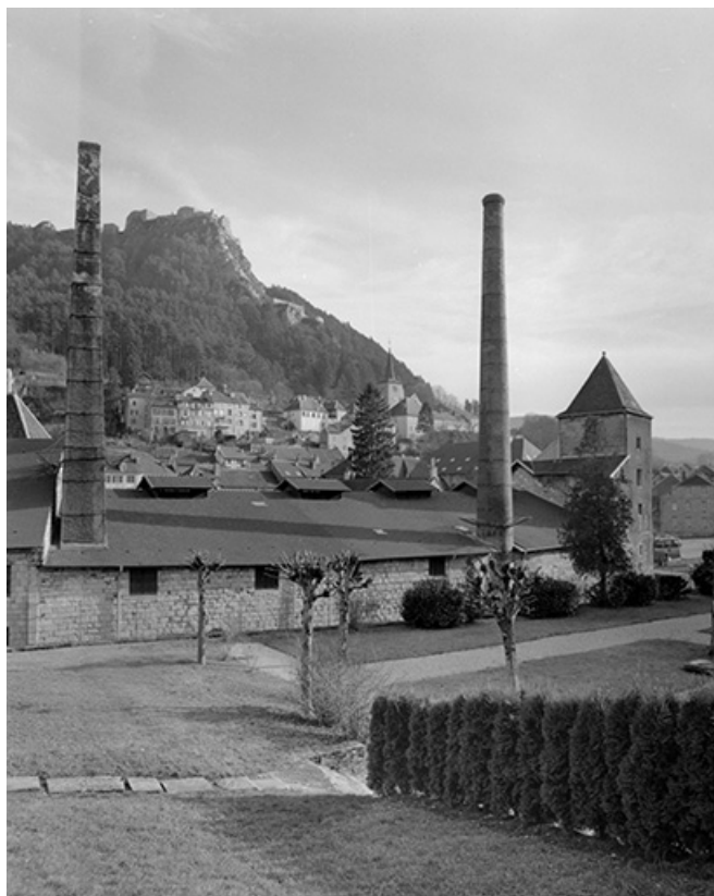
Le bâtiment des poêles vu de l'ouest.
