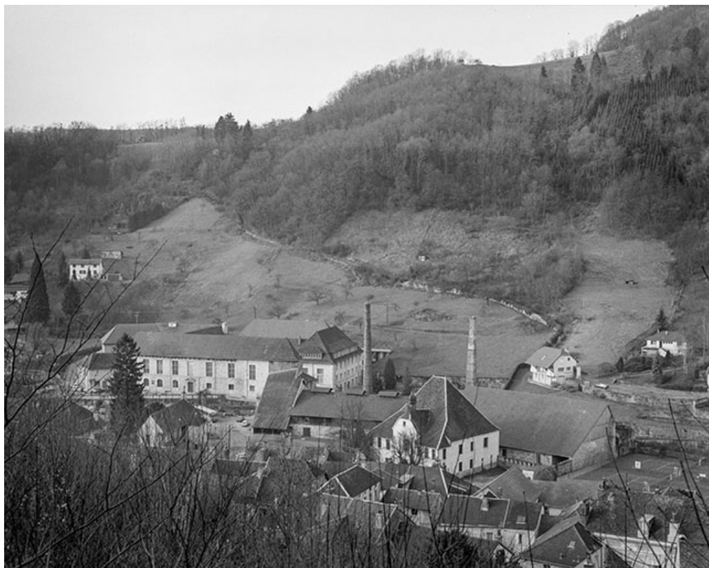
Vue d'ensemble plongeante depuis le nord-est.
