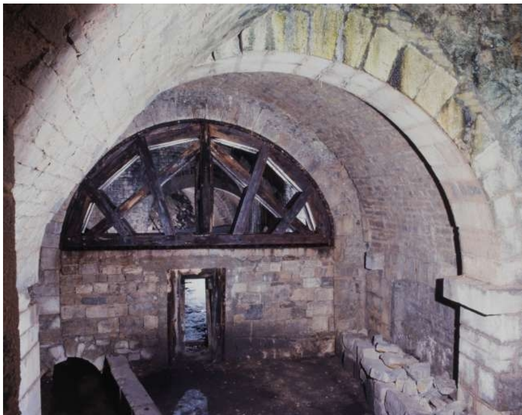
Puits à Grès : mur et cintre de soutènement.
