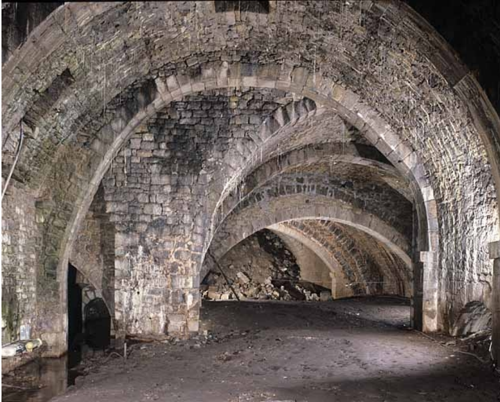
Le puits à Grès avant déblaiement.
