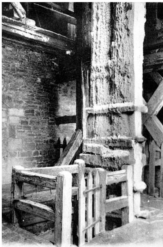
Salins-les-Bains. - Réservoir du Tripot. 39, Salins-les-Bains place des Salines
