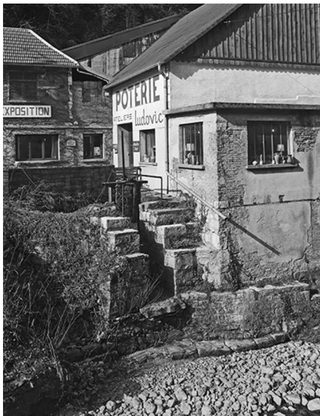
Vannage et déversoir du canal d'aménée.
