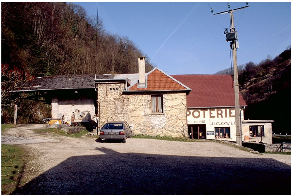
De gauche à droite : pièce de séchage, transformateur, salle des machines, atelier de fabrication et bâtiment d'eau. 39, Salins-les-Bains, lieudit : le Martinet du Bas
