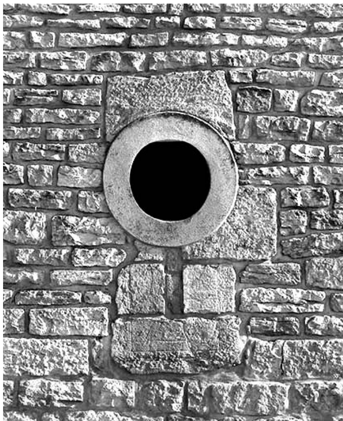
Oculus. Cette ouverture a succédé à une baie fromagère verticale. 39, Clucy rue du Fort Belin
