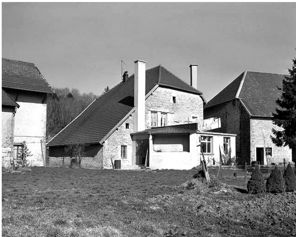
Façade postérieure depuis le sud-est.
