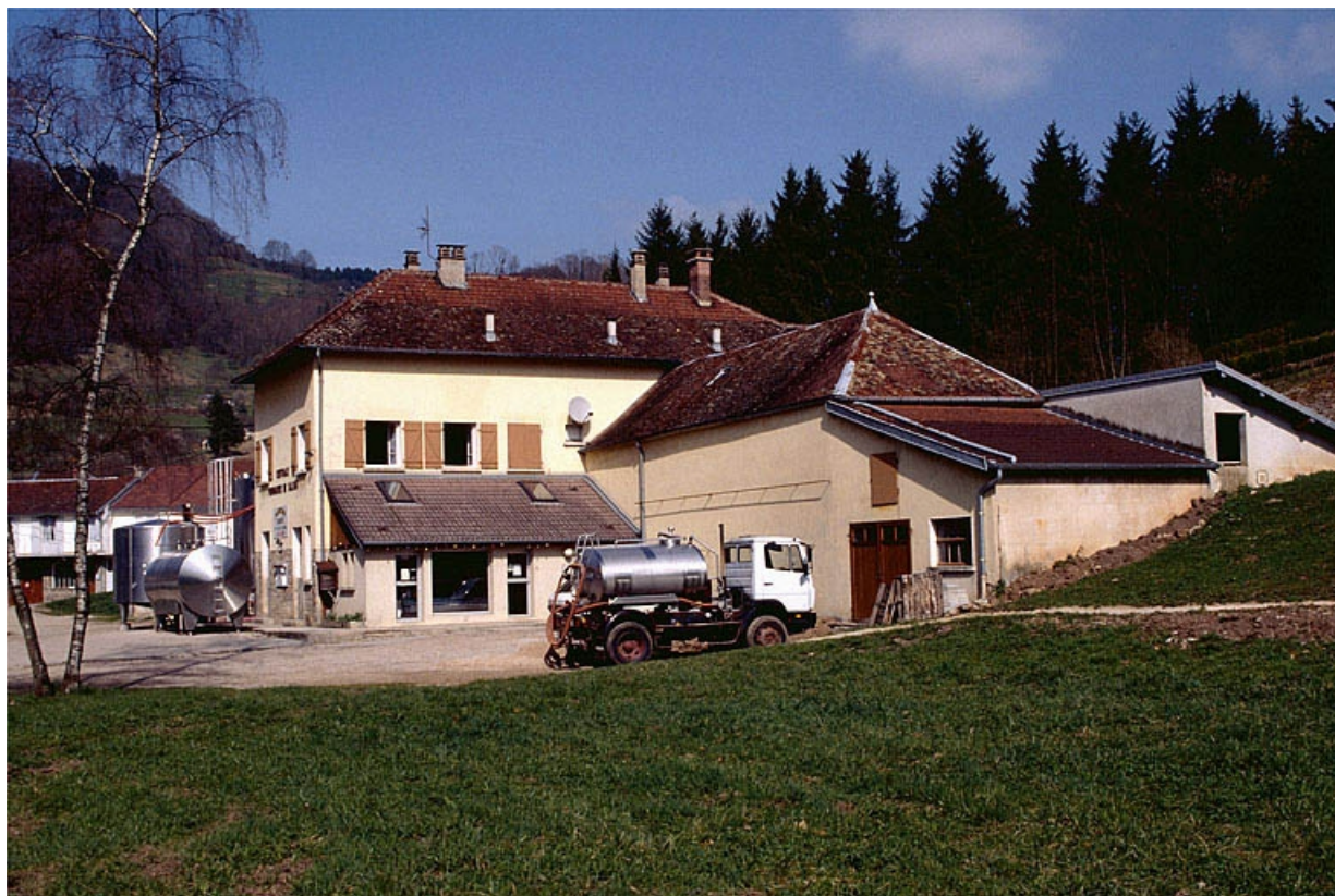
Atelier de fabrication et pièces d'affinage depuis le sud-ouest.
