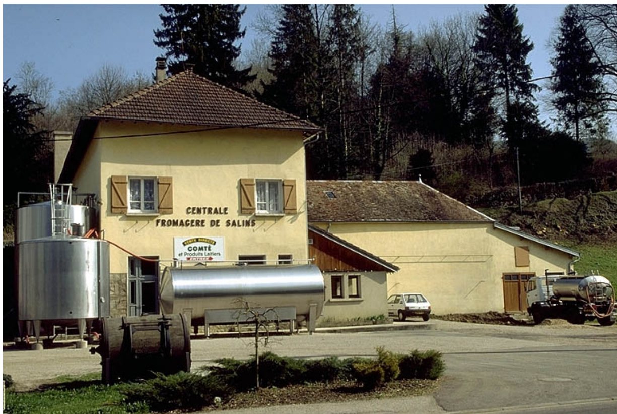
Façade antérieure depuis la route.
