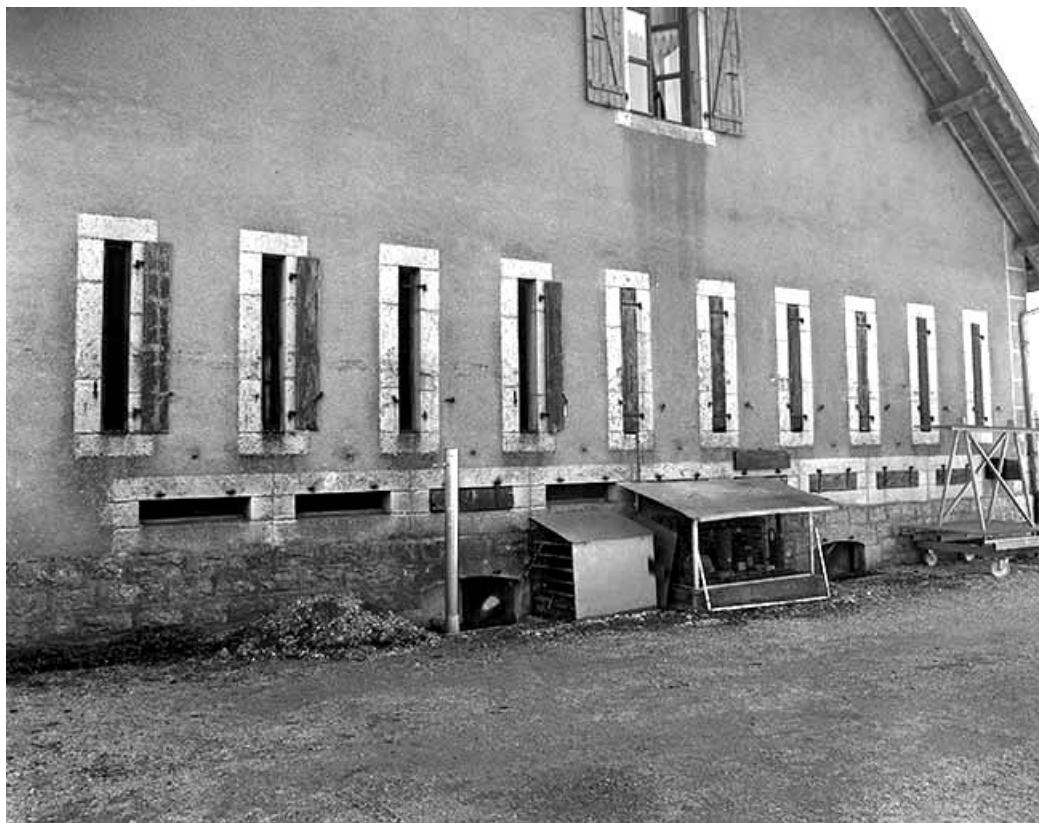
Façade latérale. Baies fromagères de la chambre à lait.
