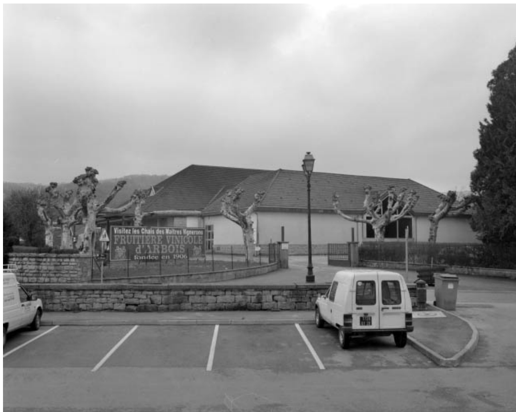
Vue d'ensemble de la nouvelle coopérative vinicole.
