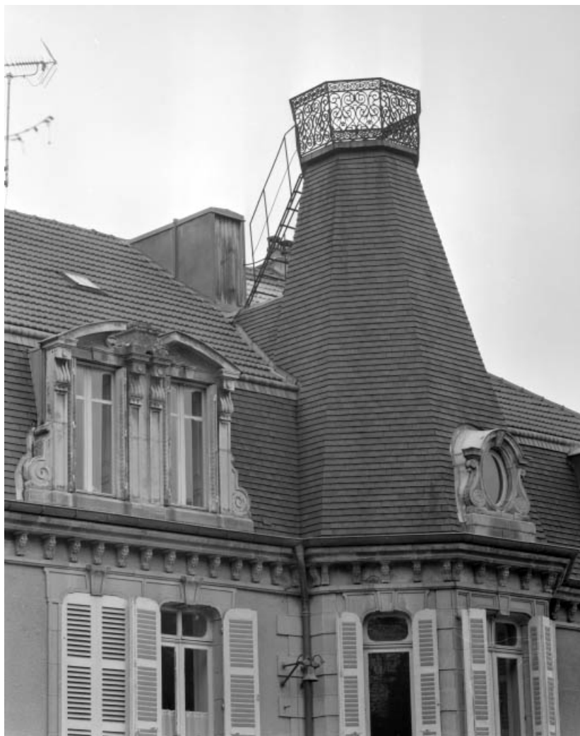
Château Béthanie : toiture de la tourelle d'escalier.
