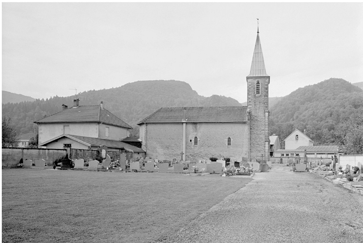
Vue de situation depuis le nord.
