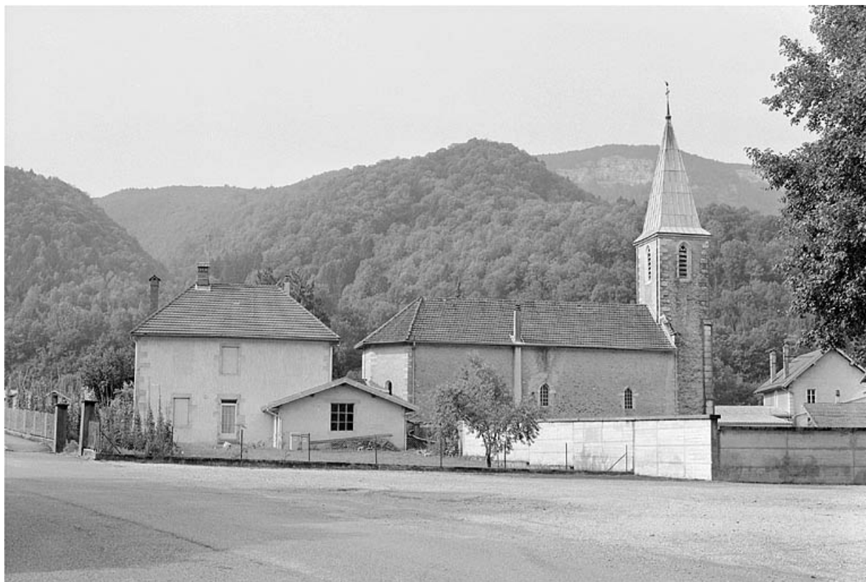
Vue de situation depuis le nord-est.
