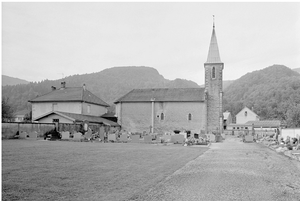
Vue de situation depuis le nord.
