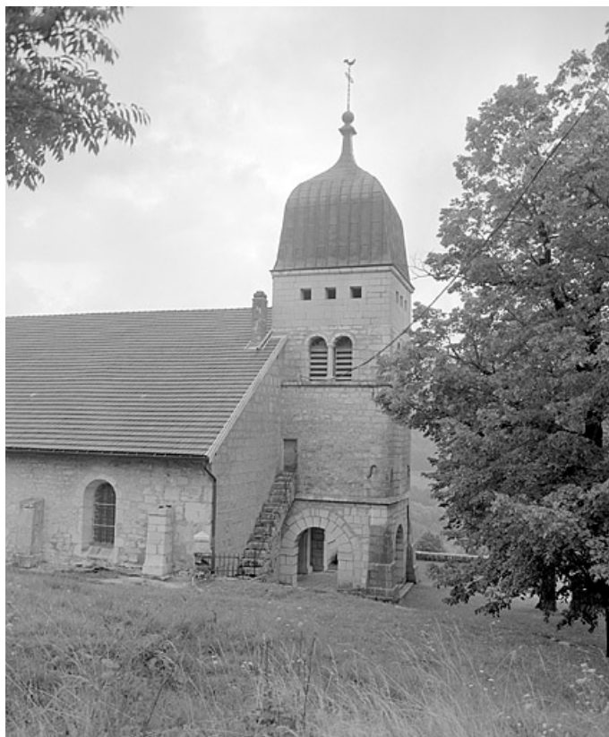
Face nord de la tour-clocher.
