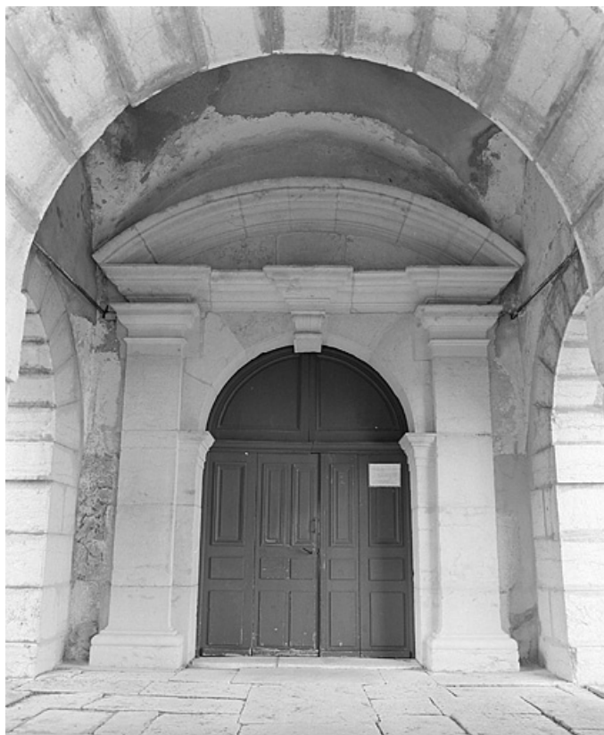
Le portail d'entrée de la nef.
