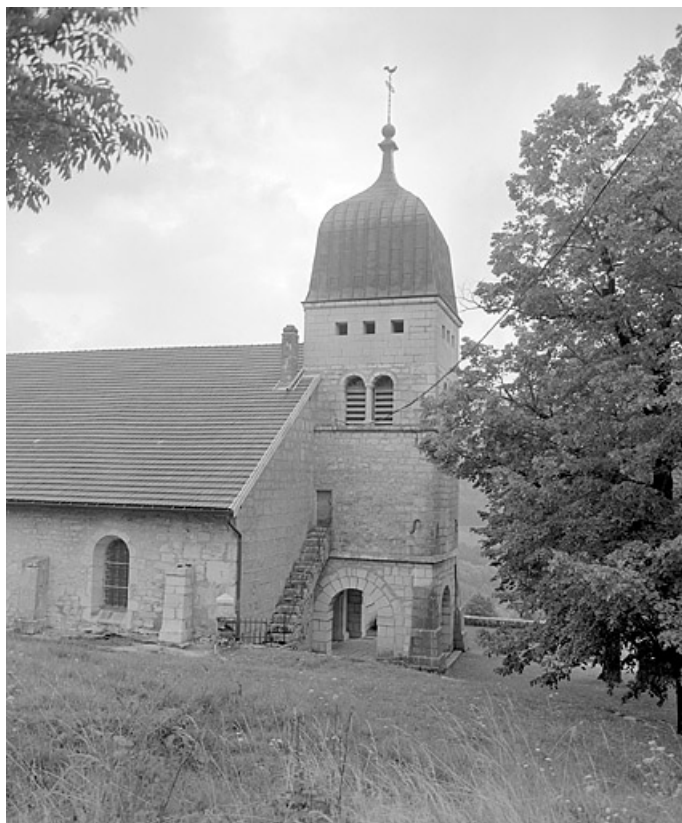
Face nord de la tour-clocher.
