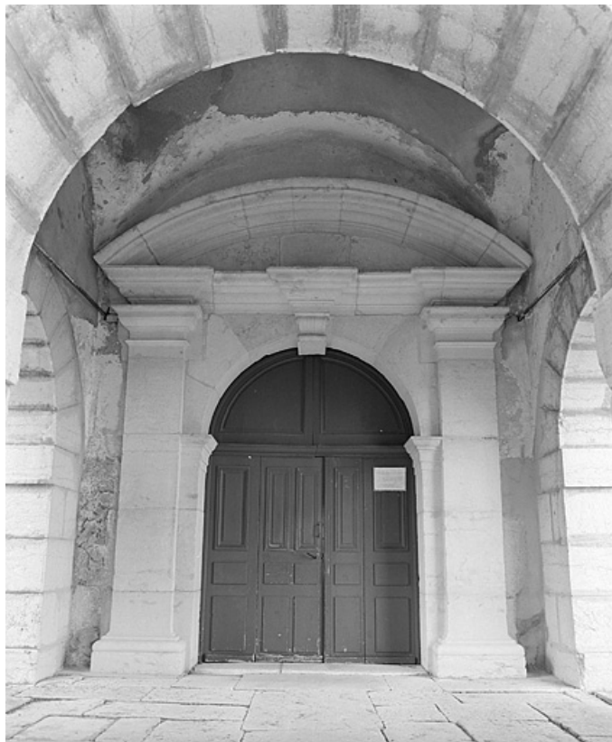
Le portail d'entrée de la nef.
