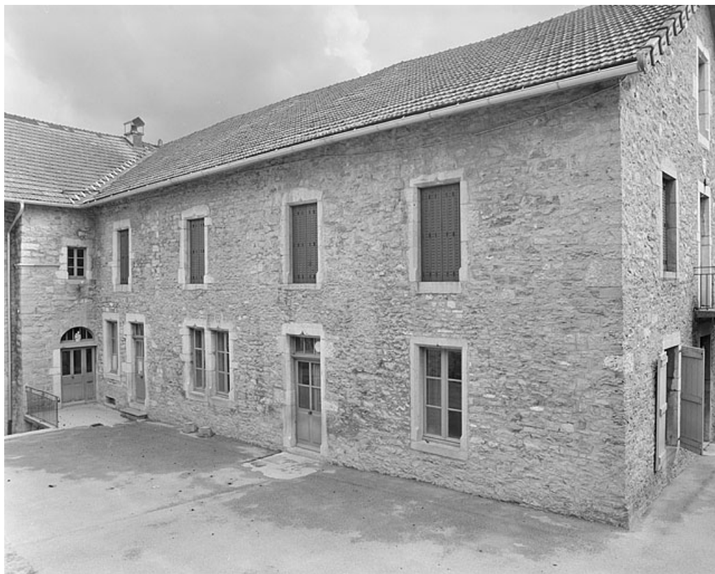
Façade sur cour de l'aile droite du prieuré.
