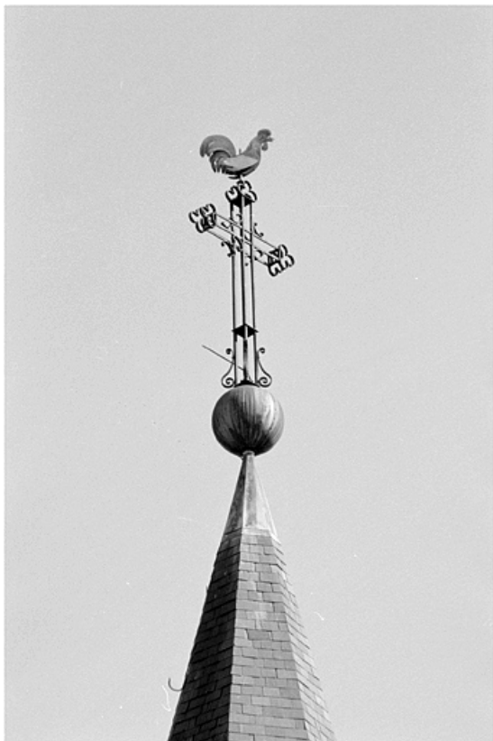
Clocher : détail du sommet de la flèche.
