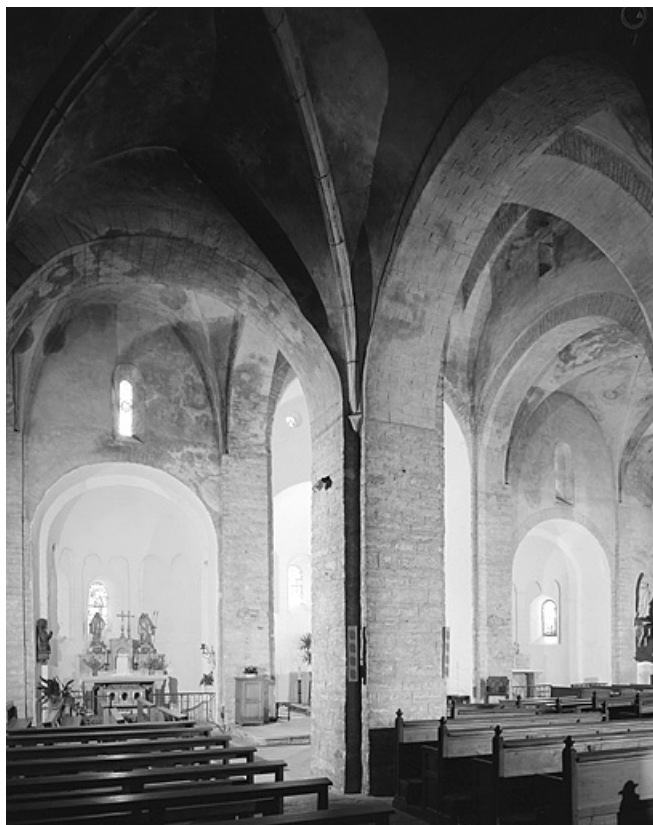
Les absidioles de l'église vues depuis le bas-côté nord. 39, Saint-Lupicin
