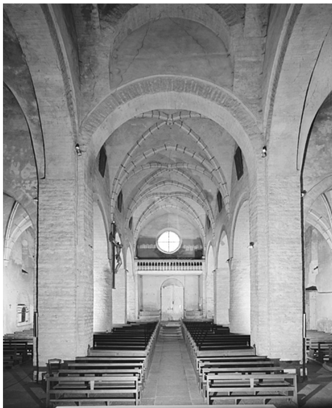
Le vaisseau central de l'église vu depuis la croisée du transept. 39, Saint-Lupicin
