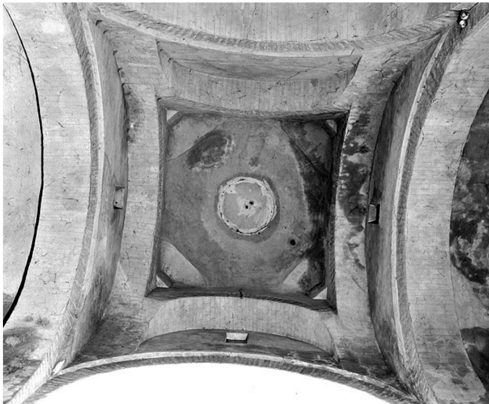
La coupole de la croisée du transept de l'église. 39, Saint-Lupicin
