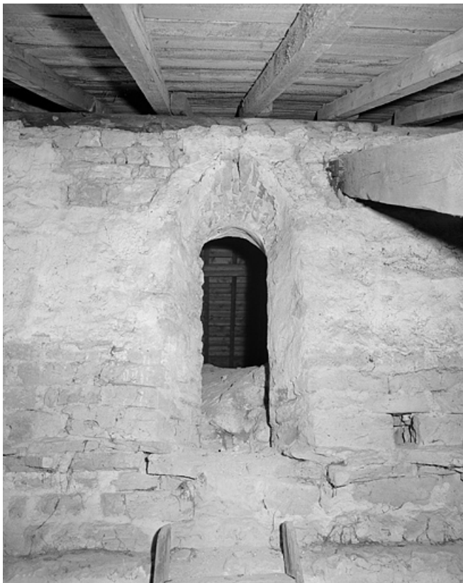
Ancienne baie du vaisseau central, dans les combles de l'église. 39, Saint-Lupicin
