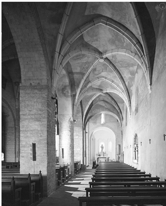
Le bas-côté sud de l'église vu depuis l'ouest.
