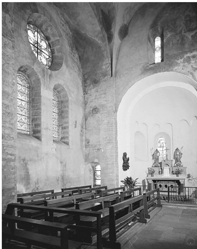
L'absidiole nord et le mur nord du transept de l'église.
