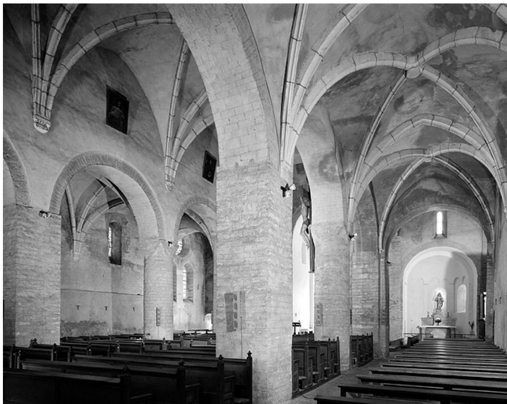
Élévation intérieure nord de l'église vue depuis le bas-côté sud. 39, Saint-Lupicin
