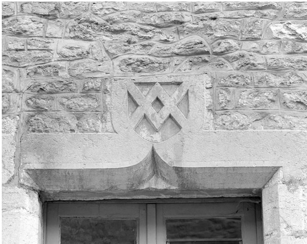
Armoiries au-dessus d'une fenêtre du prieuré.
