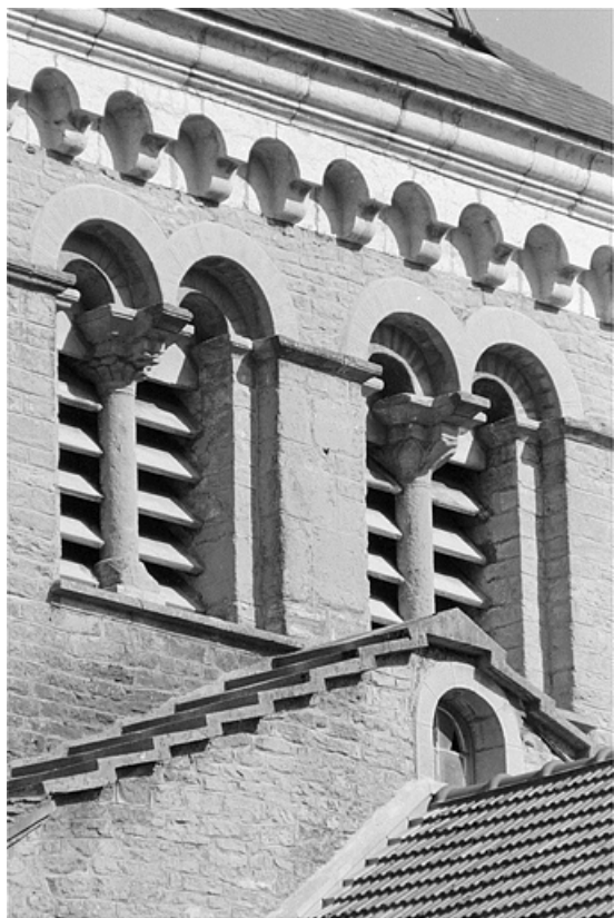
Clocher : détail des baies de la face ouest (vue verticale). 39, Saint-Lupicin
