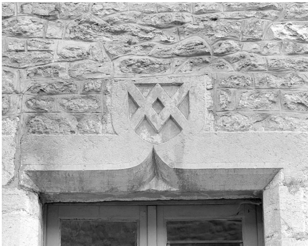
Armoiries au-dessus d'une fenêtre du prieuré.
