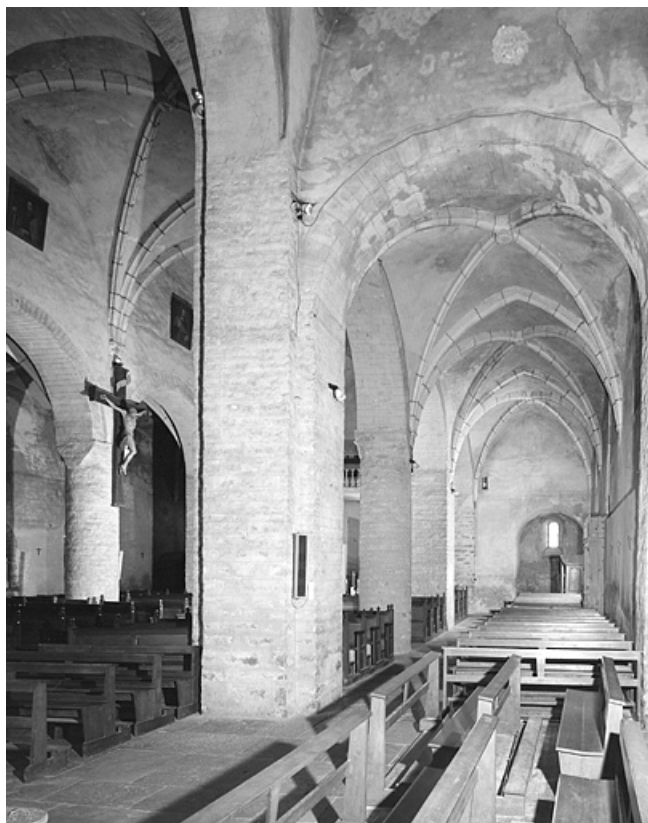
Le bas-côté nord de l'église vu depuis le transept.
