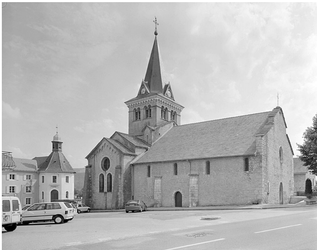
Face latérale nord de l'église.
