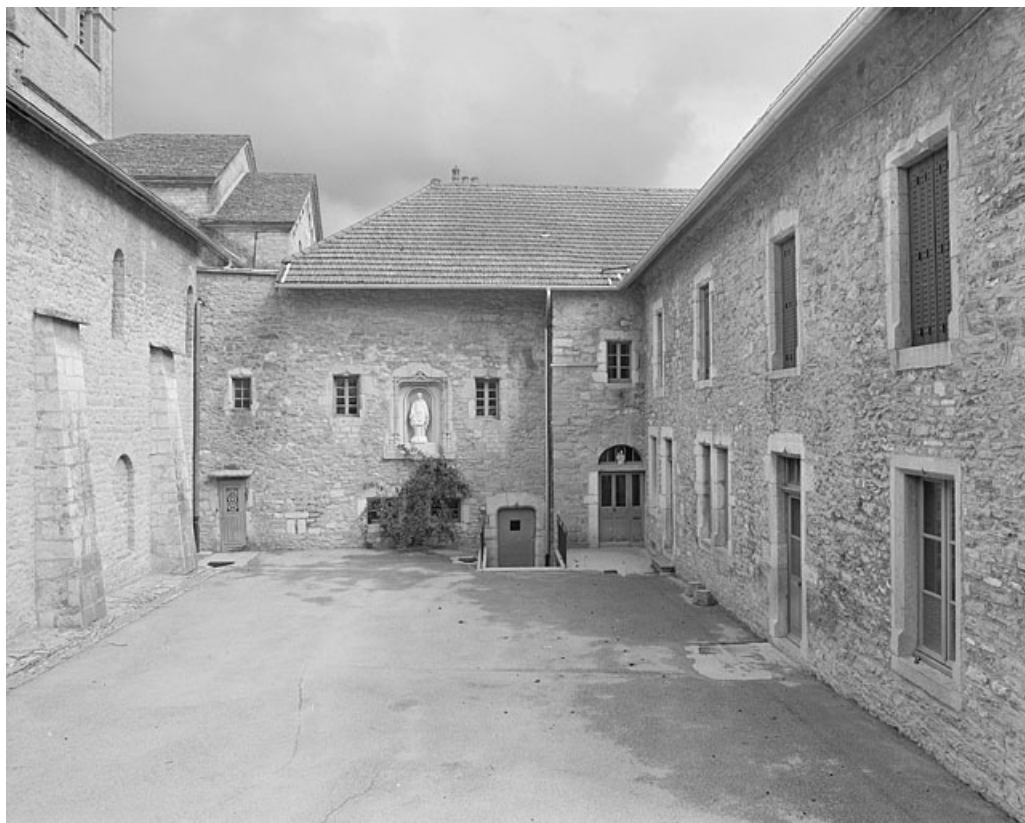
Façade ouest du prieuré.
