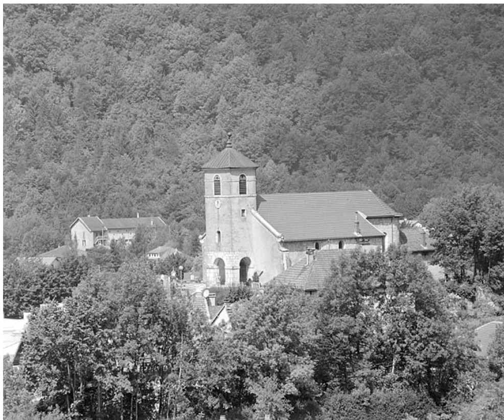
Vue de situation depuis le sud-ouest. 39, Molinges
