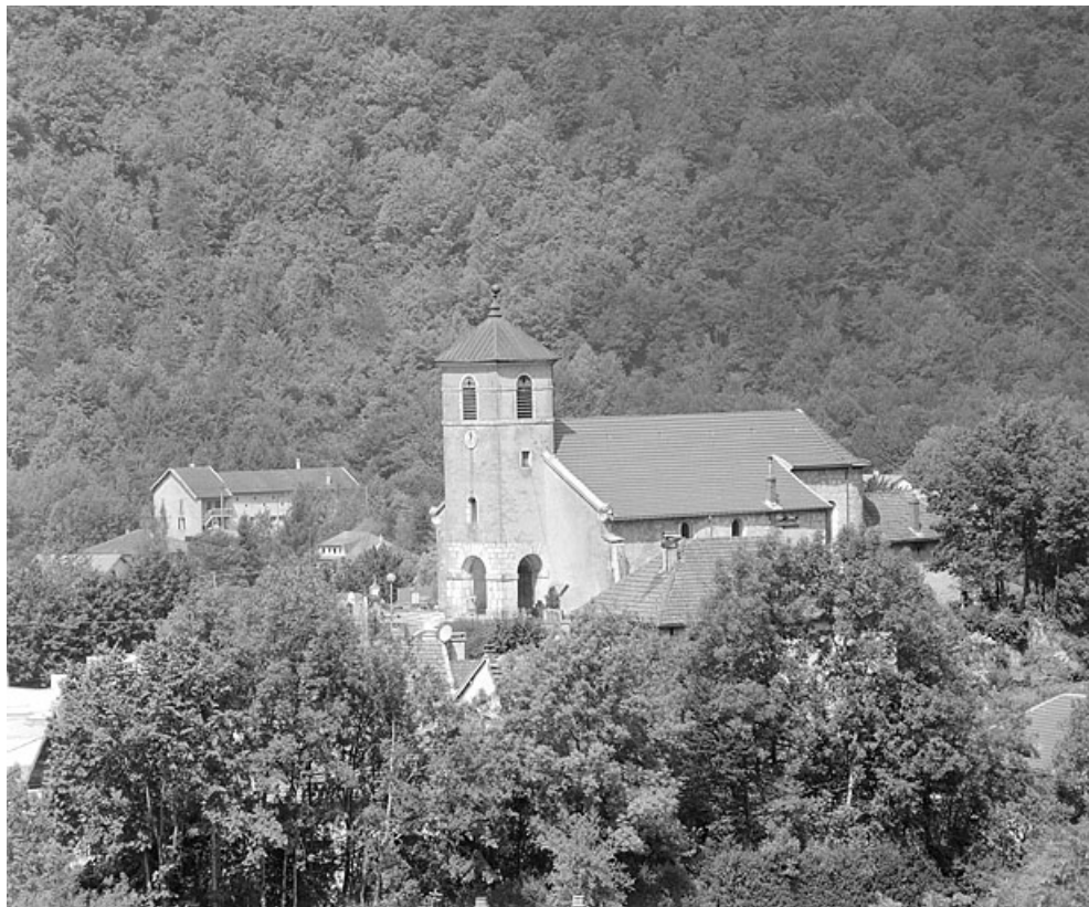
Vue de situation depuis le sud-ouest. 39, Molinges
