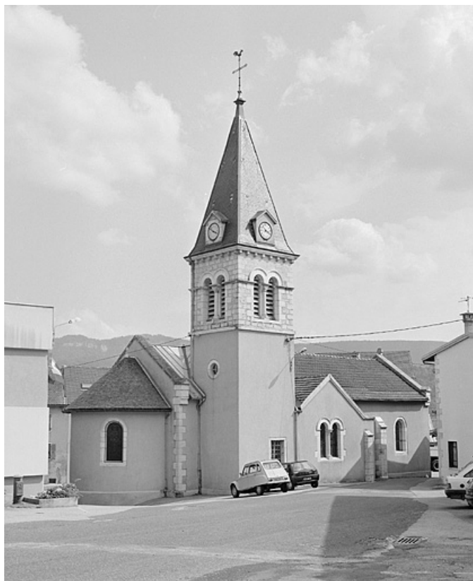
Face nord et abside.
