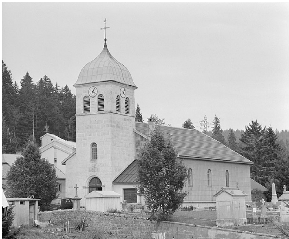
Façade ouest et face sud.
