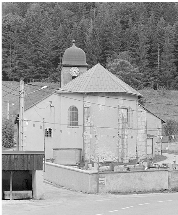
Le chevet (vue verticale). 39, Lajoux, lieudit : Mijoux
