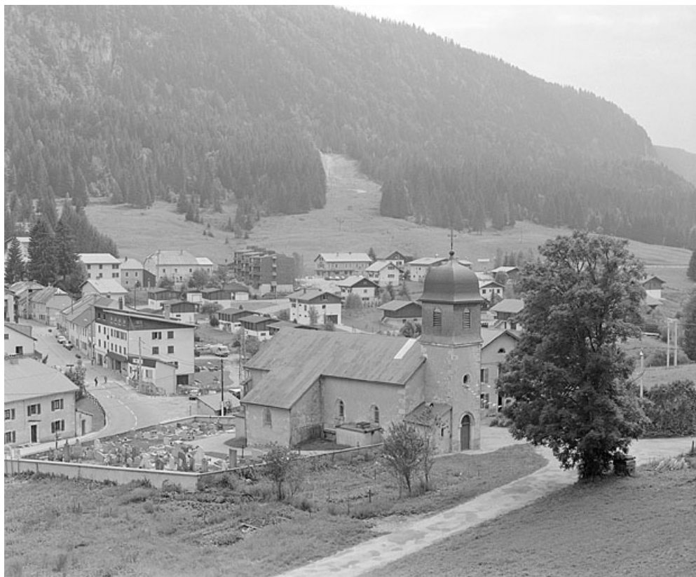
Vue de situation depuis le nord-ouest (vue horizontale).
