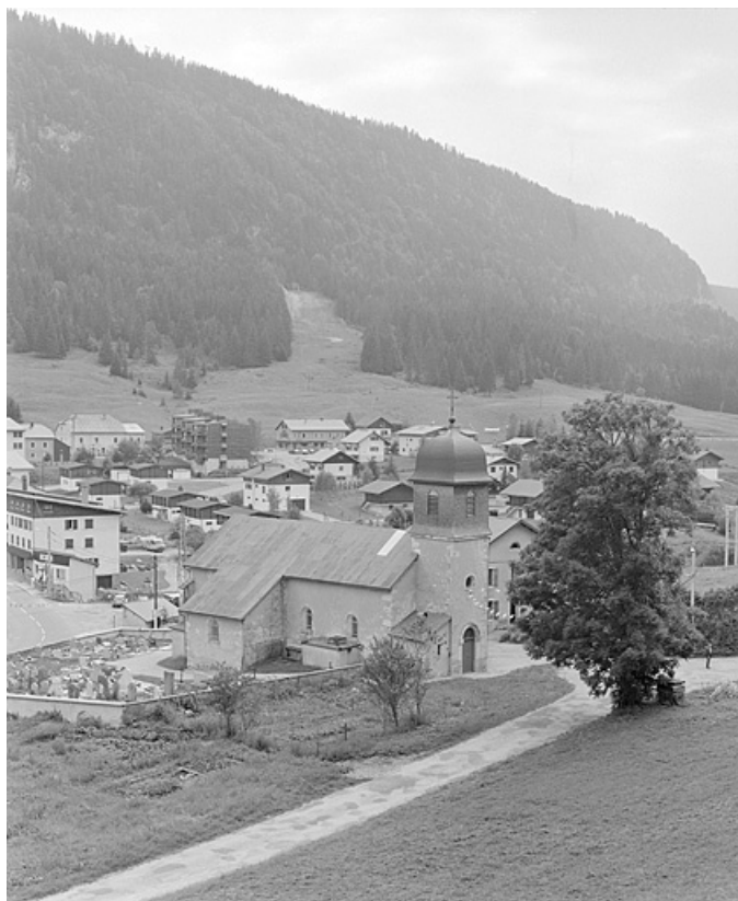
Vue de situation depuis le nord-ouest (vue verticale).
