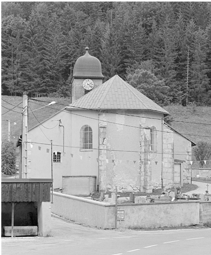
Le chevet (vue verticale). 39, Lajoux, lieudit : Mijoux
