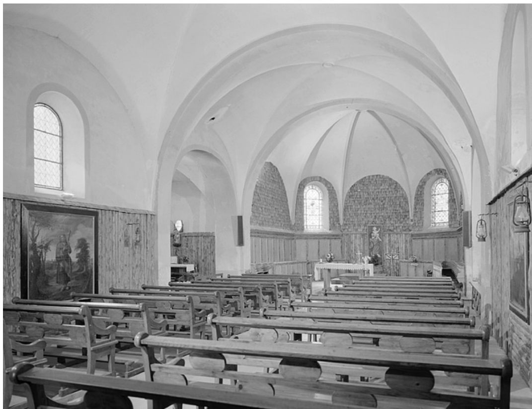
Élévation nord de la nef et du chœur vue depuis l'angle sud-ouest.
