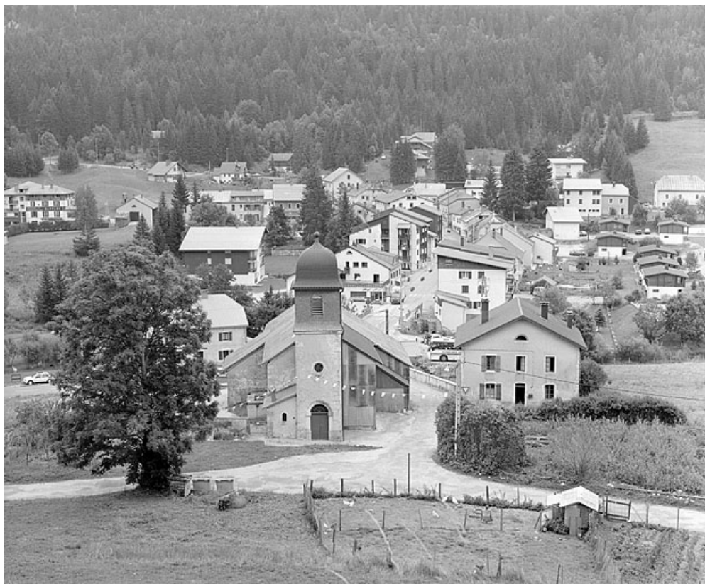
Vue de situation depuis l'ouest (vue horizontale).
