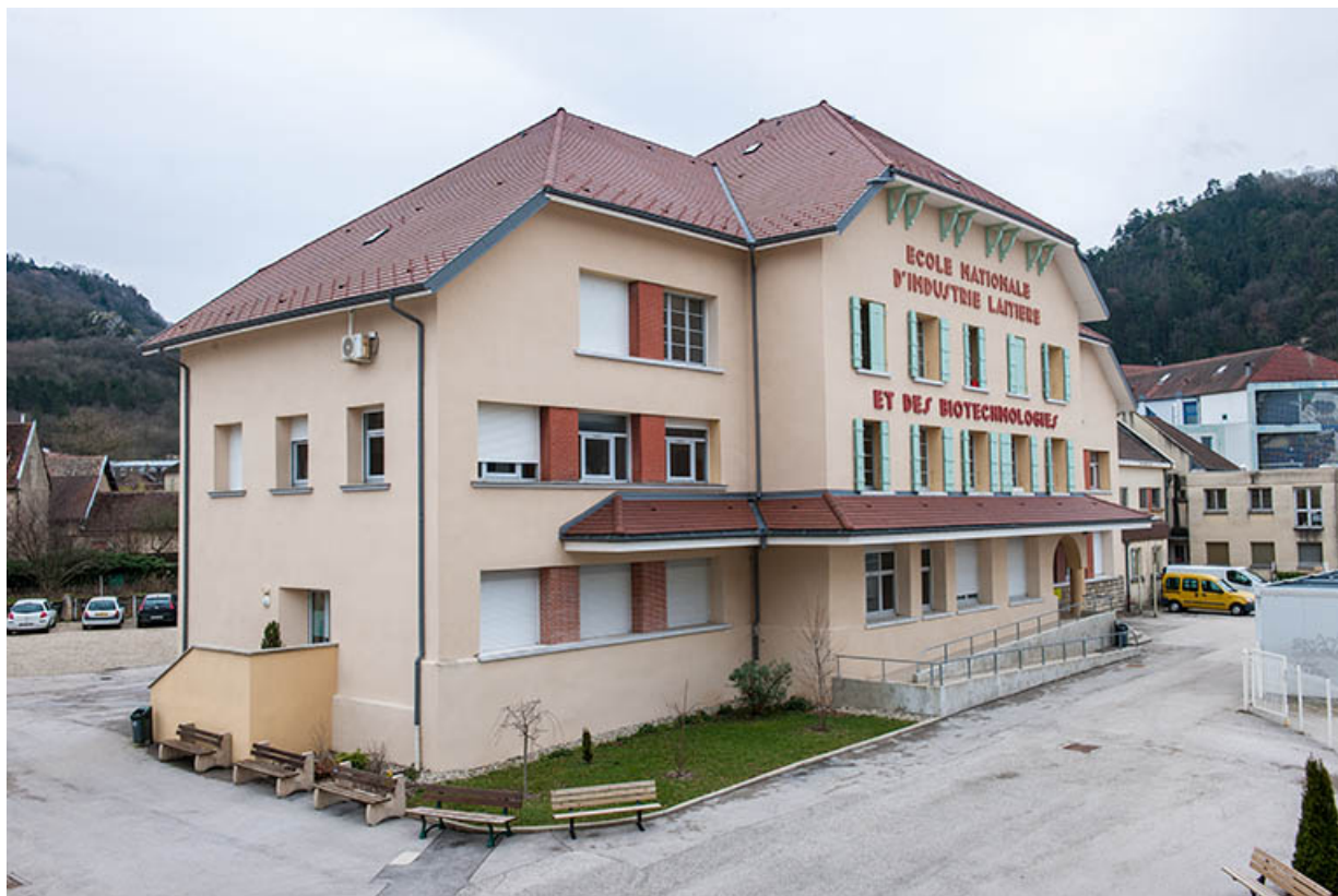
Façade antérieure principale de l'école, angle nord-ouest.
