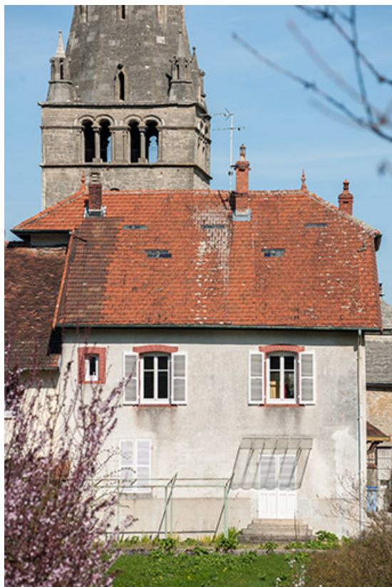
Pignon postérieur de la maison de fonction, 9 place Notre Dame. 05, Poligny rue du Champ de Foire
