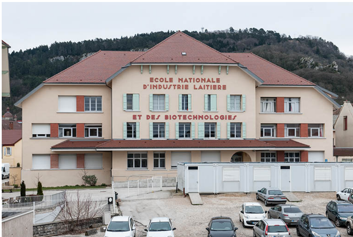
Façade antérieure ouest de l'école.
