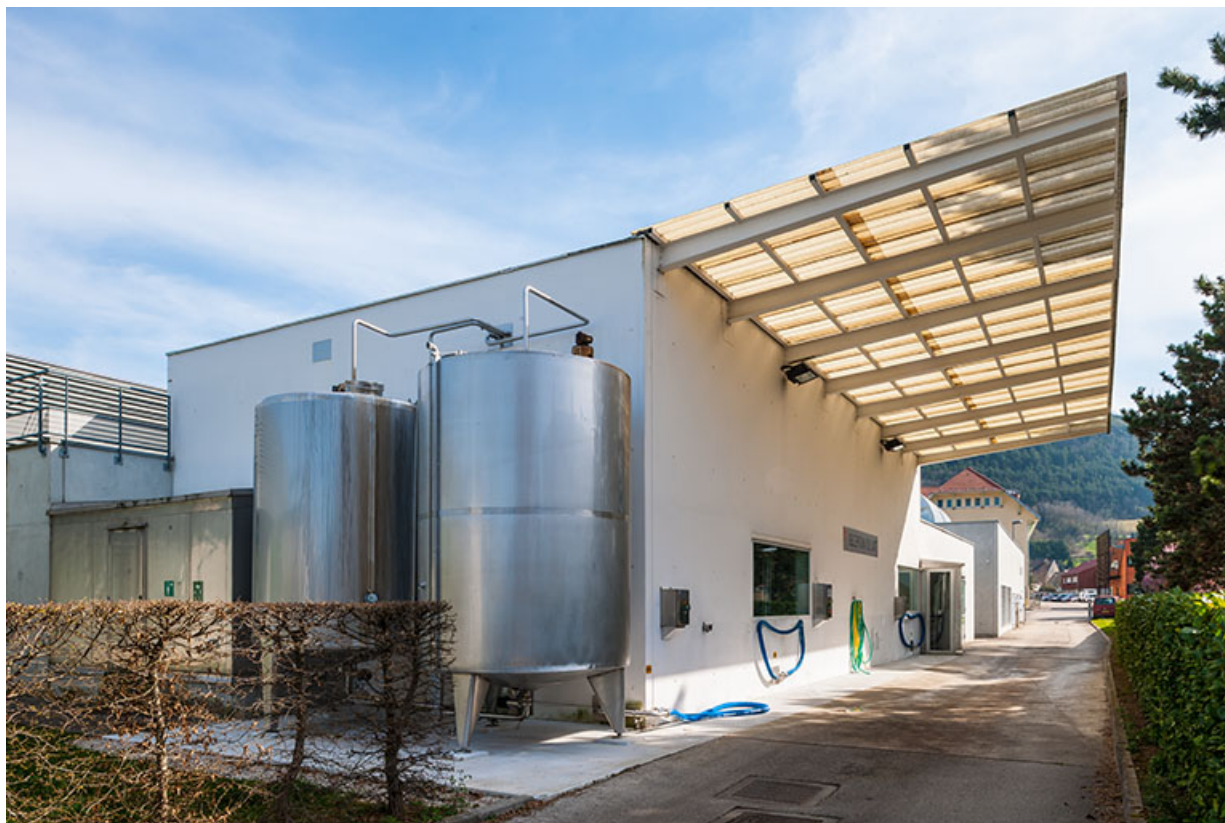
Angle nord-ouest de la halle de génie alimentaire.
