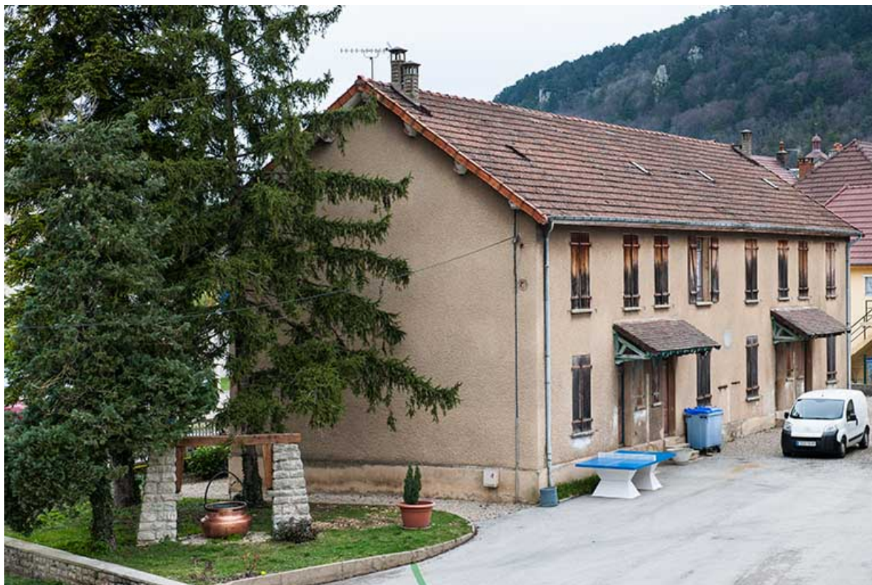
Chaudière à potence devant le pignon ouest de l'annexe (atelier logement). 05, Poligny rue du Champ de Foire
