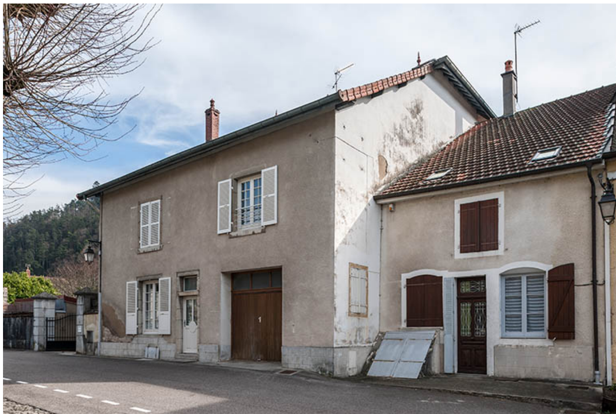
Angle nord-ouest de la façade sur rue de la maison de fonction, 9 place Notre Dame. 39, Poligny rue du Champ de Foire
