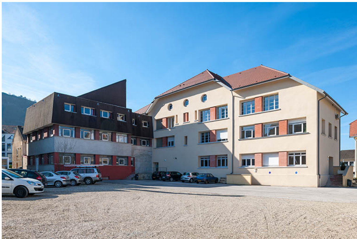
Cour intérieure, angle nord-est de l'école et façade nord de l'extension est. 05, Poligny rue du Champ de Foire
