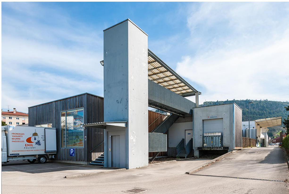
Tour d'ascenseur sur la face postérieure nord de la halle de génie alimentaire. 39, Poligny rue du Champ de Foire
