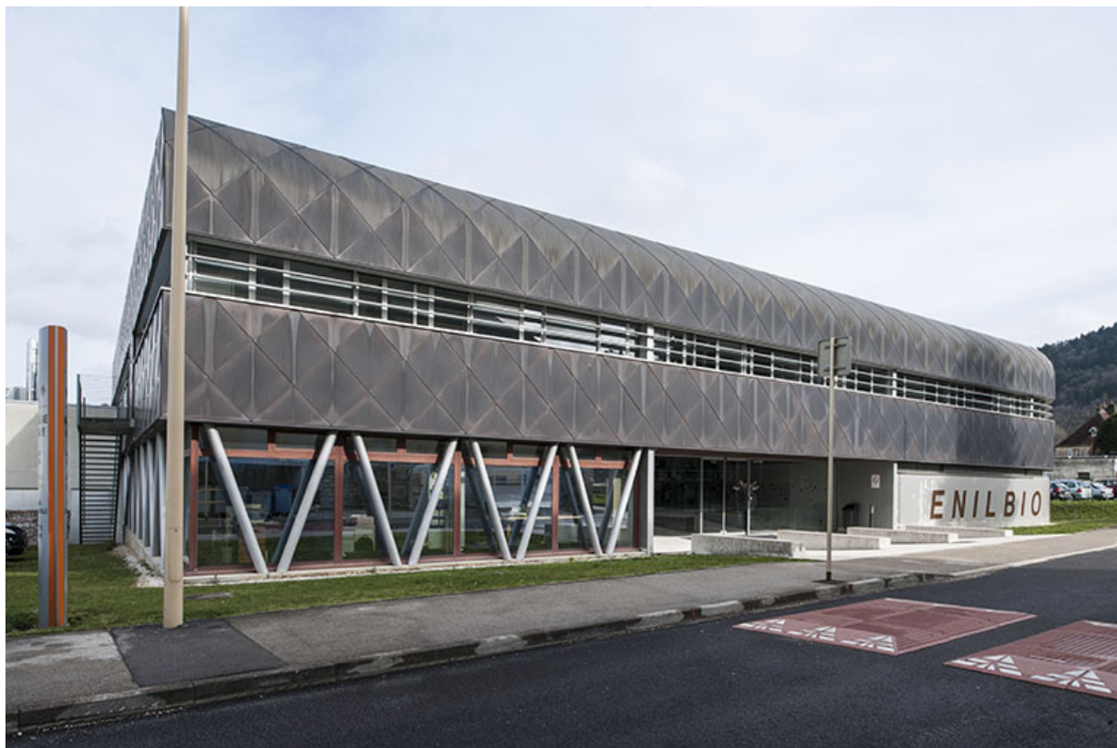
Façade d'entrée sud sur rue de la halle de génie alimentaire.
