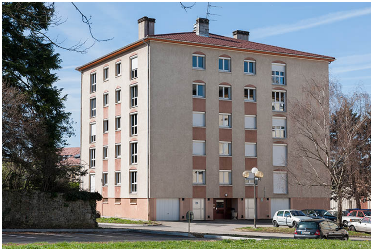
Angle nord-est, entrée du bâtiment des pinsons.
