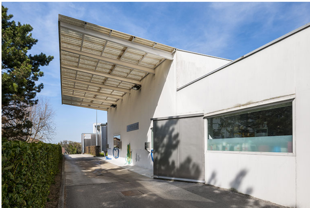
Détail de la façade ouest de la halle de génie alimentaire.
