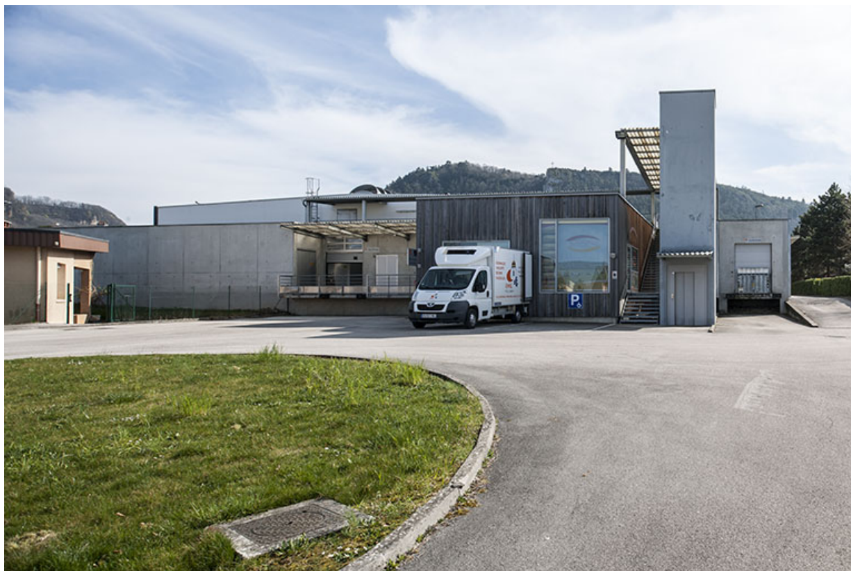
Angle d'une des deux villas de fonction et entrée nord de la halle de génie alimentaire avec sa tour d'ascenseur. 05, Poligny rue du Champ de Foire
