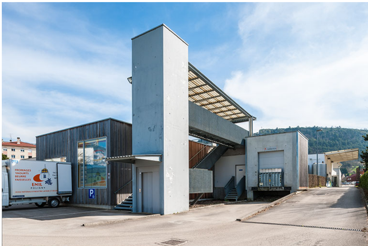
Tour d'ascenseur sur la face postérieure nord de la halle de génie alimentaire. 05, Poligny rue du Champ de Foire
