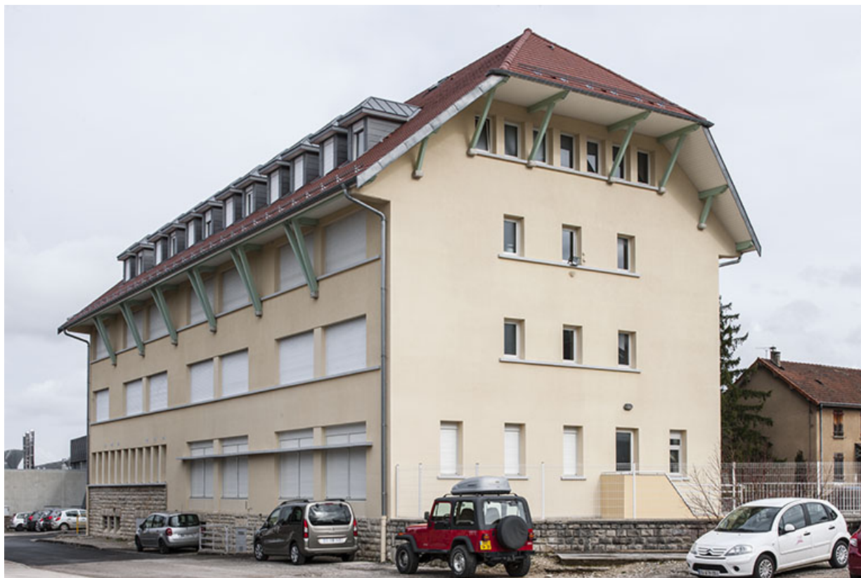
Angle sud-ouest et pignon sud de l'internat. 05, Poligny rue du Champ de Foire
