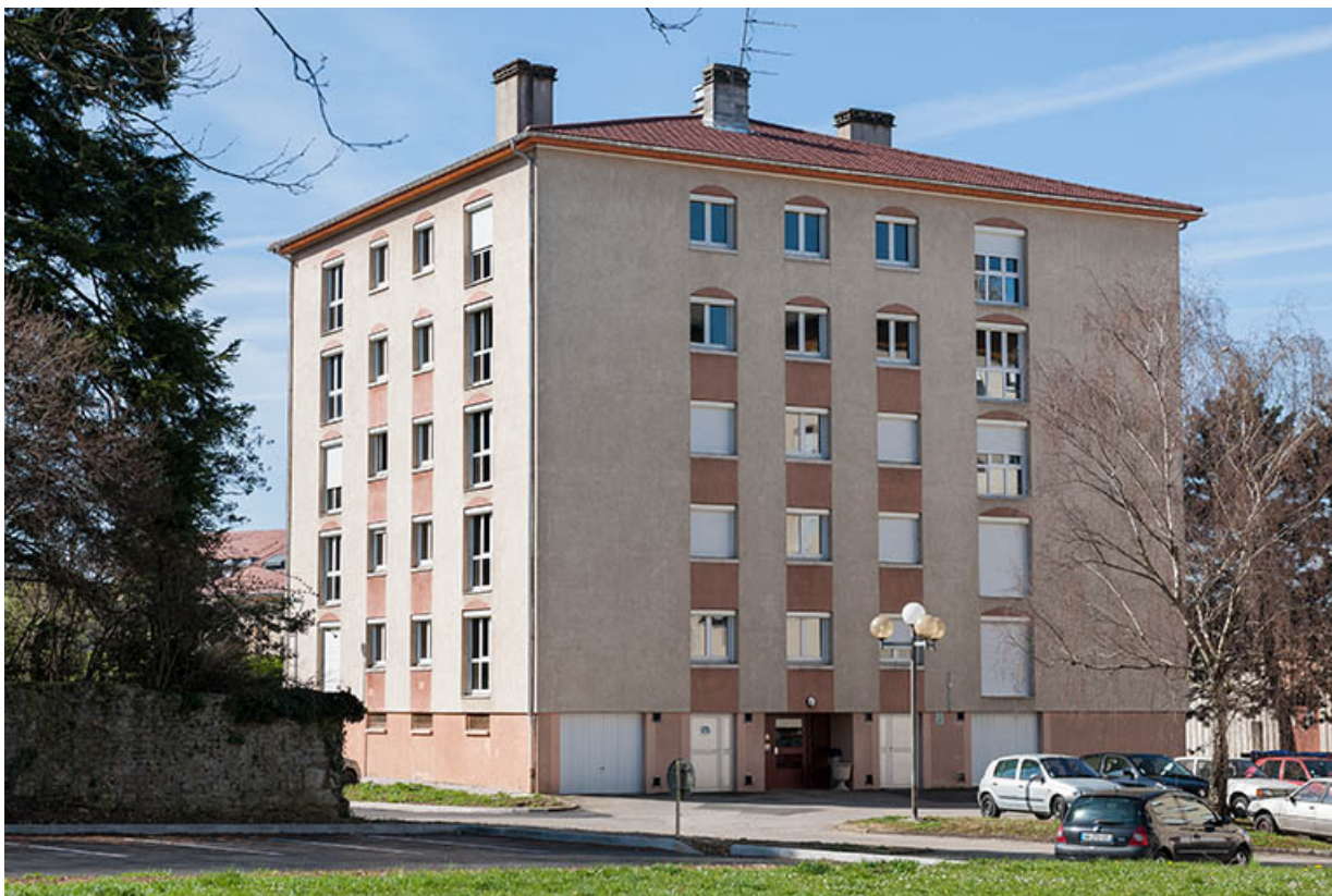
Angle nord-est, entrée du bâtiment des pinsons.
