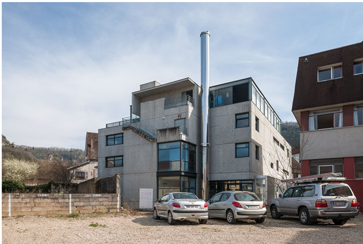
Façade nord de l'extension est de l'école et pignon nord de Cécailait. 05, Poligny rue du Champ de Foire
