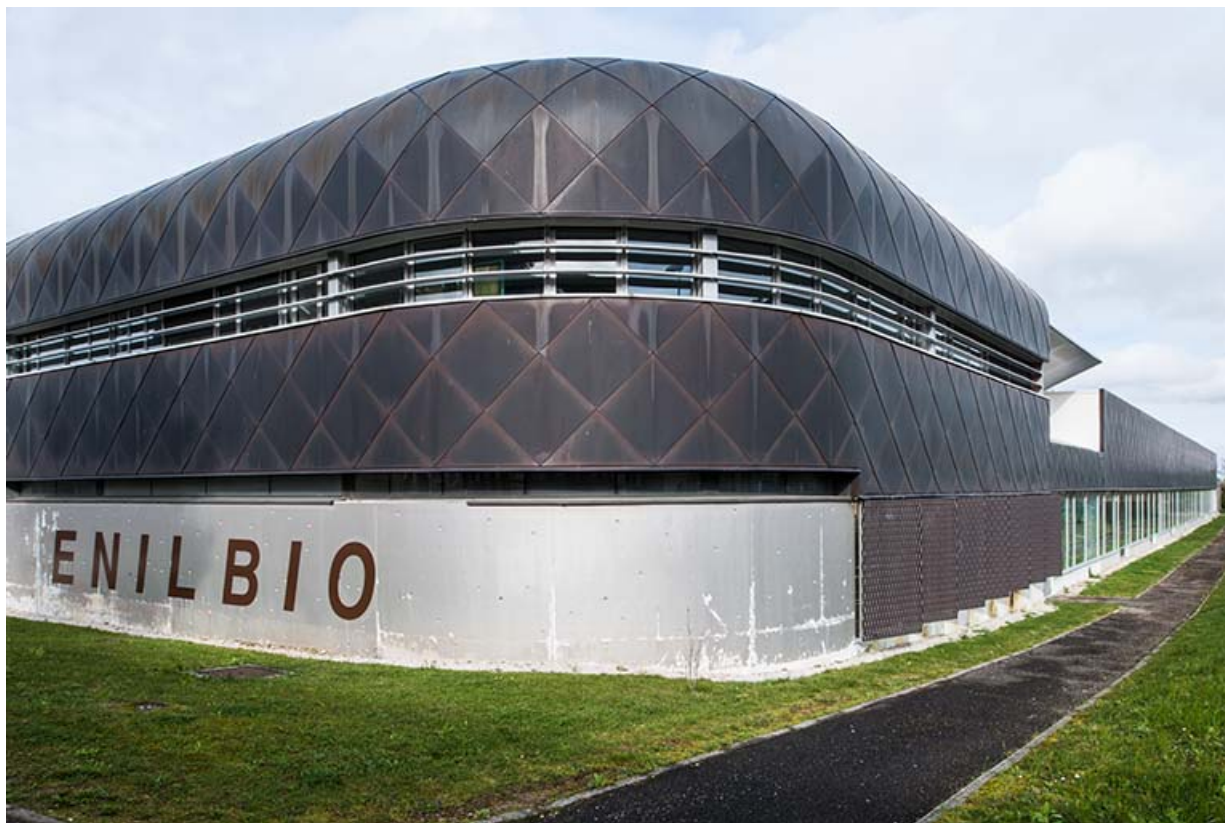
Angle sud-est et façade orientale de la halle de génie alimentaire.
