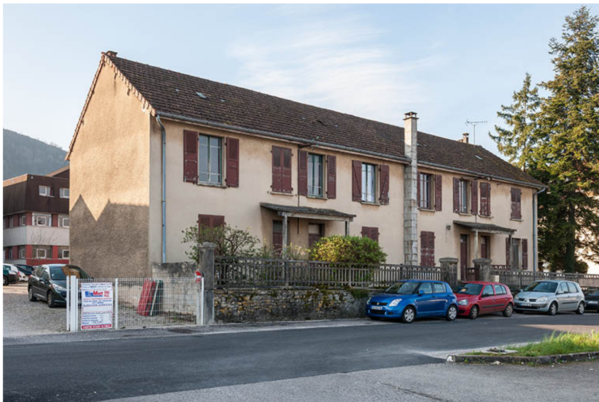
Façade antérieure nord de l'annexe (logement, atelier) sur la rue du vieil hôpital. 05, Poligny rue du Champ de Foire
