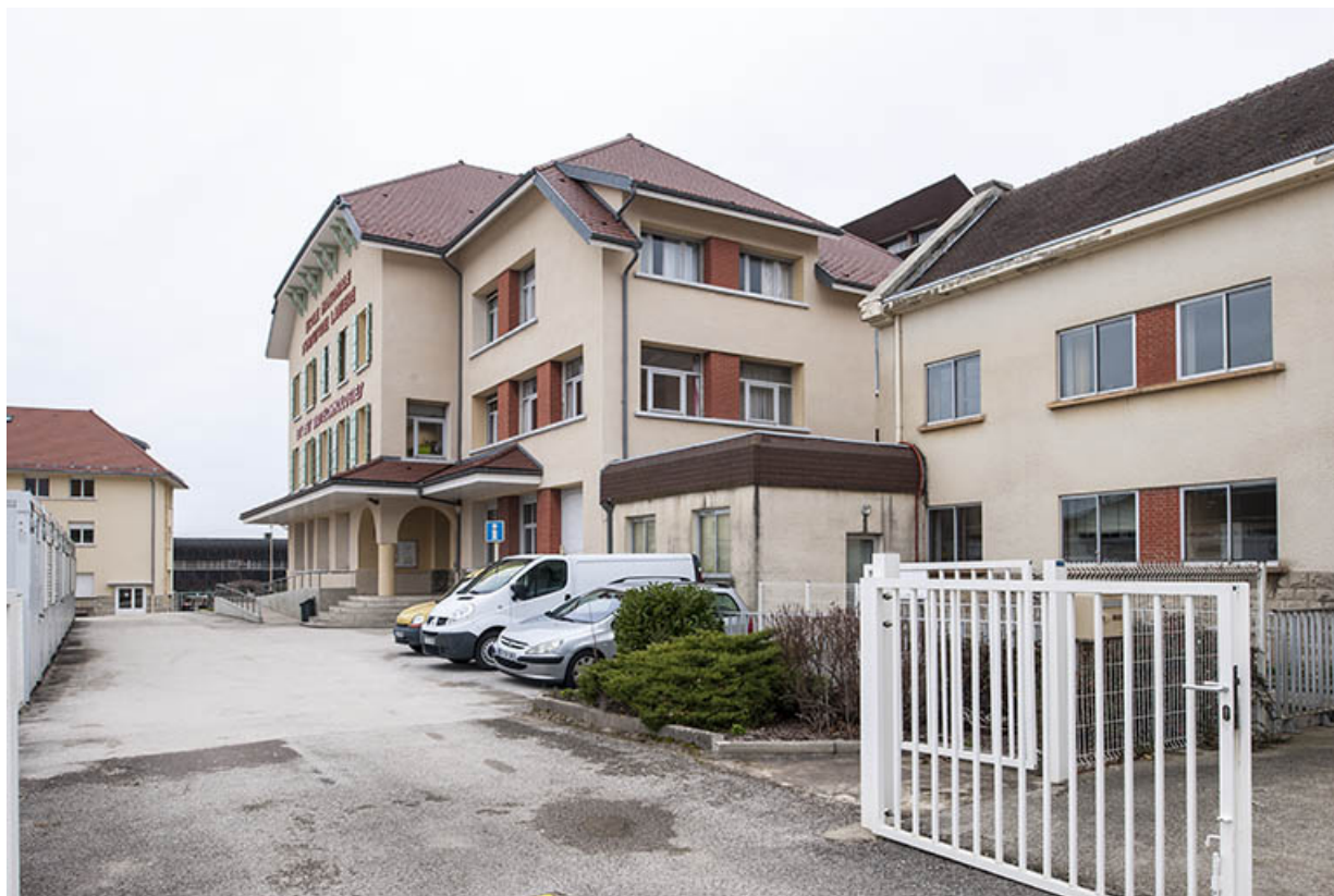
Façade antérieure ouest de l'école.
