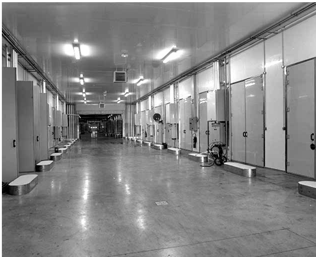
Couloir central des pièces d'affinage.
