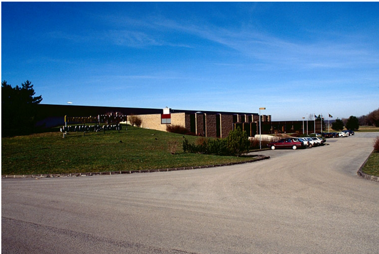
Chaufferie, quai d'expédition et bureaux depuis l'entrée.
