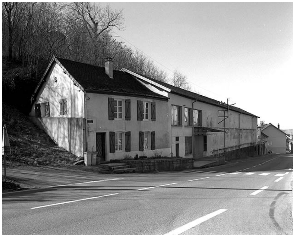
Logement, bureau et atelier de fabrication.
