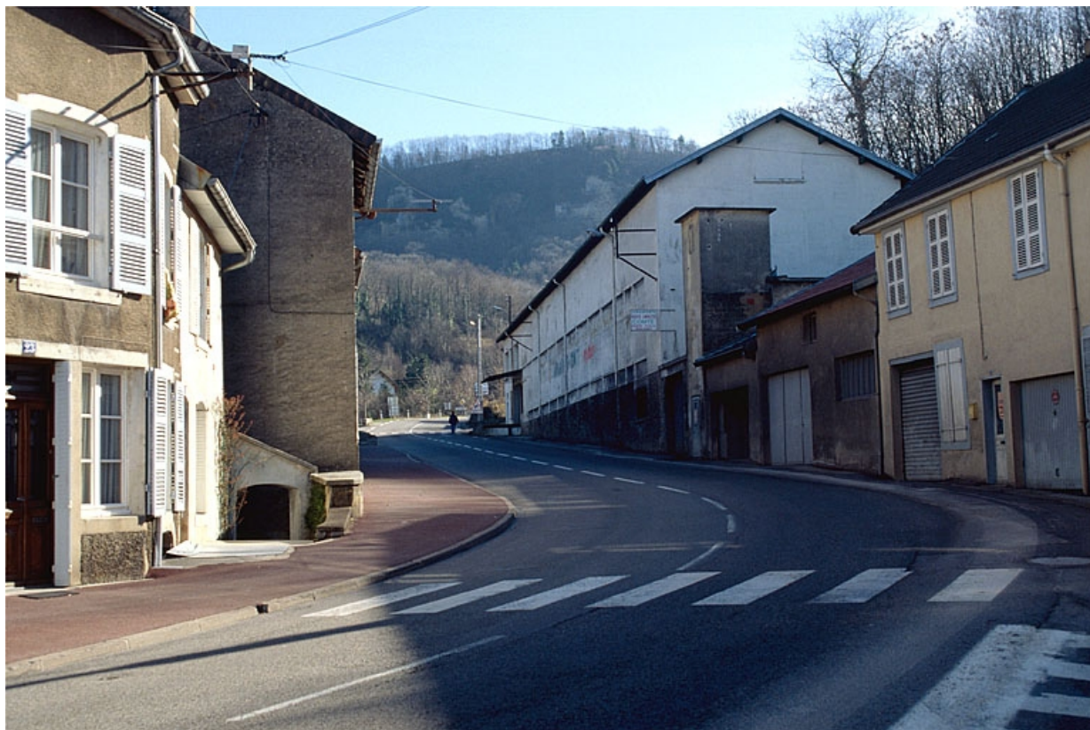
L'atelier de fabrication depuis l'ouest.
