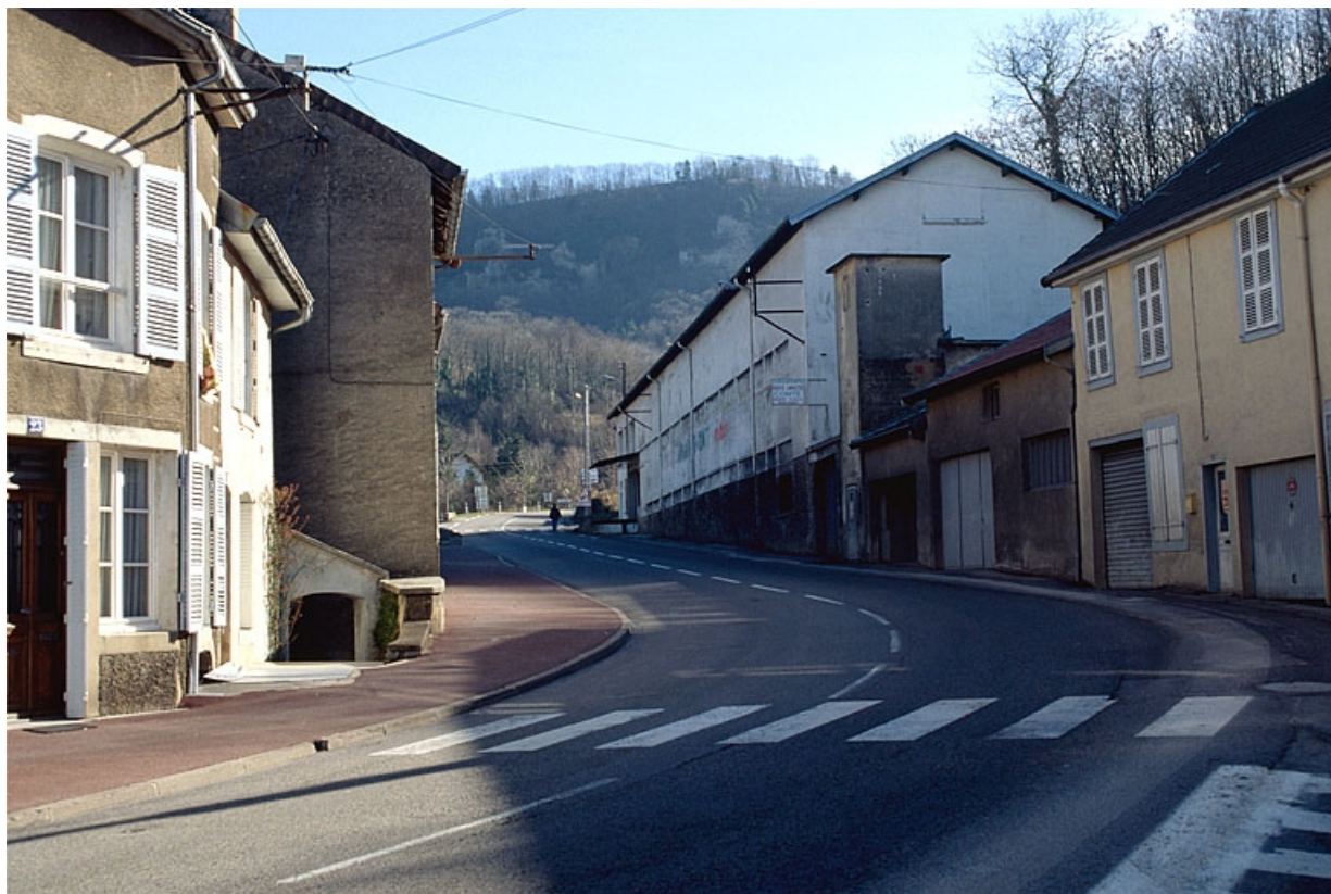
L'atelier de fabrication depuis l'ouest.
