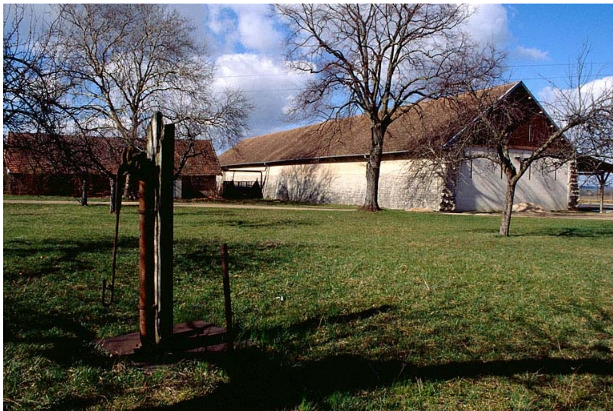
Magasin industriel vu de trois quarts arrière.
