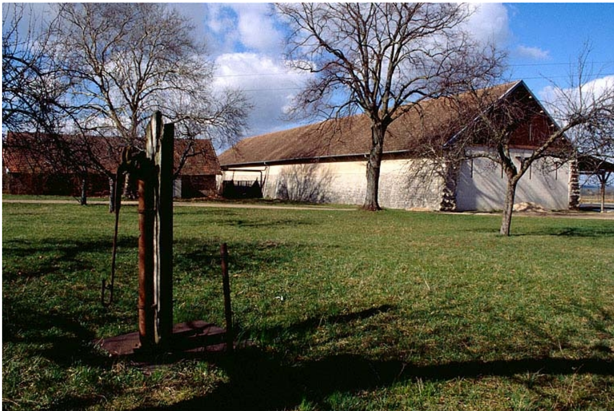
Magasin industriel vu de trois quarts arrière.
