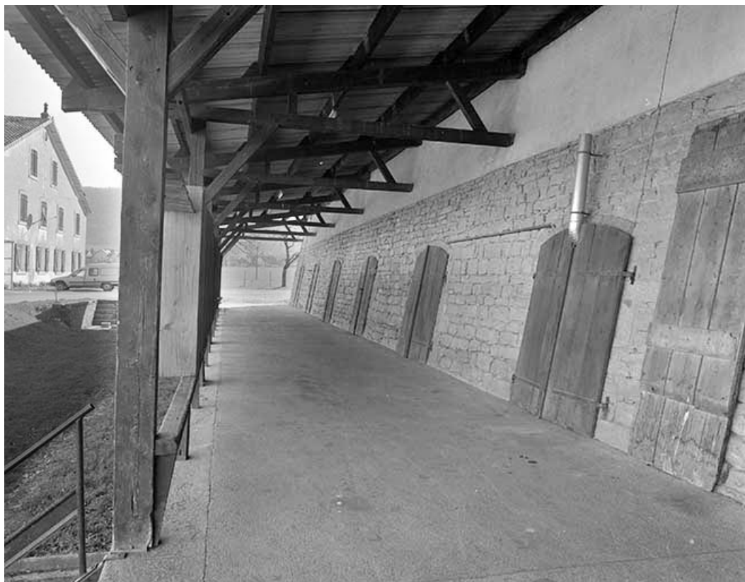
Portes du magasin industriel donnant sur la quai d'expédition.
