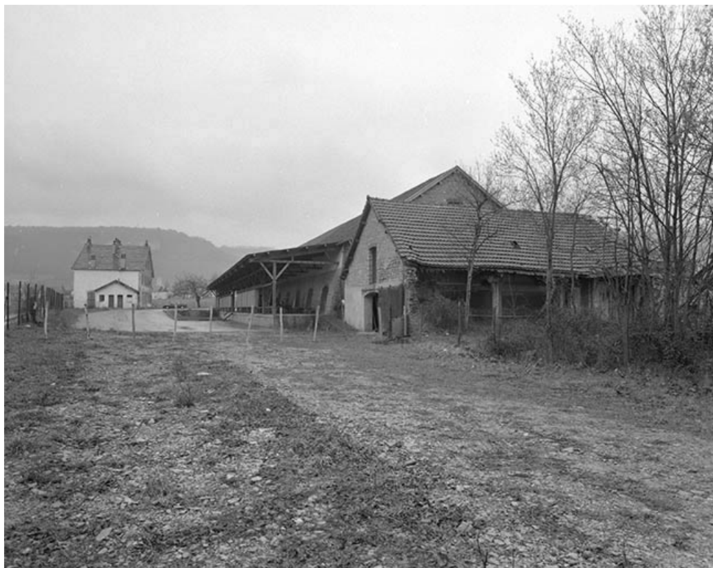
Vue d'ensemble depuis l'ouest.
