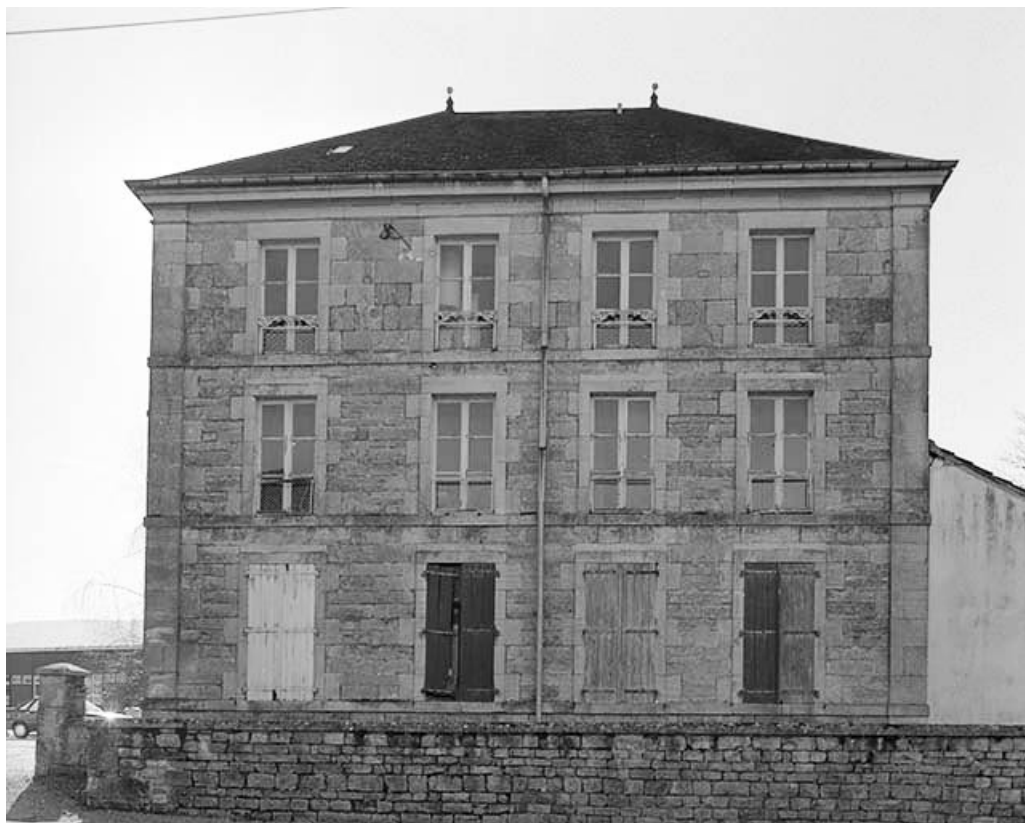
Façade antérieure du logement d'ouvriers.
