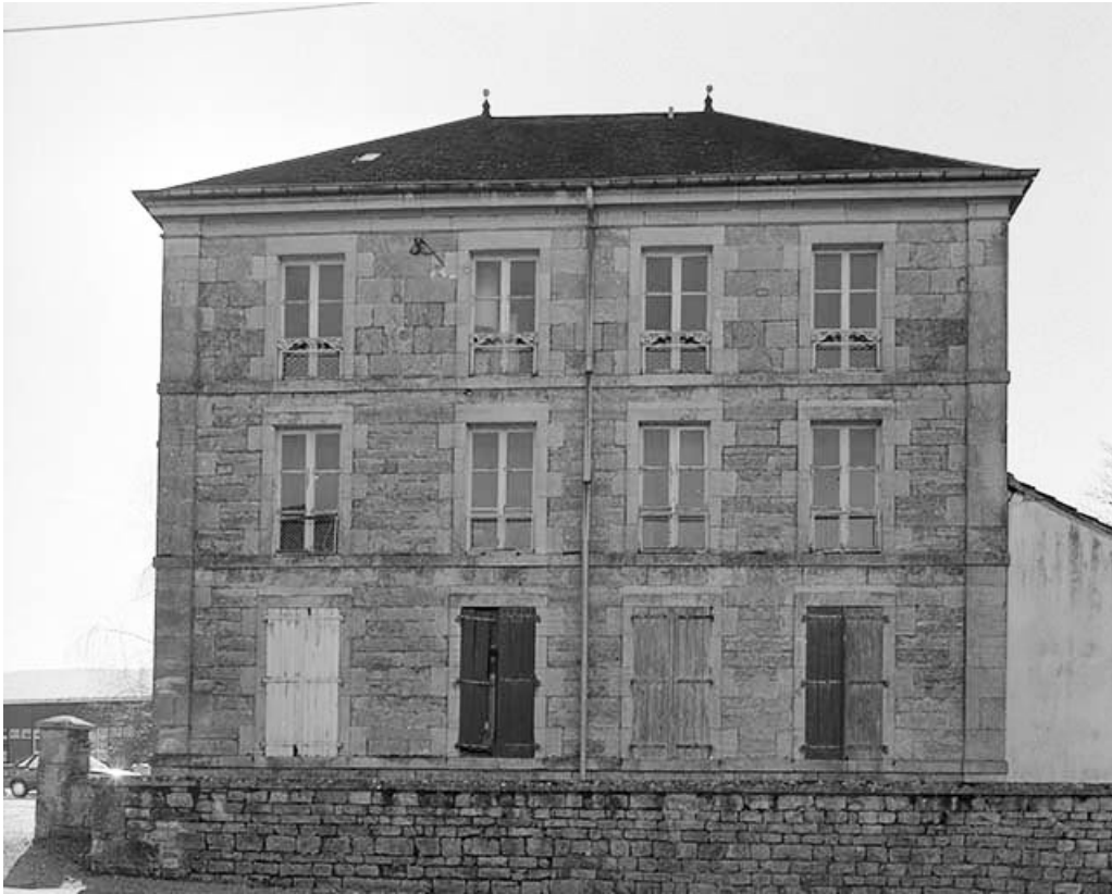
Façade antérieure du logement d'ouvriers.
