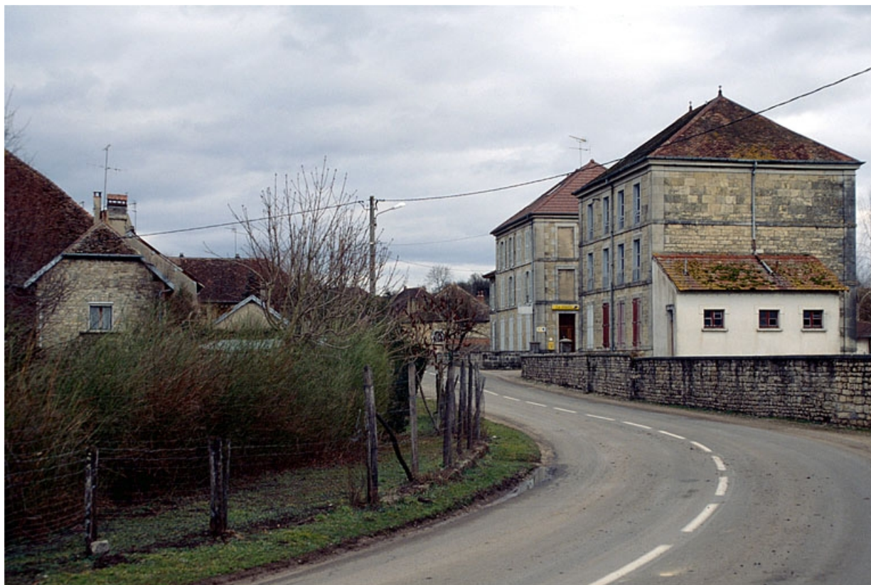
Bureaux et logements depuis la route.
