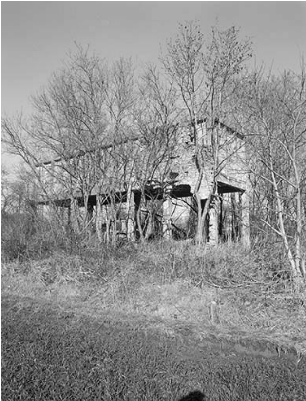
Réservoir industriel (bac à saumure).
