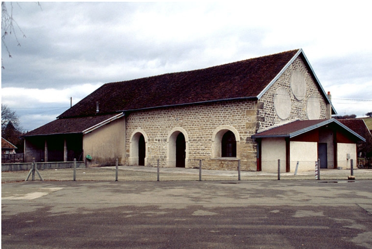
Bâtiment de la machine d'extraction et salle des machines.
