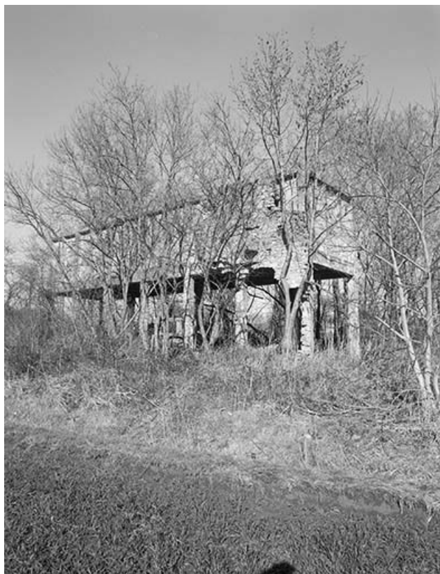
Réservoir industriel (bac à saumure).
