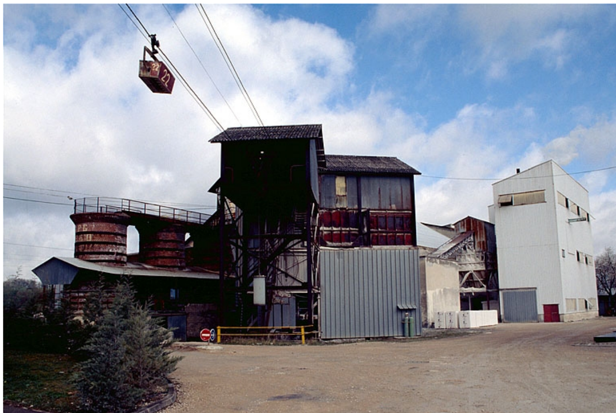
Poste de chargement : réception des bennes de gypse du transporteur par câbles.
