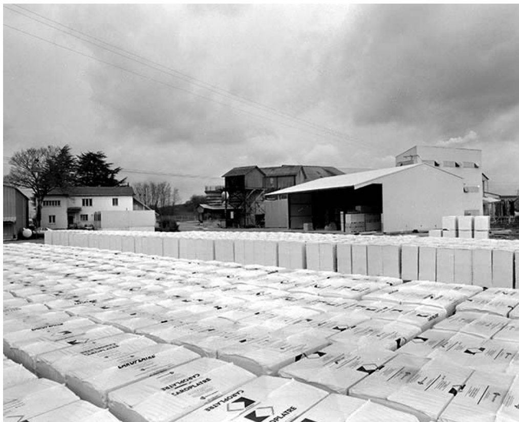
Vue d'ensemble depuis l'est (partie nord).
