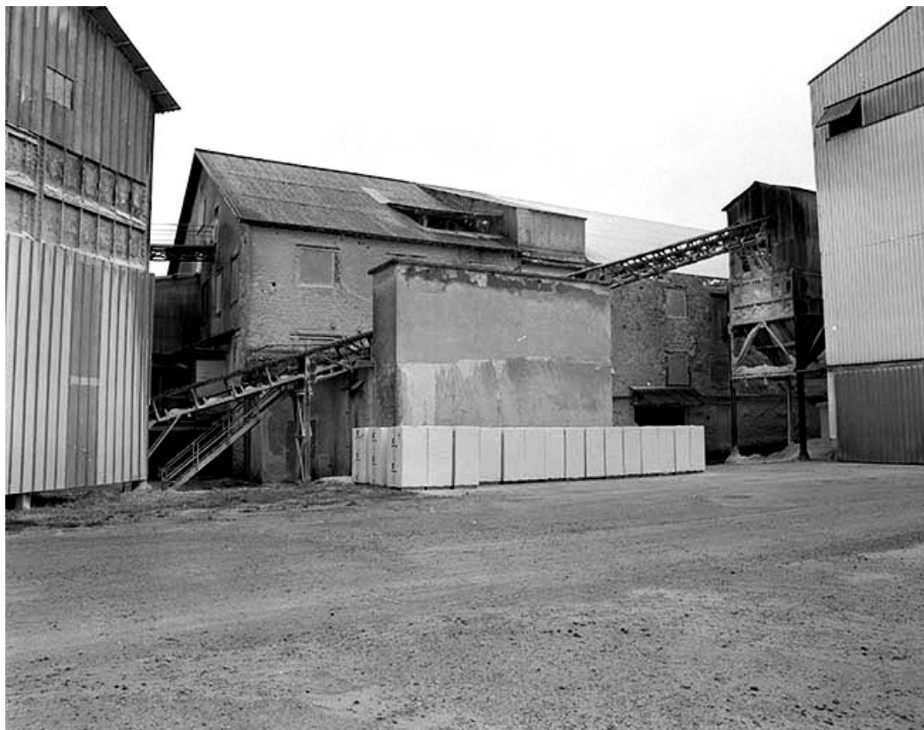
Bâtiment des fours. Au premier plan : convoyeur à gypse surcuit. 39, Grozon, lieudit : les Plâtrières
