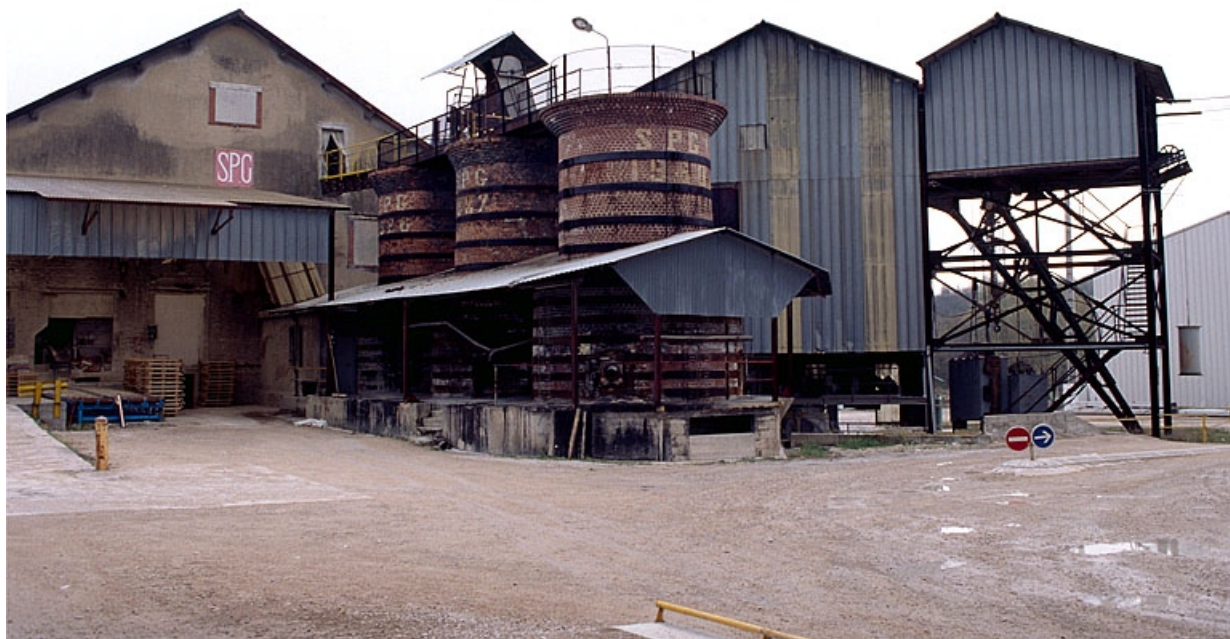
De gauche à droite : bâtiment des fours, anciens fours à surcuit, broyeur et poste de chargement. 39, Grozon, lieudit : les Plâtrières
