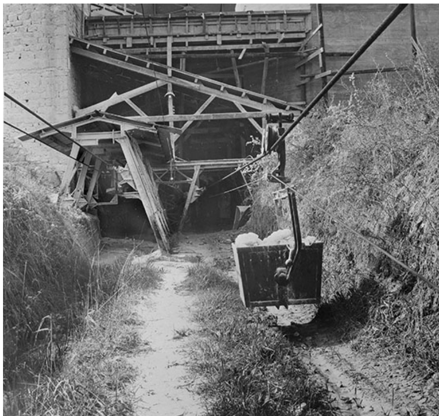
[Départ du transporteur automatique par câbles et télébennes].
