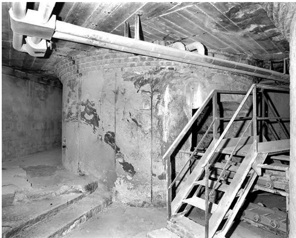
Soubassement d'un four à surcuit.
