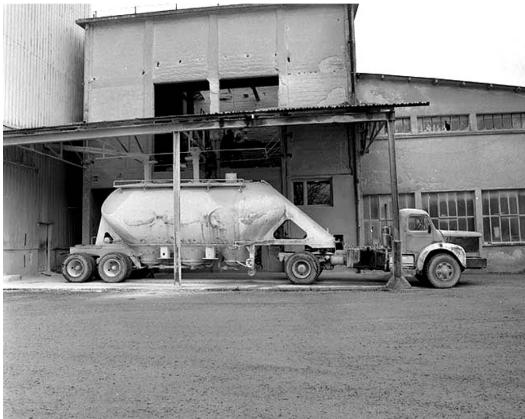
Bâtiment d'un ancien four dit du « plateau 5 », converti en bureaux et silos à plâtre. Transport du plâtre vers l'atelier des carreaux par camion.
