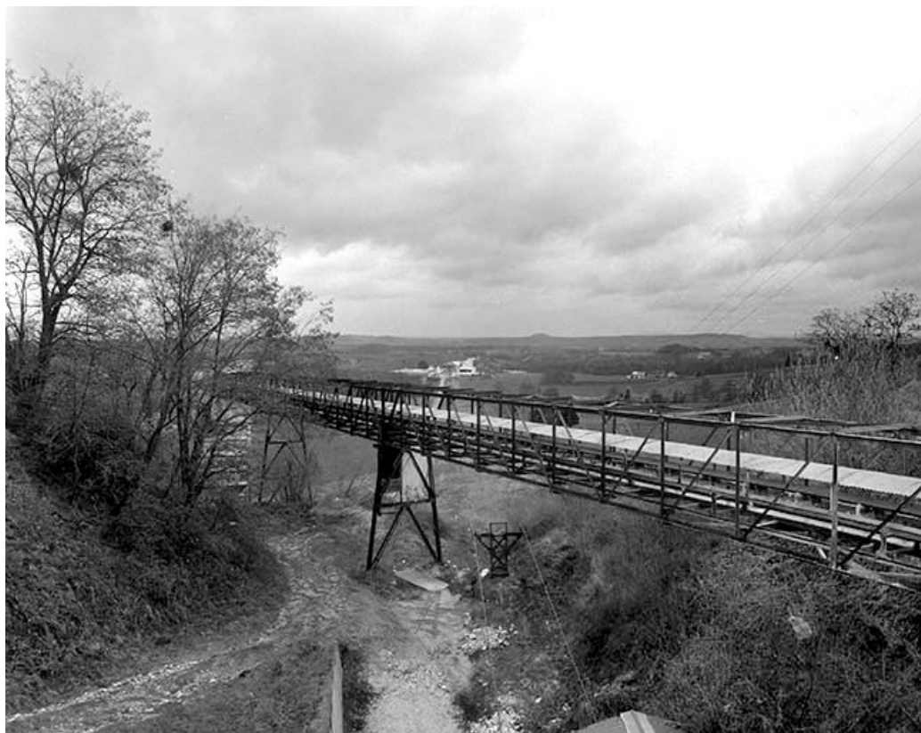
La plâtrière depuis l'atelier de distribution et de concassage de la carrière. Au premier plan : un convoyeur à bandes. 39, Grozon, lieudit : les Plâtrières
