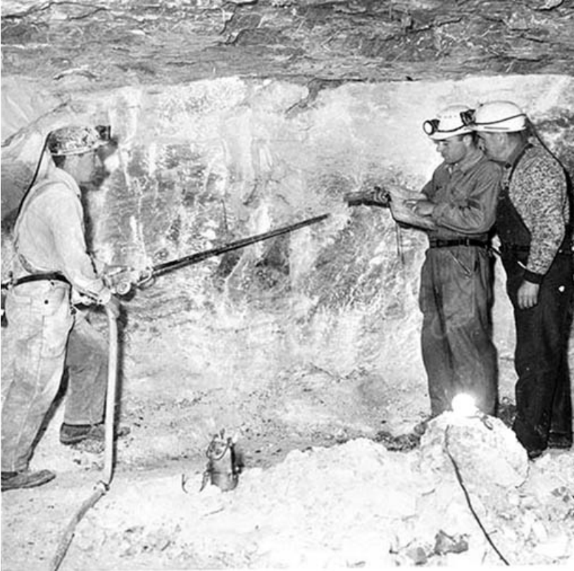
[Front de taille dans la carrière de gypse].
