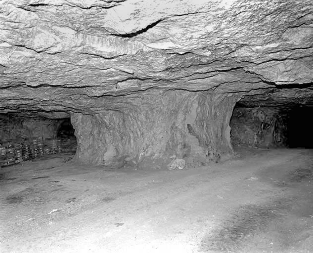
Pilier de soutènement d'une ancienne chambre d'exploitation.
