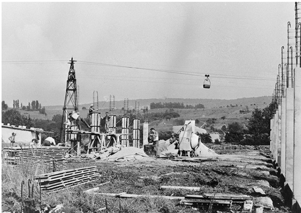
[Construction de l'atelier de fabrication des carreaux de plâtre].
