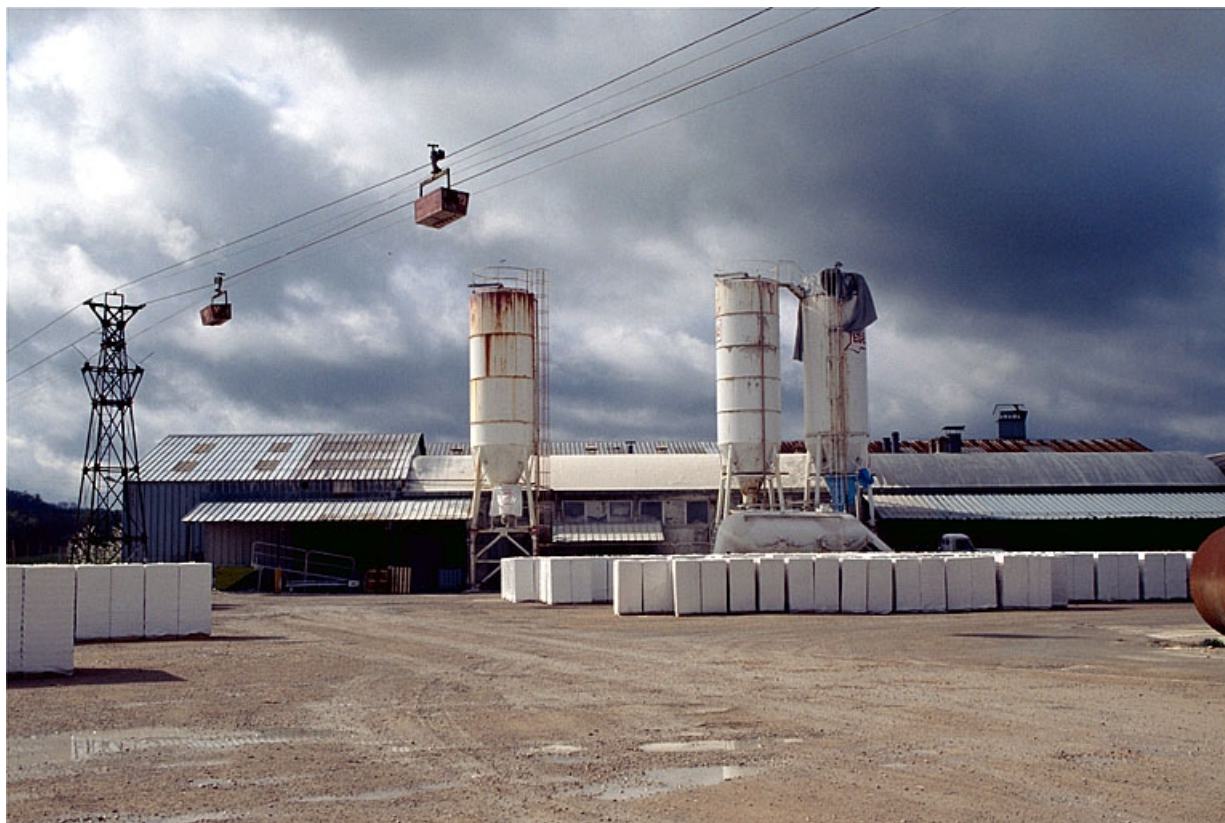
Passage du transporteur par câbles à l'est de l'atelier des carreaux.
