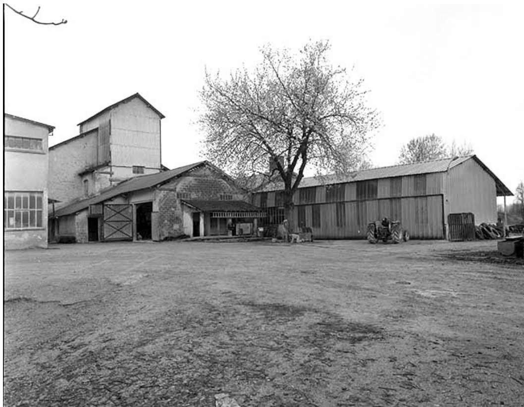
Extrémité nord de l'usine : atelier de réparation, magasin industriel et remise à automobile. 39, Grozon, lieudit : les Plâtrières
