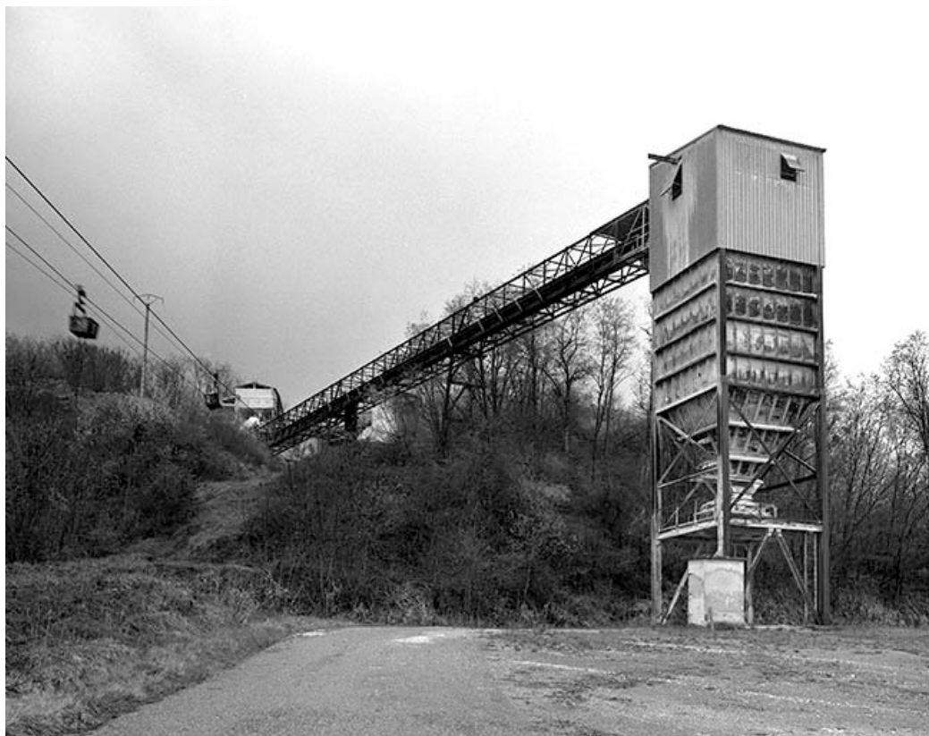
L'entrée de la carrière. Au premier plan : silo à gypse, relié par convoyeur à l'atelier de concassage. 39, Grozon, lieudit : les Plâtrières
