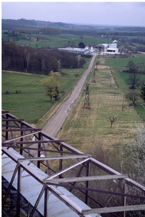
Le transporteur par câbles et la plâtrière depuis la carrière.
