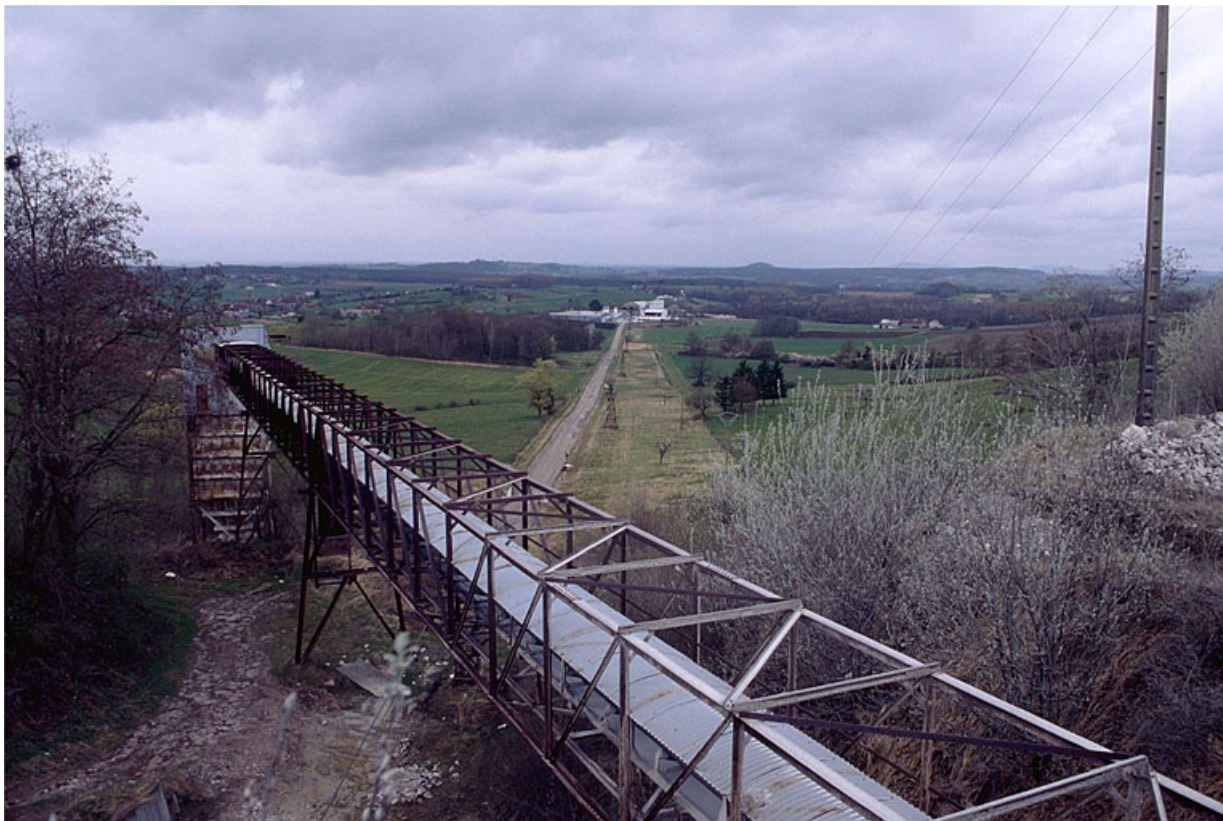
Convoyeur à bandes et silo à gypse de la carrière.
