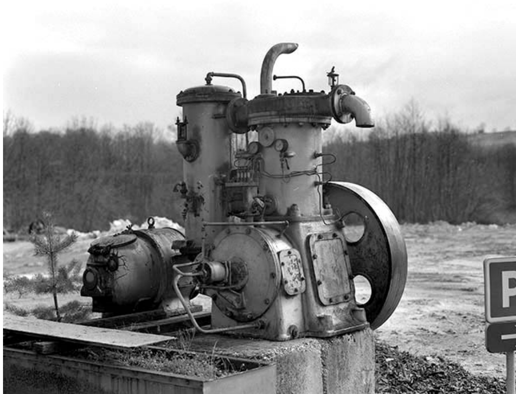
Compresseur (1934, Cie Fives-Lille). Aujourd'hui déposé dans une cour, il aurait été utilisé par la carrière Clément pour l'extraction du gypse.
