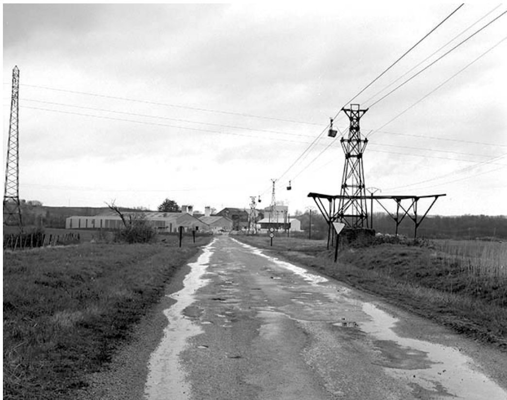
Le transporteur par câbles, à mi-chemin entre la plâtrière (au fond) et la carrière.
