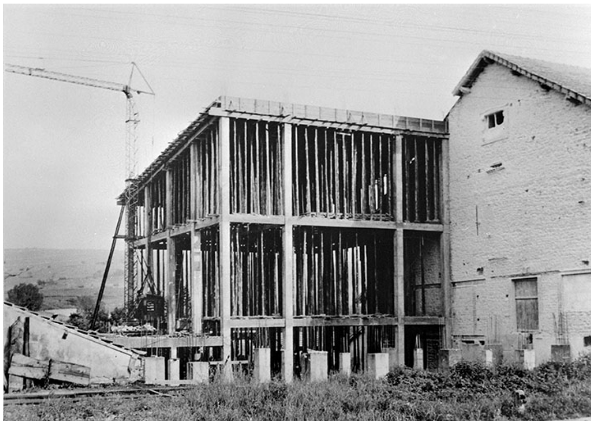
[Construction de l'atelier dit du plateau 5].
