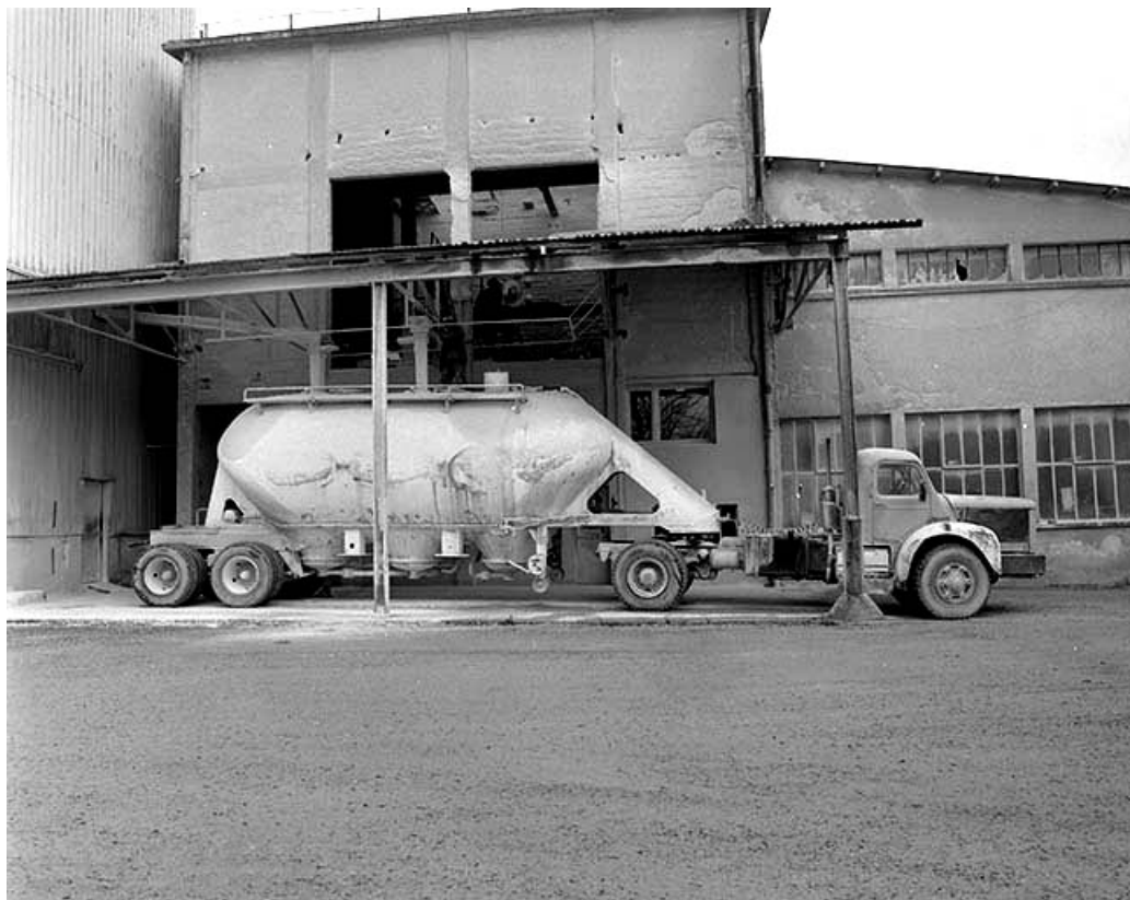
Bâtiment d'un ancien four dit du « plateau 5 », converti en bureaux et silos à plâtre. Transport du plâtre vers l'atelier des carreaux par camion.
