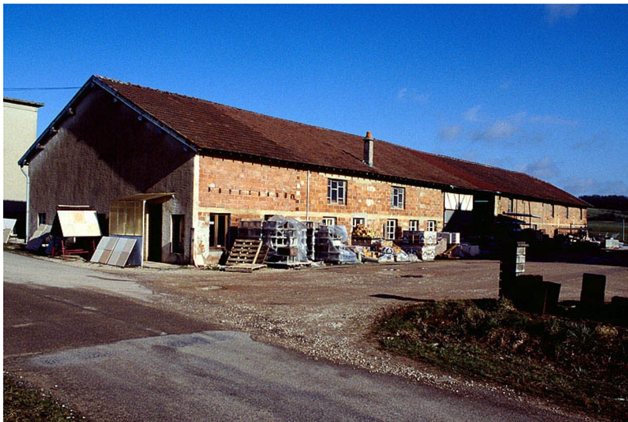
Bâtiment comprenant le bureau, un atelier de fabrication et la pièce de séchage.
