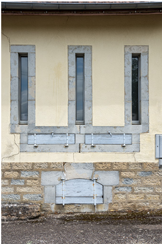
Baies de la chambre à lait et de la cave d'affinage.
