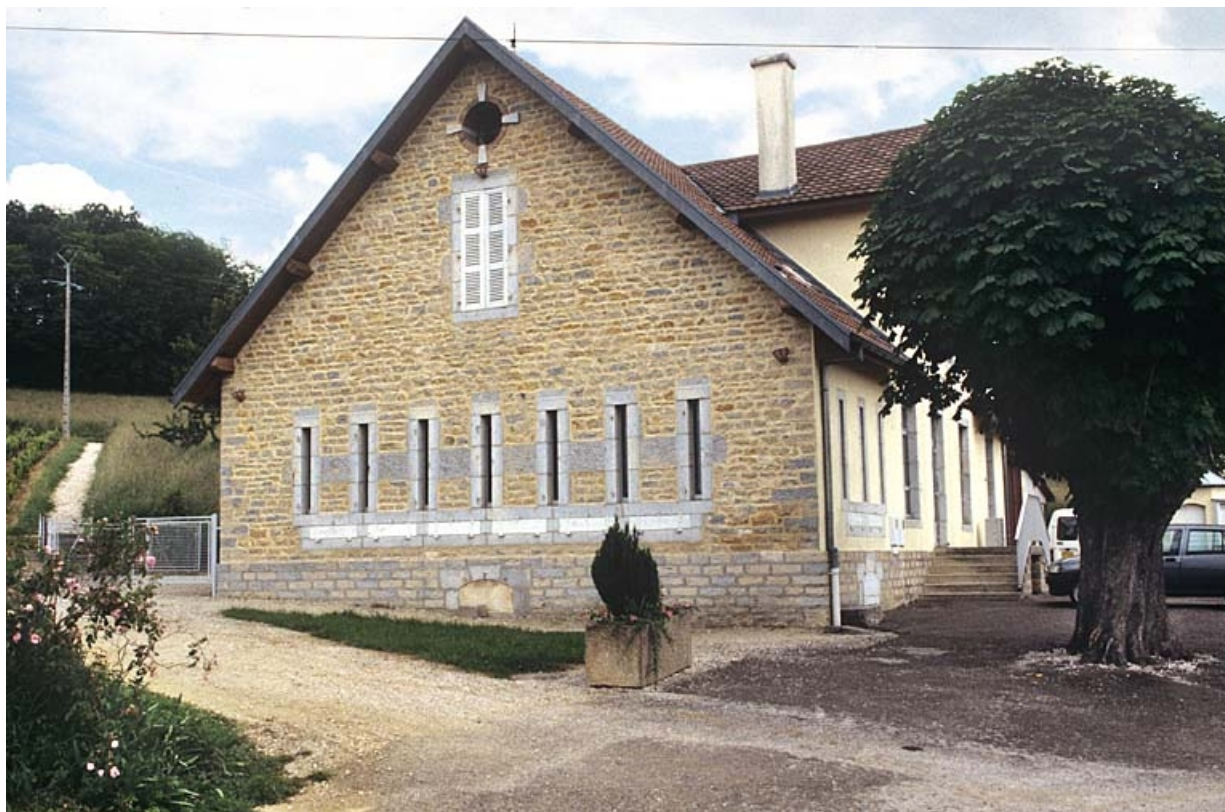
Façade latérale gauche (chambre à lait).
