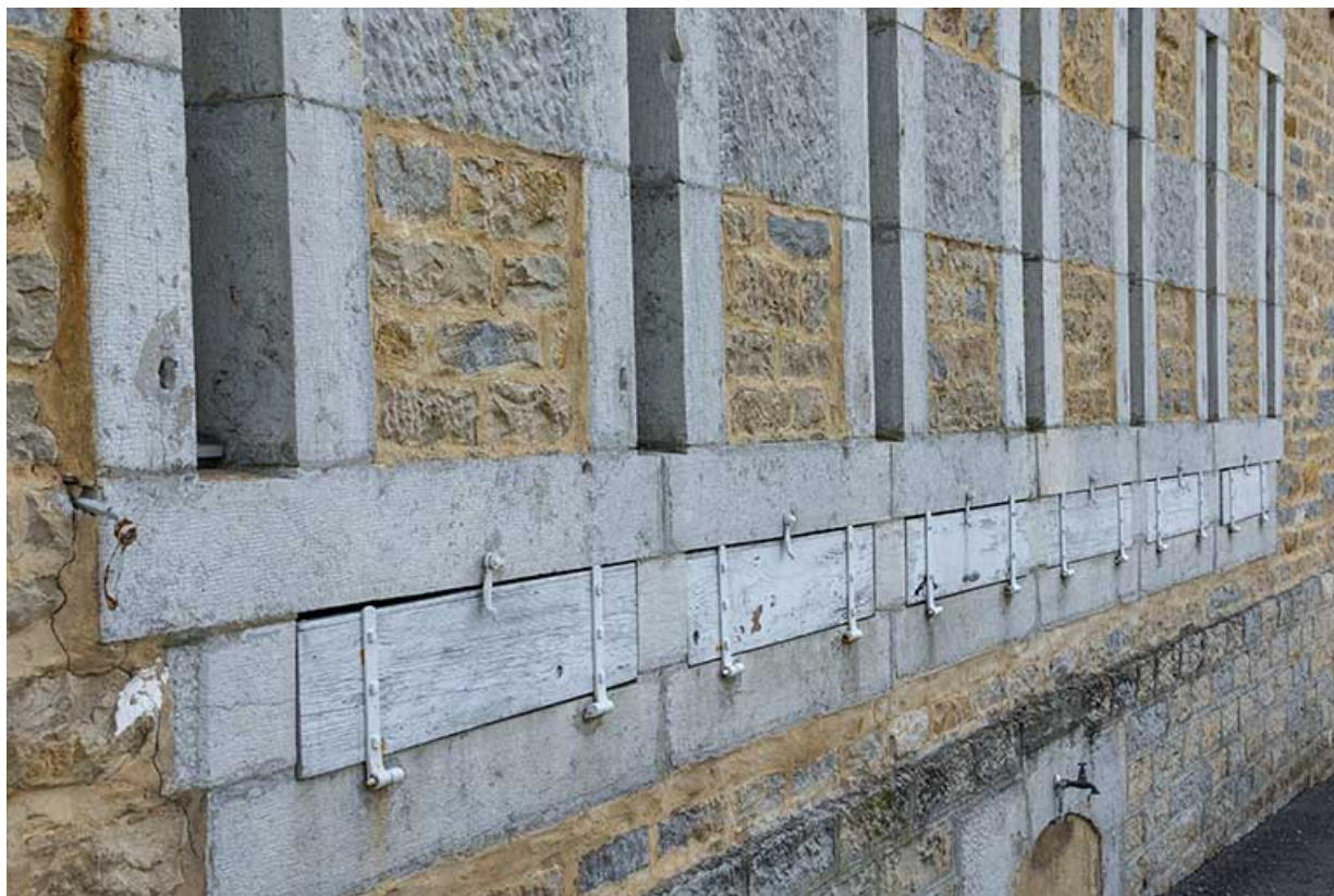
Vue rapprochée des baies.
