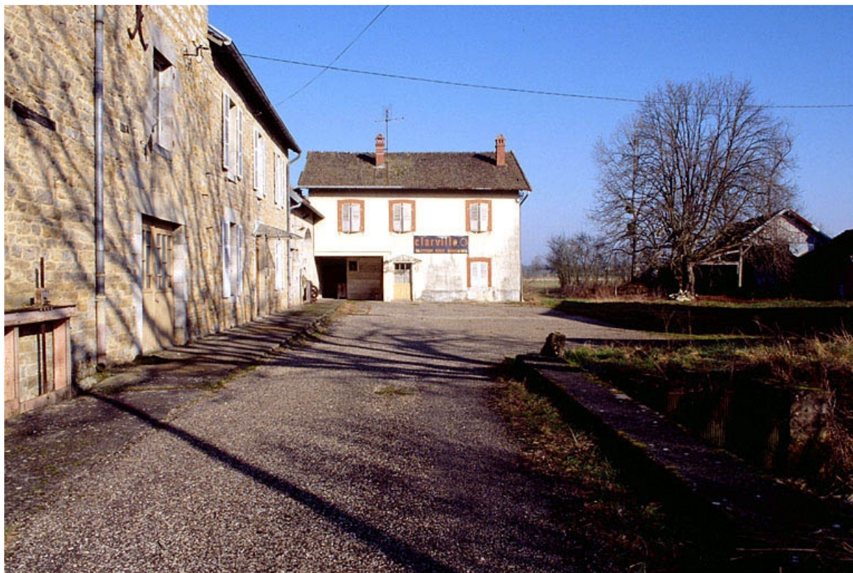
De gauche à droite : atelier de fabrication, logement patronal et parties agricoles, logement d'ouvriers, remise à automobile. 39, Colonne, lieudit : Vaivre
