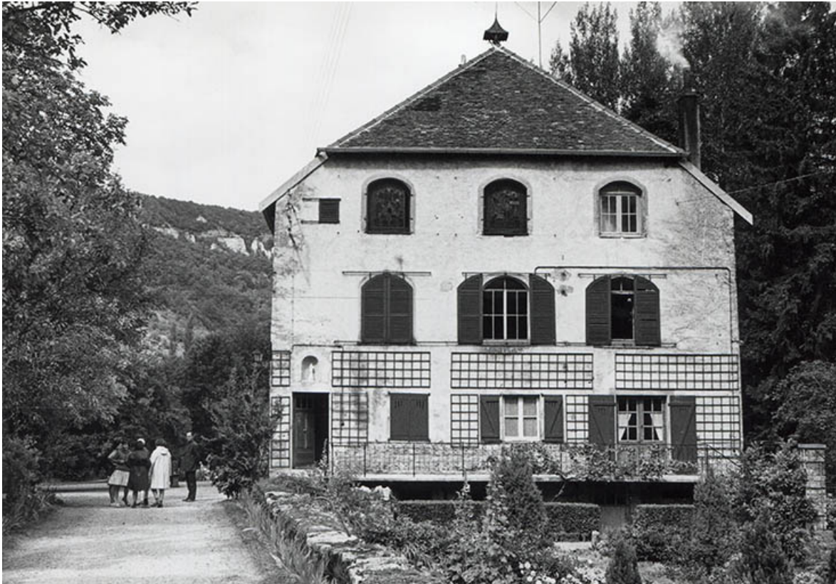
Ancien moulin à papier (?), pignon ,photogr., s.d. [début 20e siècle]. 39, Mesnay, lieudit : aux Echaillers
