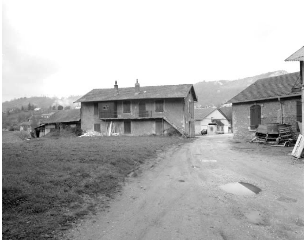
Façade postérieure d'un logement d'ouvriers.
