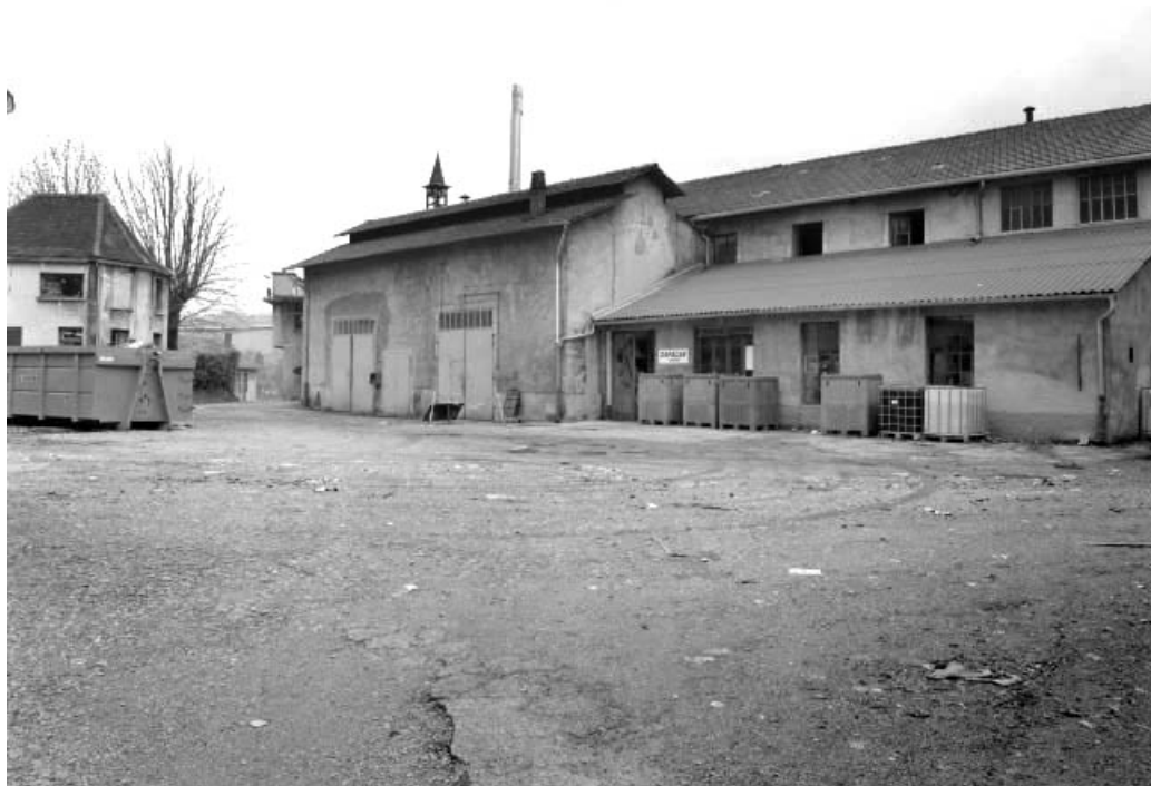
De gauche à droite : bureaux, chaufferie et laboratoire.
