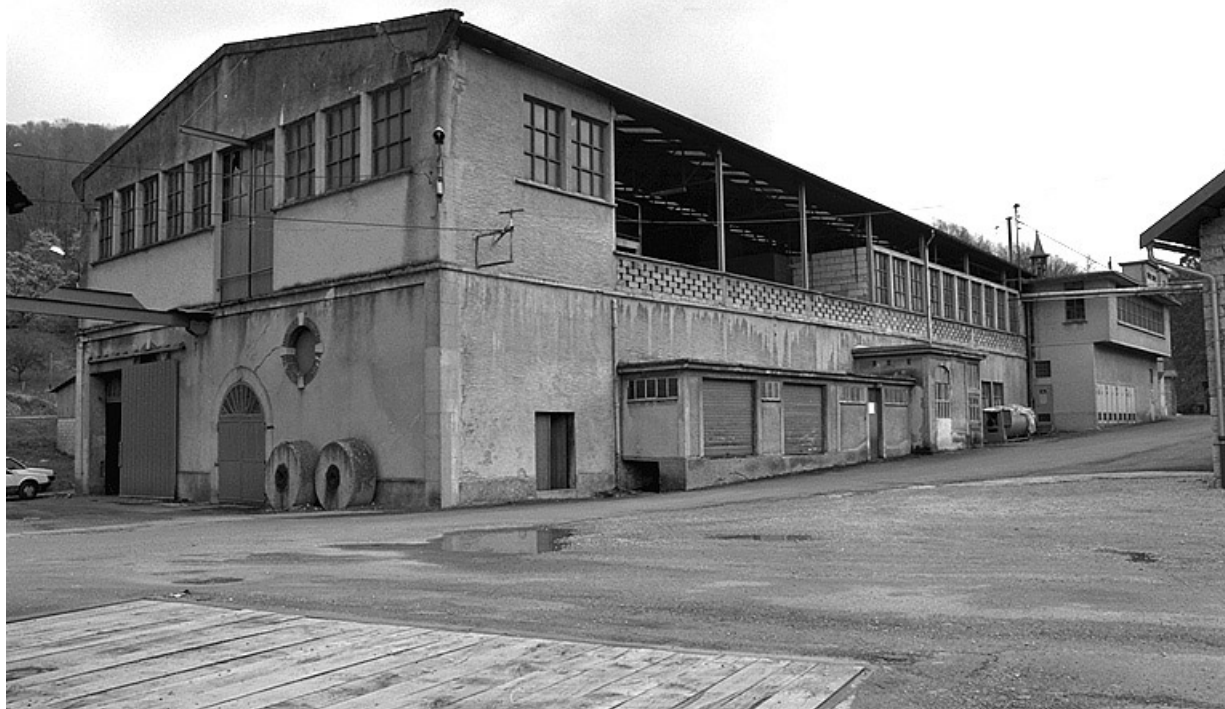
Façade sur cour de l'atelier de fabrication est.
