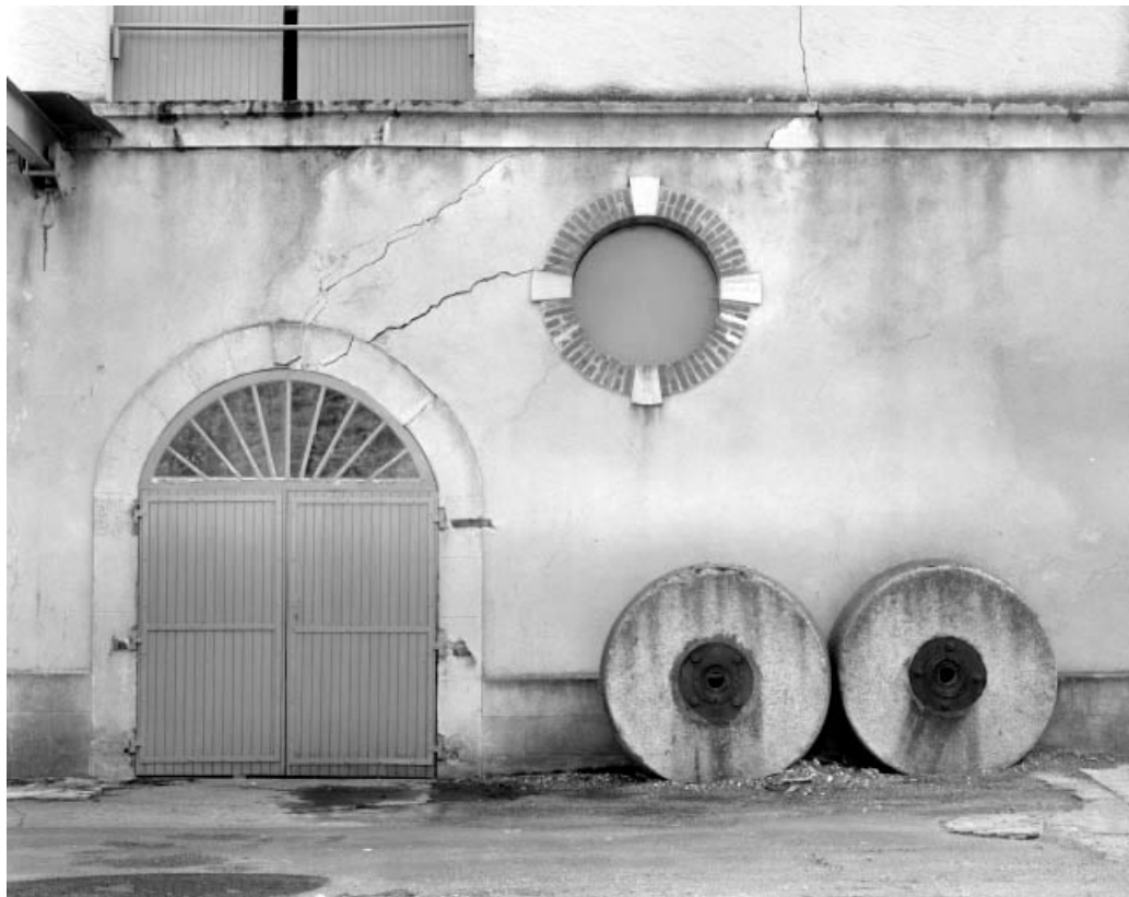
Atelier de fabrication est : détail de la façade.
