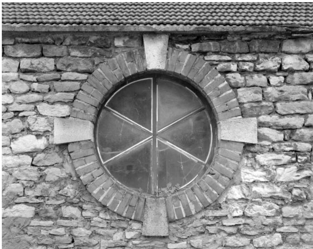
Atelier de fabrication ouest : détail d'un oculus.
