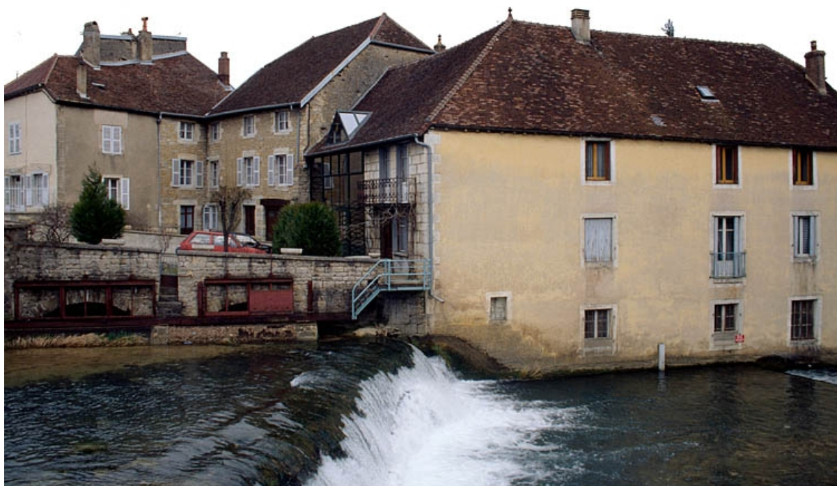
Vue d'ensemble depuis la rive droite.
