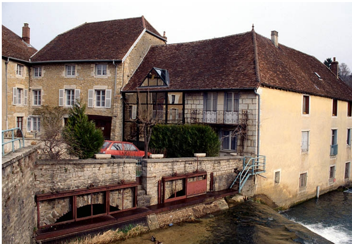
Prises d'eau de l'ancien moulin et atelier de fabrication depuis le pont.
