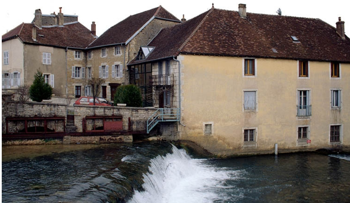
Vue d'ensemble depuis la rive droite.
