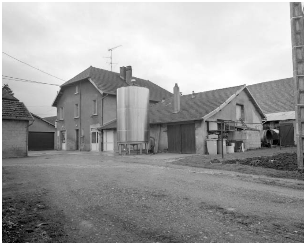
La fromagerie depuis l'est, avec les pièces d'affinage au premier plan.
