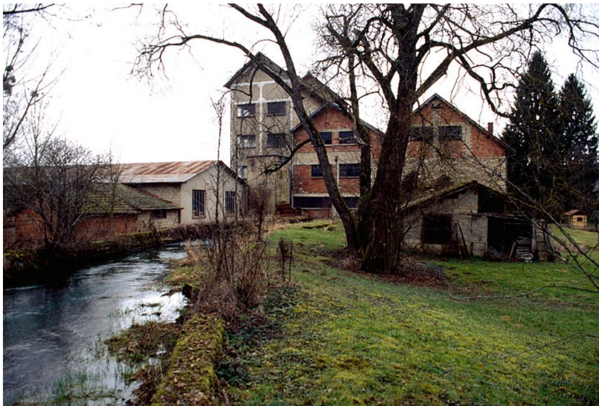
Façades postérieures depuis le canal d'amenée.
