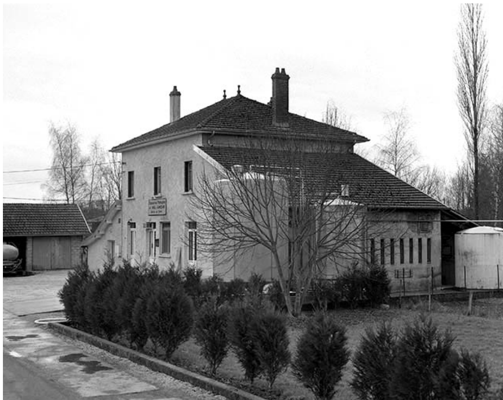
Vue rapprochée depuis la rue.
