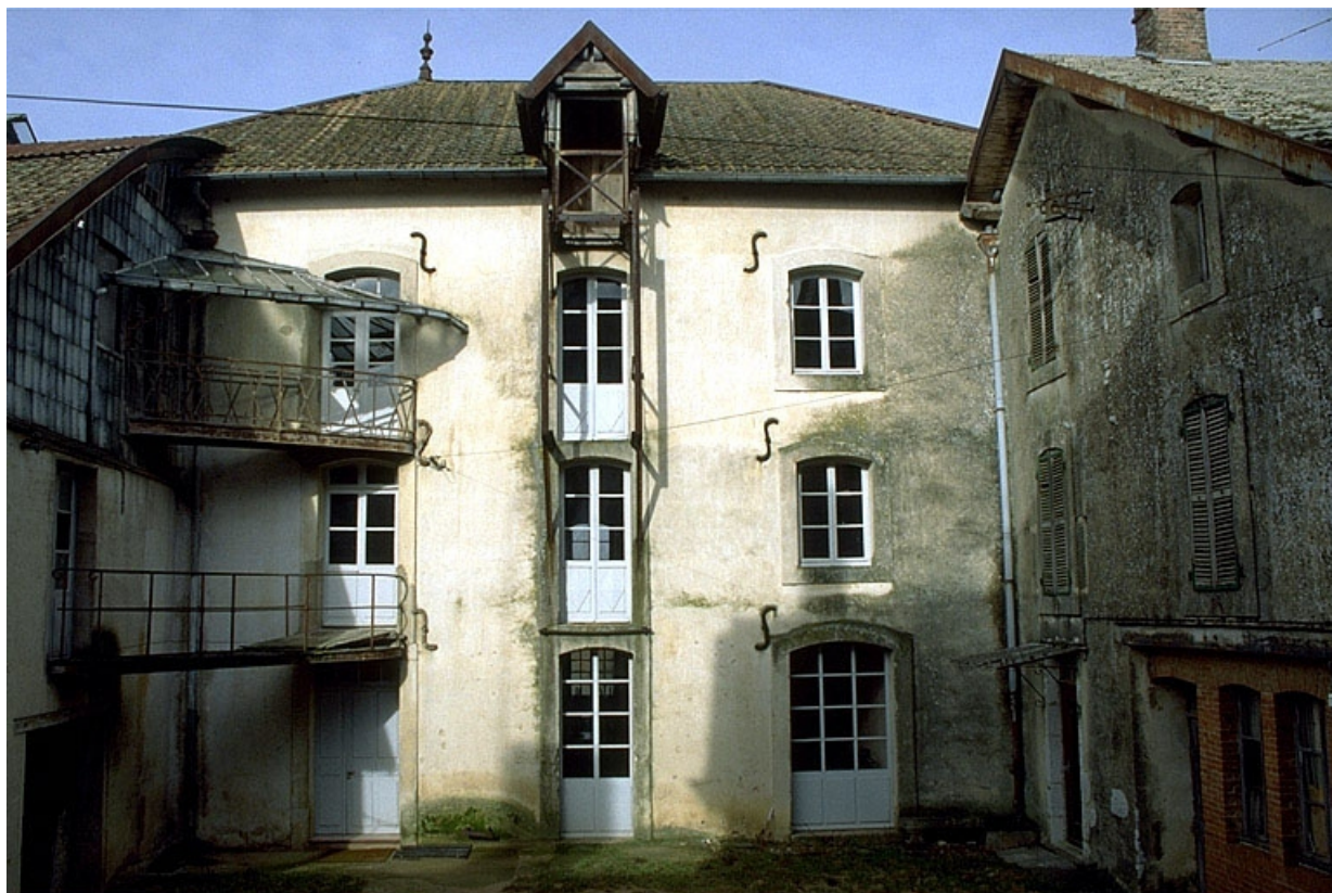
Façade antérieure de l'atelier de fabrication.
