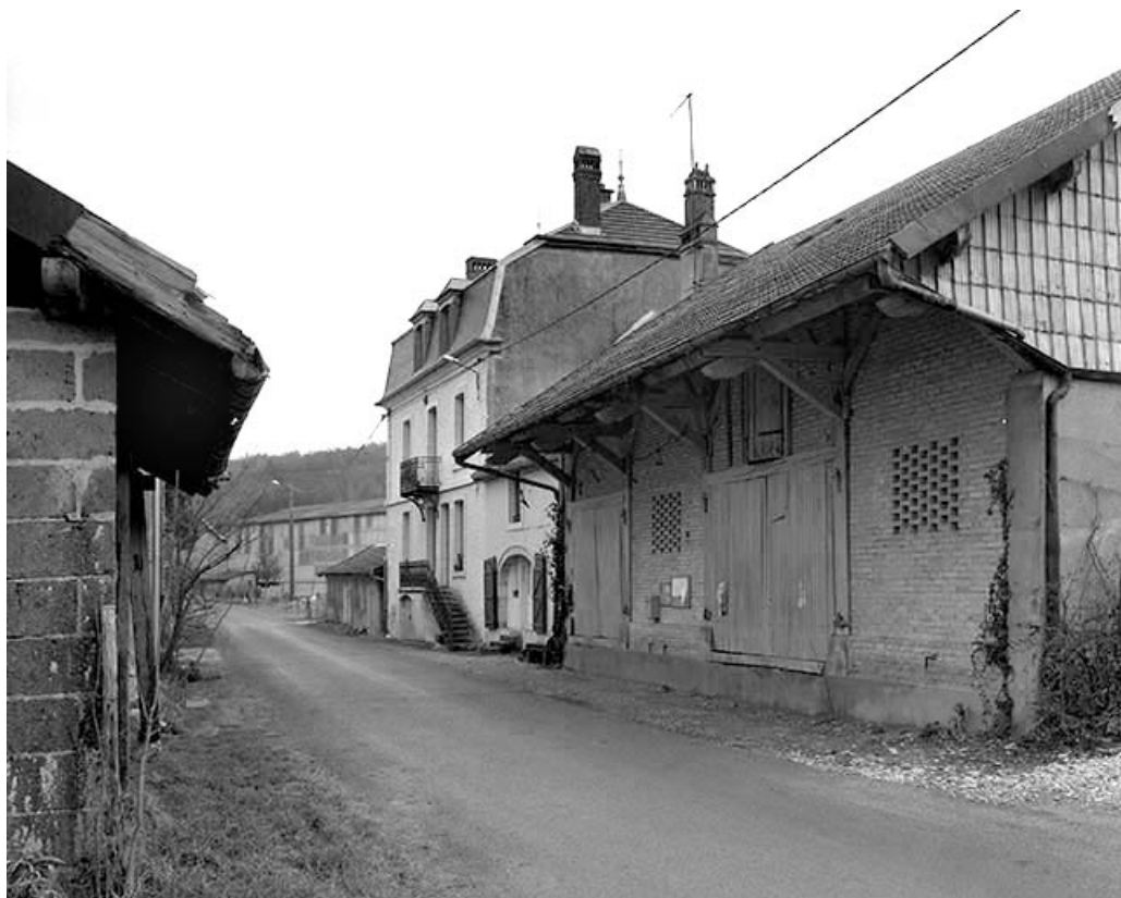
Vue en enfilade depuis la route. De gauche à droite : logement patronal, logement d'ouvriers et entrepôt industriel. 39, Champagne-sur-Loue, lieudit : Moulin Neuf
