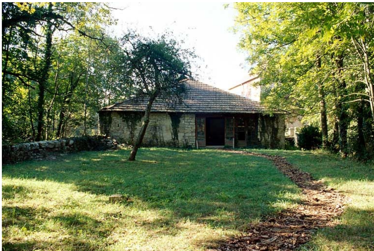
Extrémité ouest de l'atelier de la forge.
