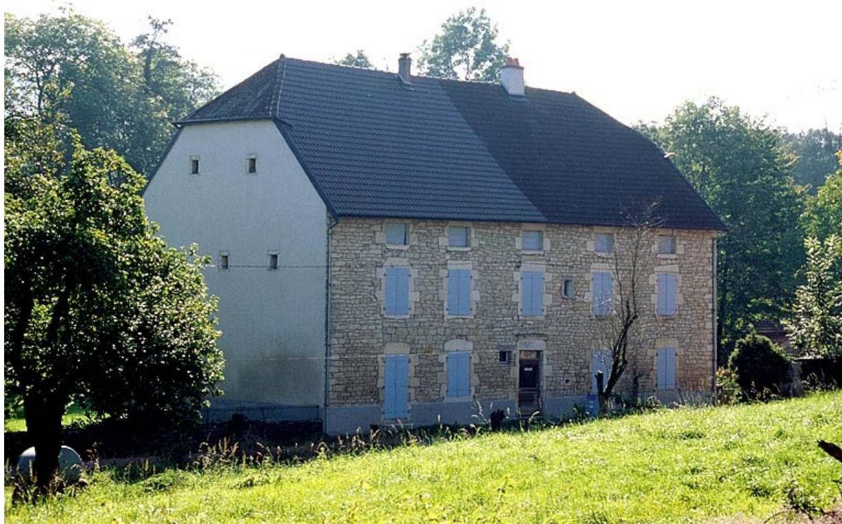
Logement patronal depuis le nord-ouest.
