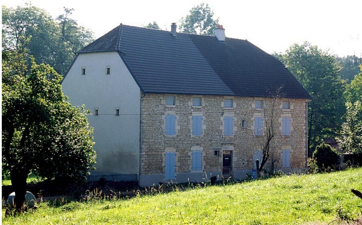
Logement patronal depuis le nord-ouest.
