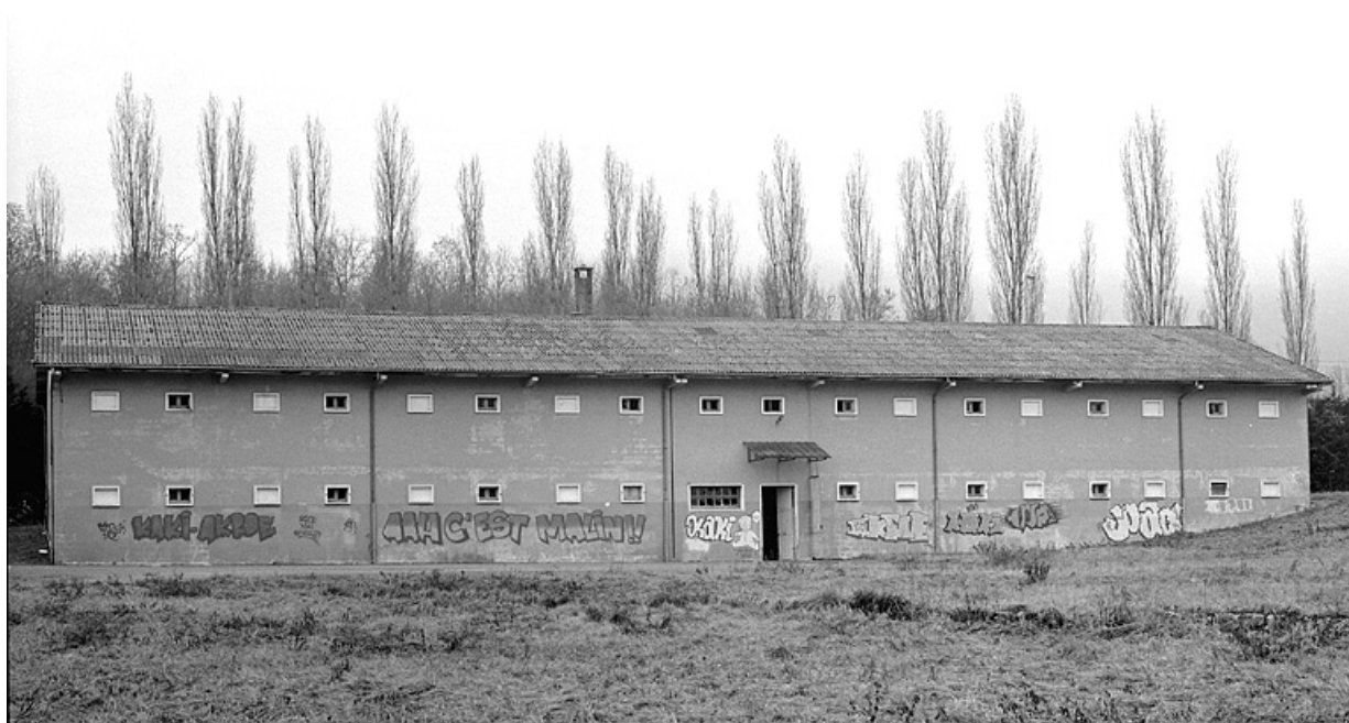
Magasin industriel. Stockage de crèmes de gruyère de l'usine Grosjean.
