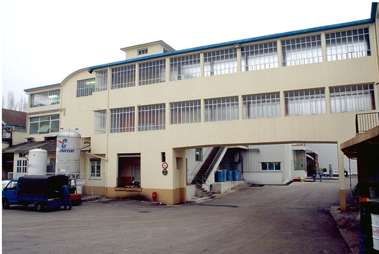
Extrémité ouest de l'atelier de fabrication et sa passerelle.
