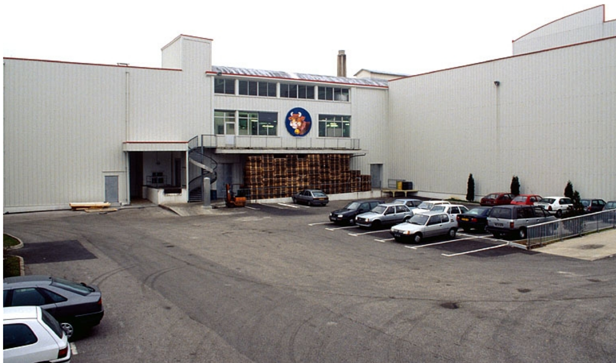
Atelier de fabrication et de conditionnement, magasin et entrepôt industriels depuis l'entrée.
