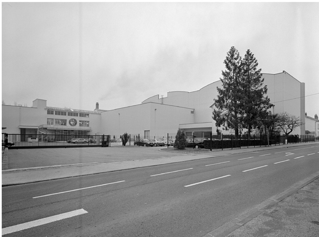
Vue d'ensemble depuis l'avenue Camille Prost. 39, Lons-le-Saunier, 41, 43 avenue Camille Prost
