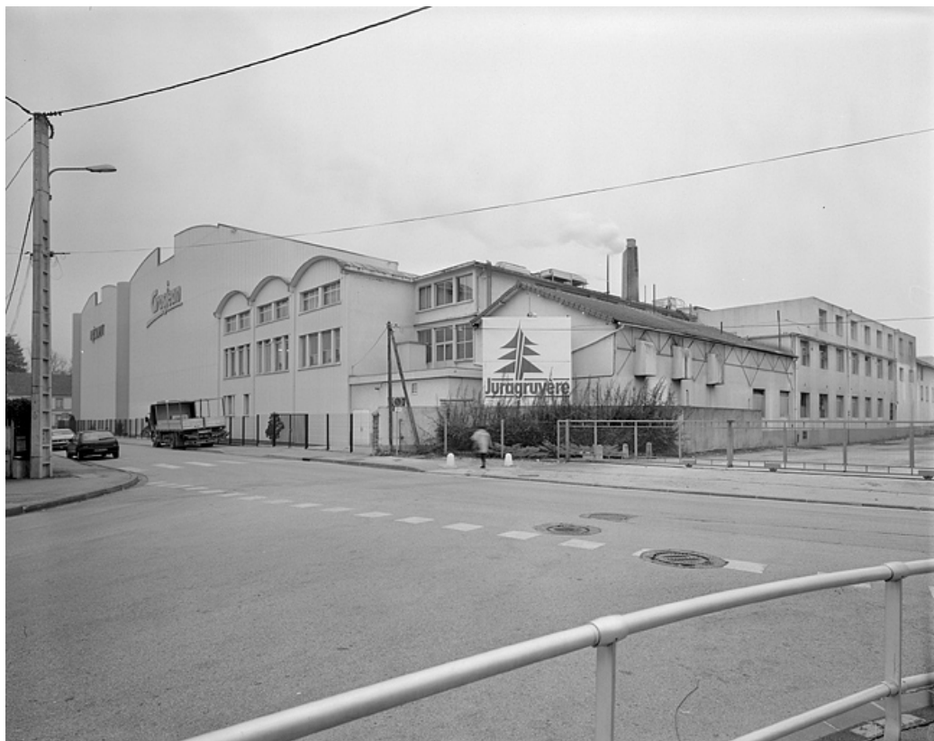
De gauche à droite : magasin et entrepôt industriels, atelier de fabrication et de conditionnement, chaufferie et vestiaire. 39, Lons-le-Saunier, 41, 43 avenue Camille Prost
