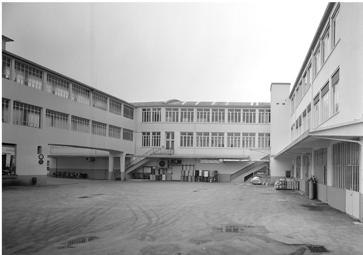
Passerelle, bureau et entrepôt industriel depuis le nord.
