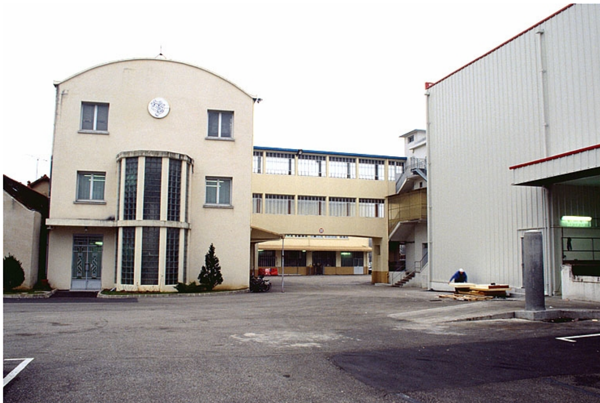
Bureau et passerelle de communication avec l'atelier de fabrication.
