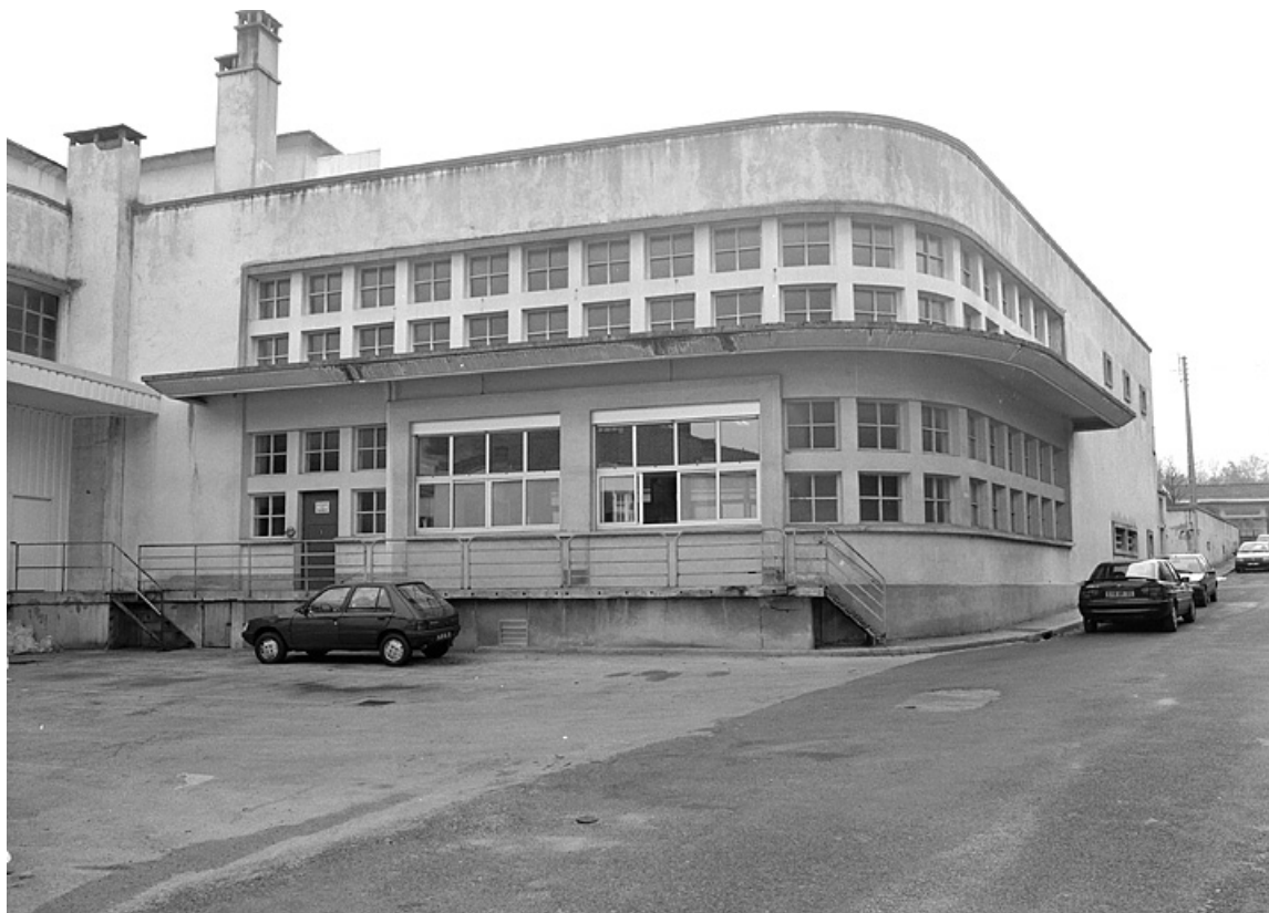
Atelier de fabrication (rue Charles Nodier). Unité d'affinage et d'écroûtage des fromages. 39, Lons-le-Saunier boulevard Jules Ferry
