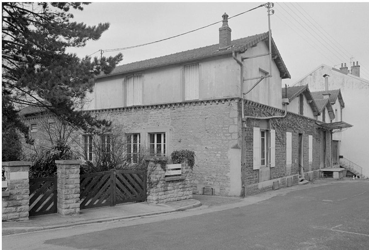
Caves d'affinage depuis le sud-est (rue Charles Nodier).
