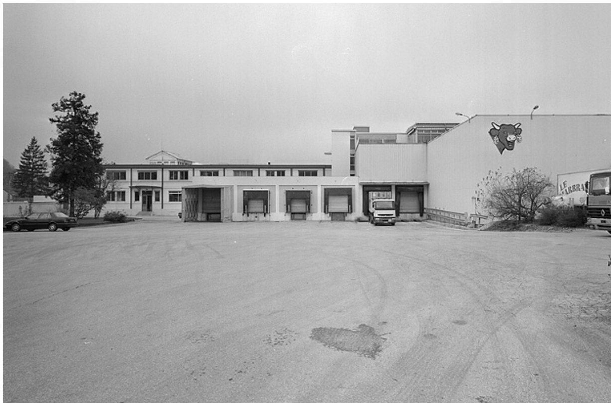
De gauche à droite : atelier de fabrication, quais d'expédition et magasin industriel.
