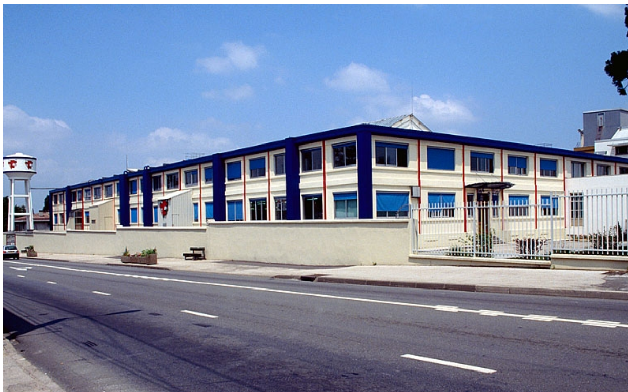
Atelier de fabrication depuis le boulevard Jules Ferry.
