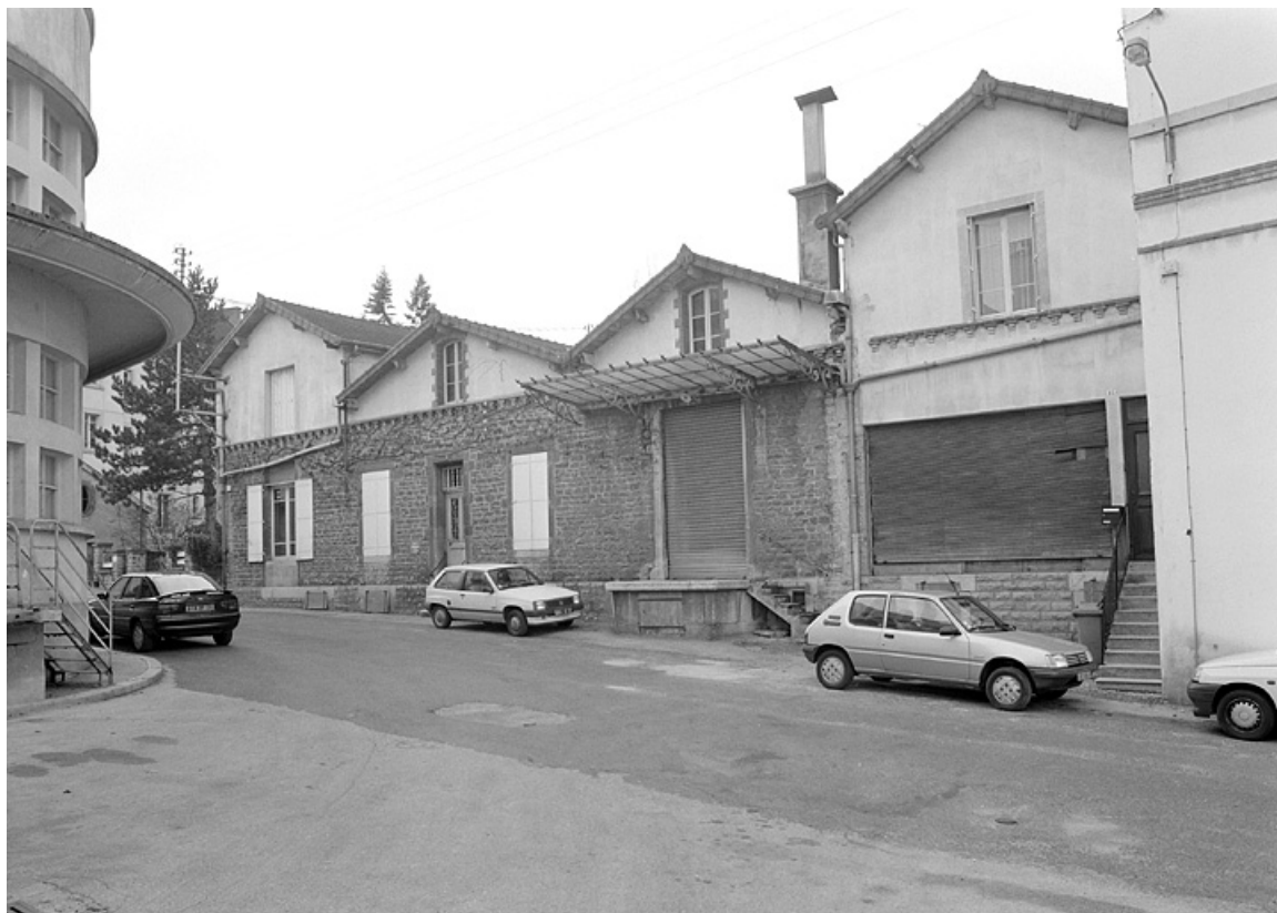
Façade des caves d'affinage (rue Charles Nodier).
