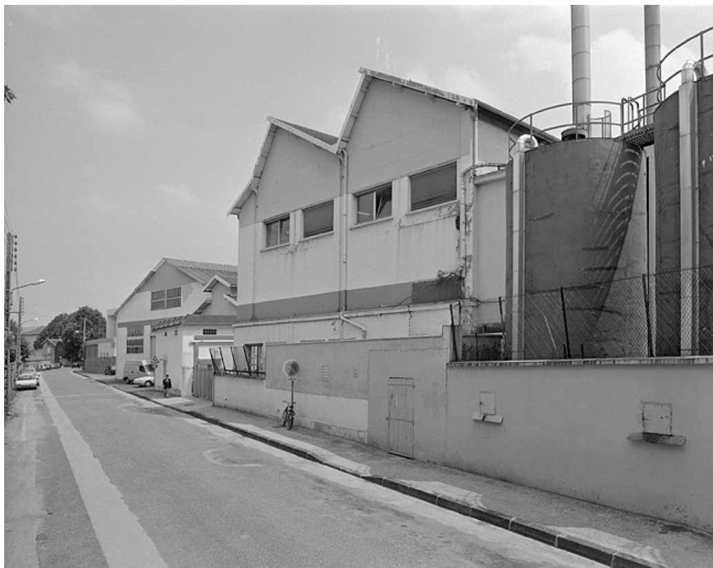
De gauche à droite : entrepôt industriel, atelier de fabrication de l'emballage et réservoirs industriels. 39, Lons-le-Saunier boulevard Jules Ferry
