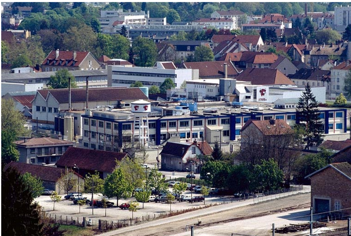
Vue d'ensemble depuis la côte de Montciel.
