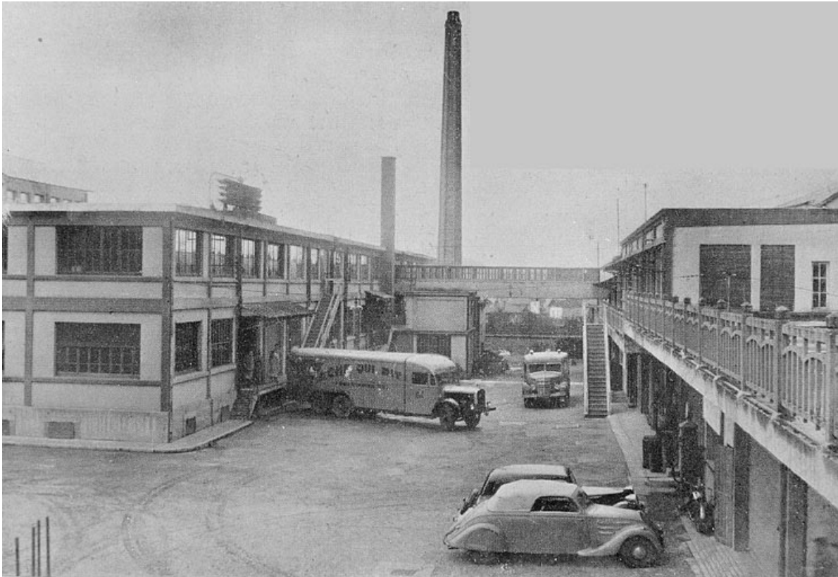
[Atelier de fabrication depuis l'est].
