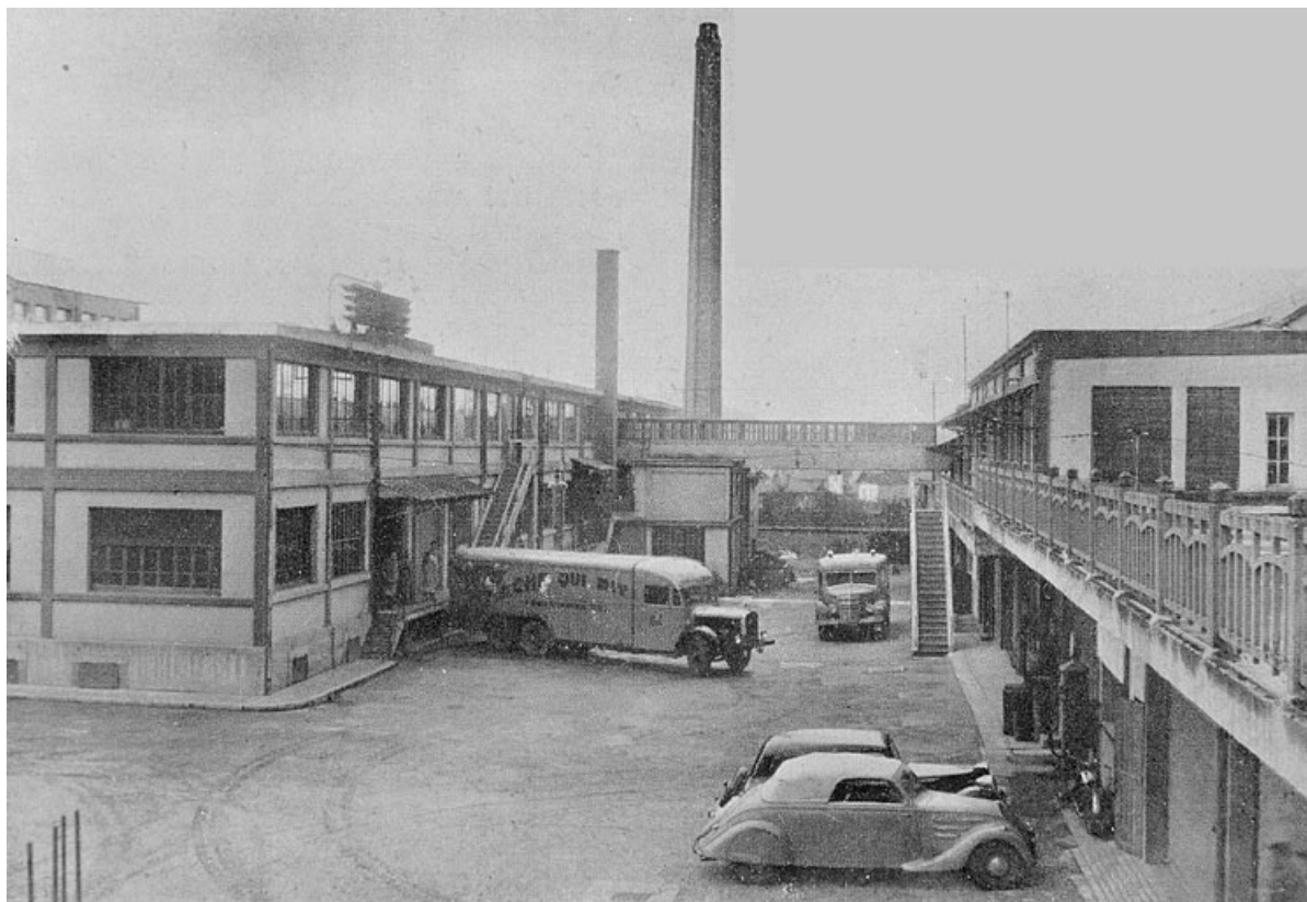
[Atelier de fabrication depuis l'est].
