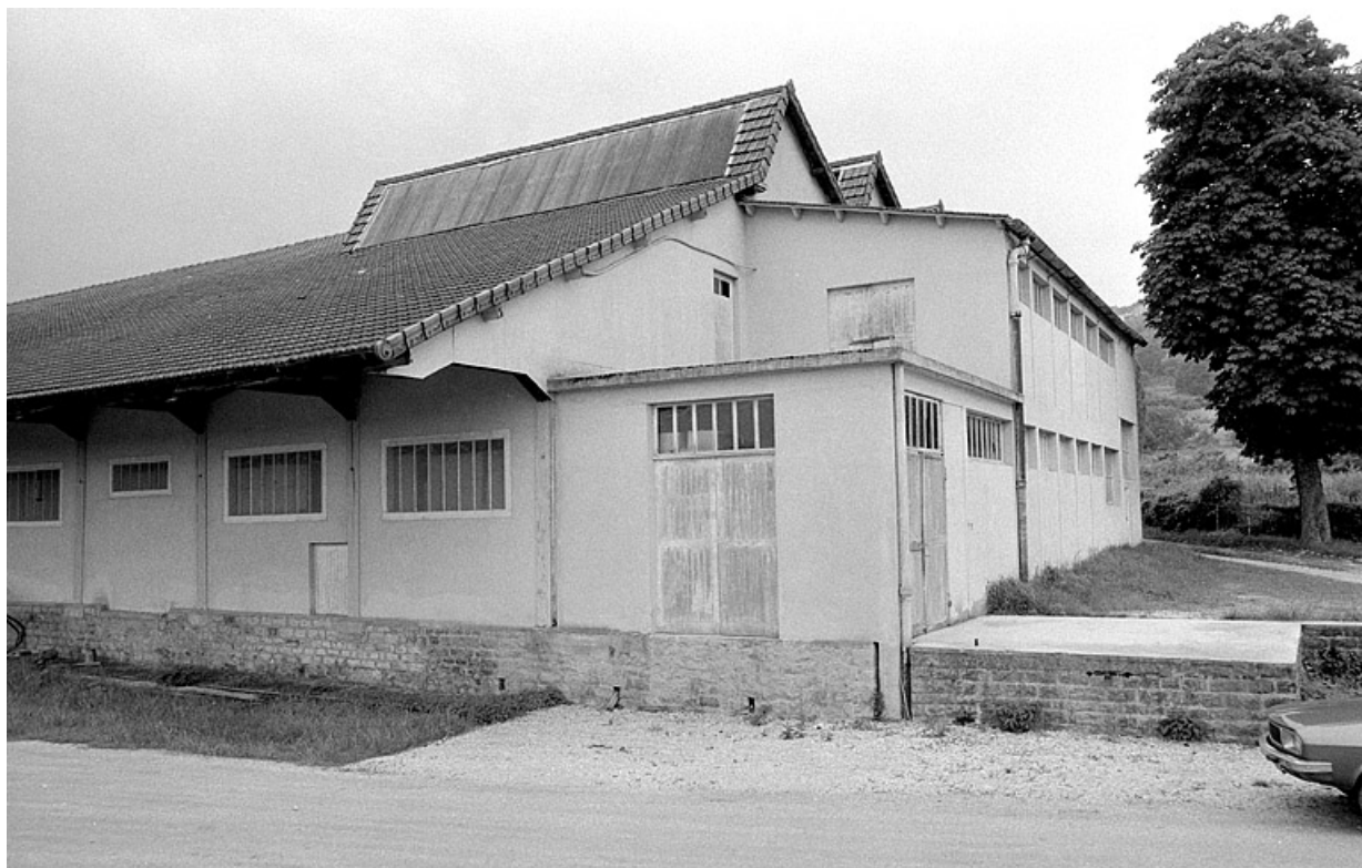
Extrémité ouest de l'atelier de fabrication. 39, Lons-le-Saunier, 48 chemin des Rochettes
