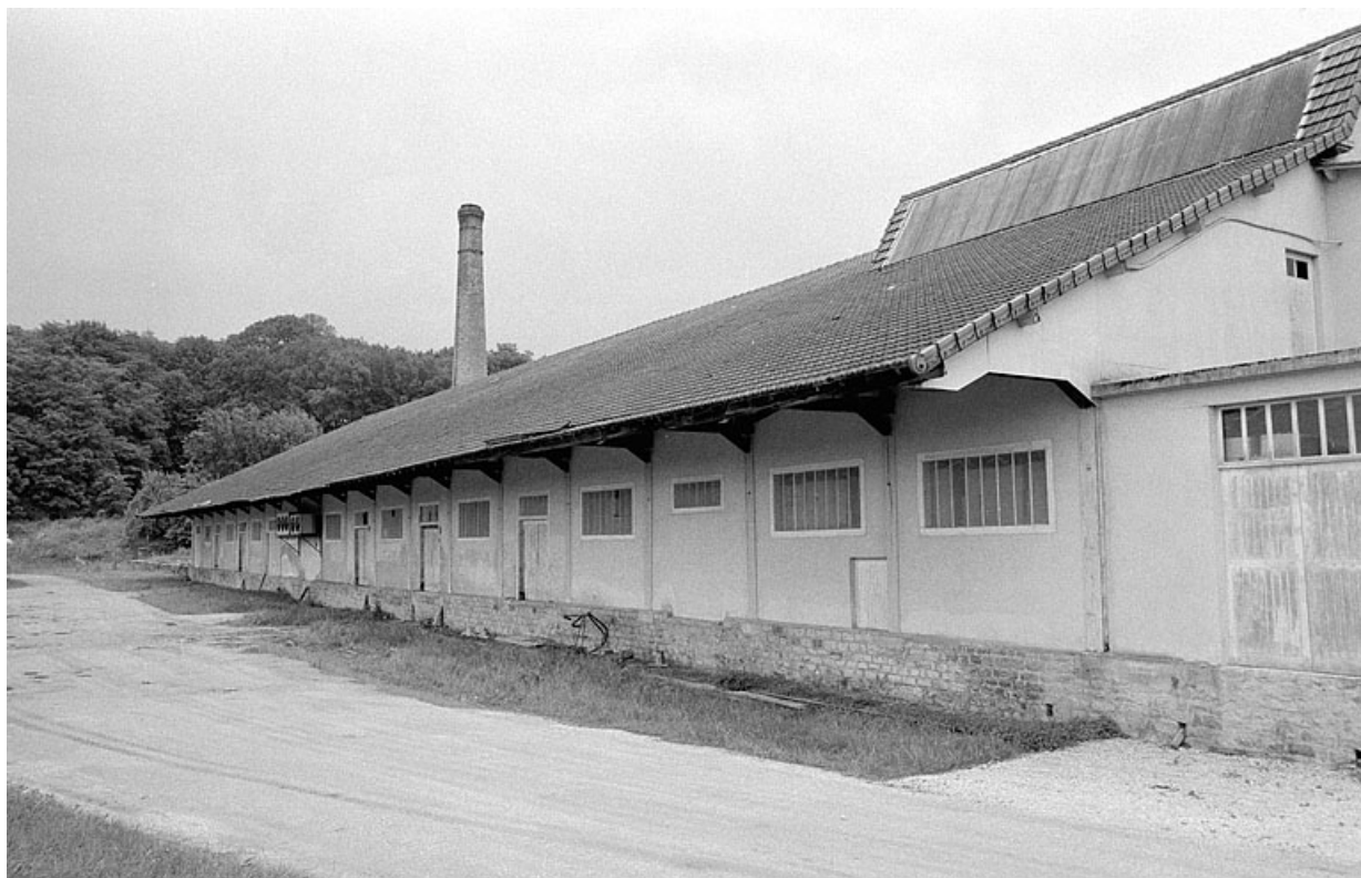
Magasin industriel depuis le nord-ouest en 1980.
