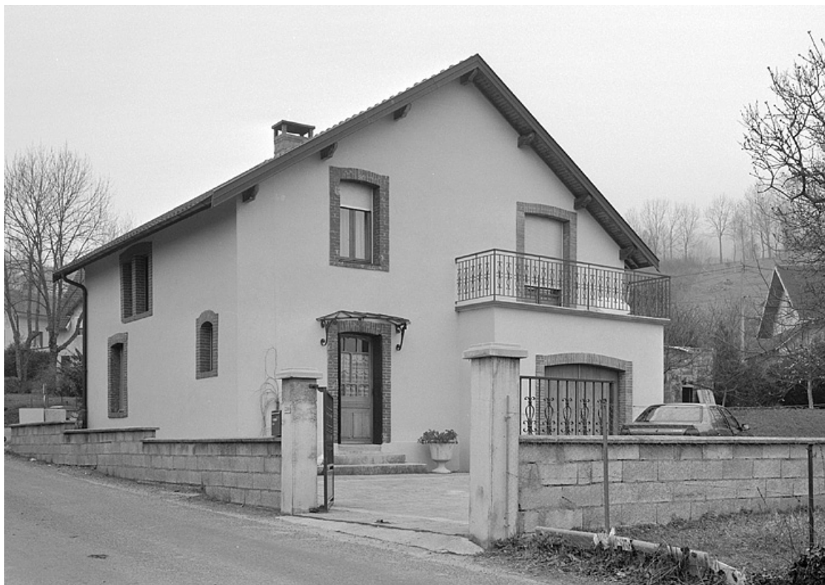
Logement. Maison du gardien des puits de sondage (commune de Perrigny). 39, Lons-le-Saunier, 48 chemin des Rochettes
