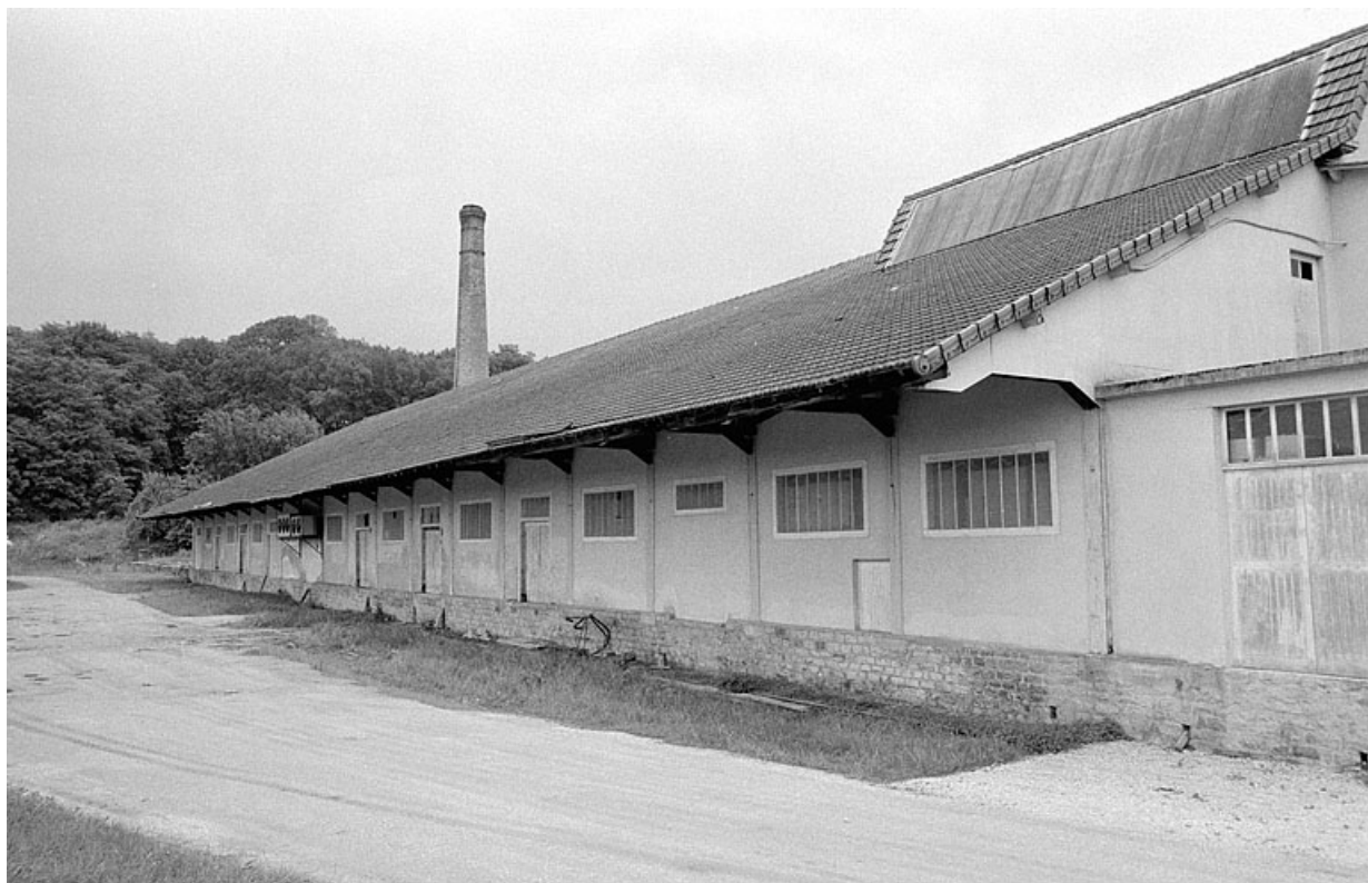
Magasin industriel depuis le nord-ouest en 1980.
