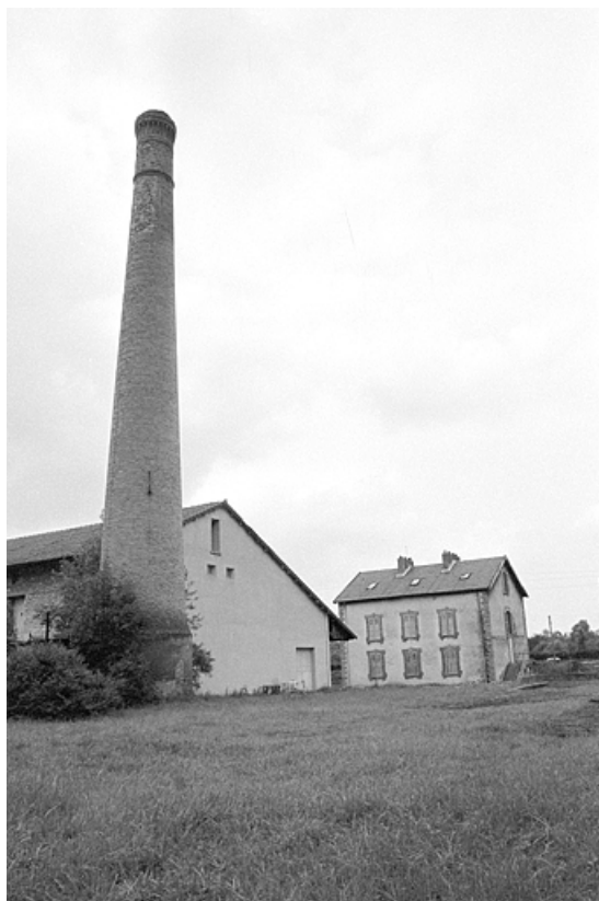
Cheminée, magasin industriel et bureau (contrôle fiscal) en 1980.
