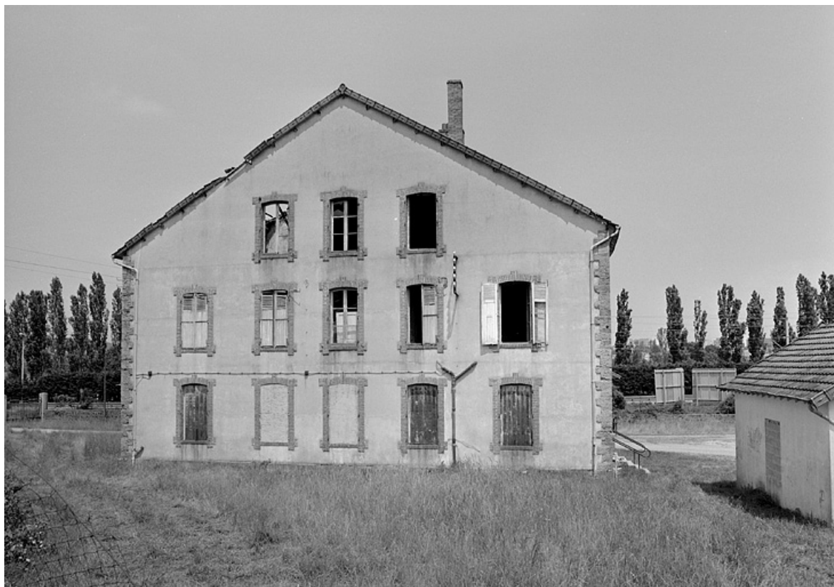
Façade postérieure du logement patronal et bureau.
