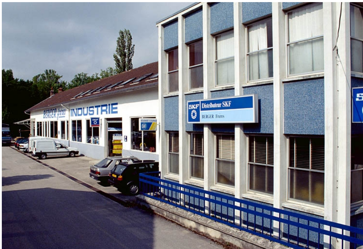
Atelier de fabrication et bureau depuis le nord.
