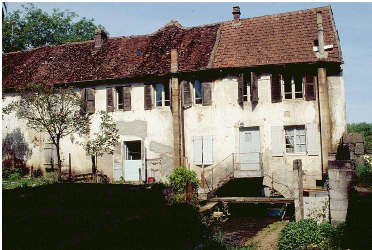
Bâtiment d'eau et logement depuis le sud-est.
