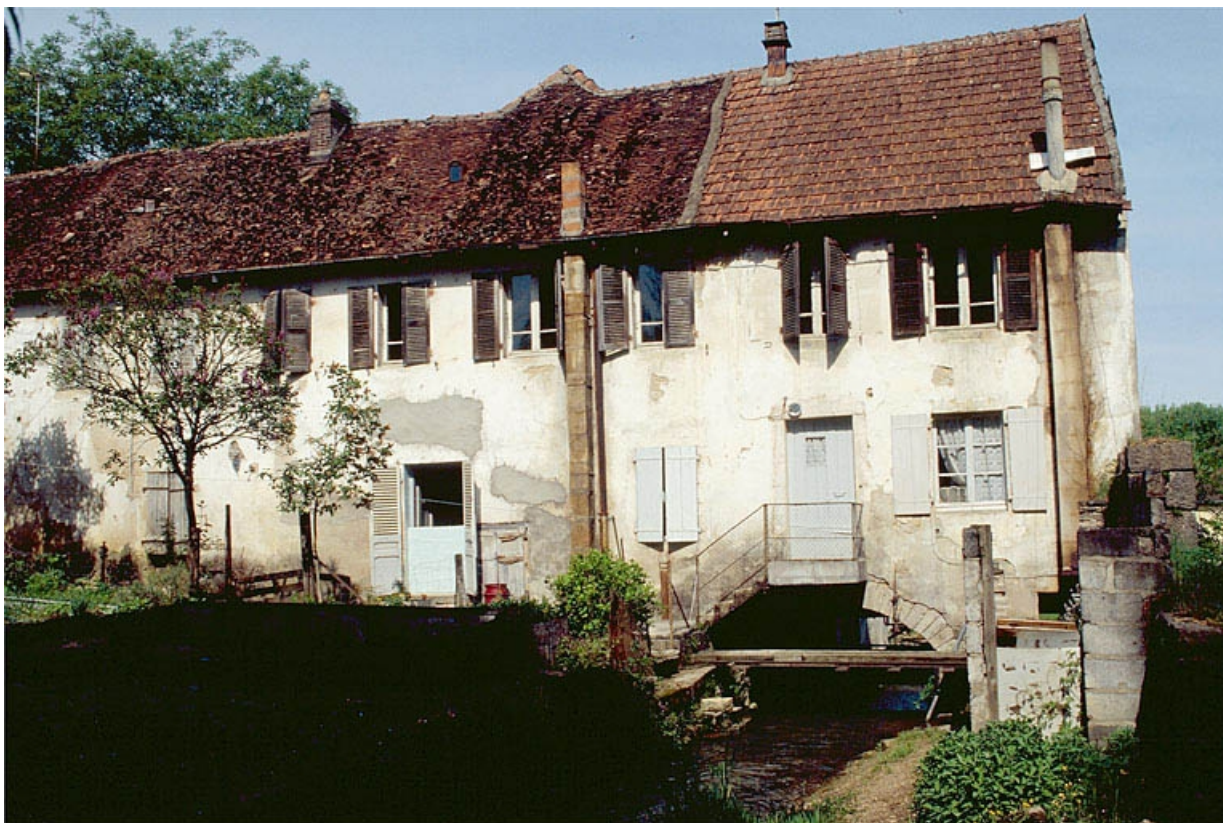
Bâtiment d'eau et logement depuis le sud-est.
