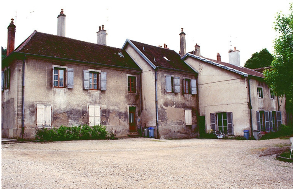
Logement et bureau depuis le nord-est.
