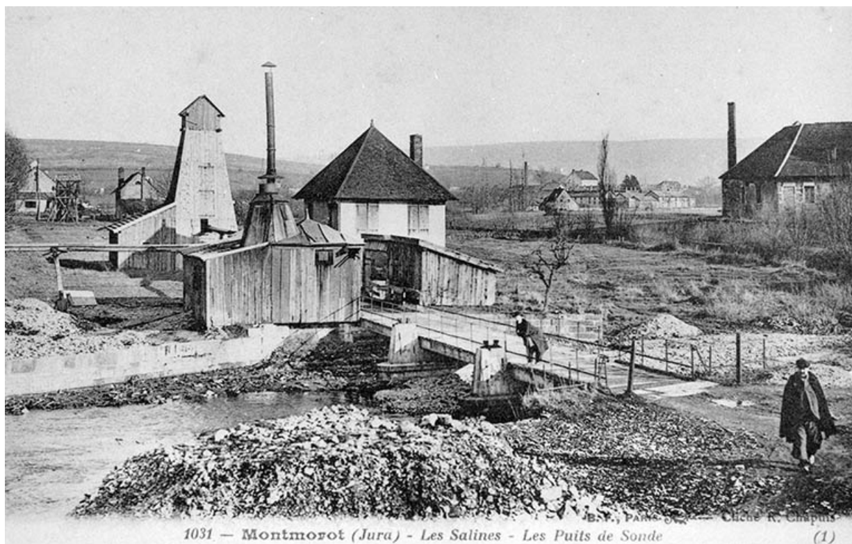
Montmorot (Jura) - Les Salines - Les Puits de Sonde.
