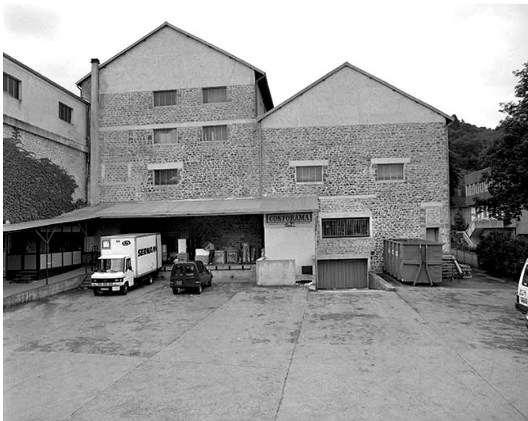
Murs-pignons postérieurs de l'atelier de fabrication.
