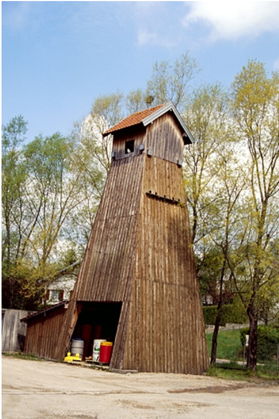
Chevalement du puits n° 7.
