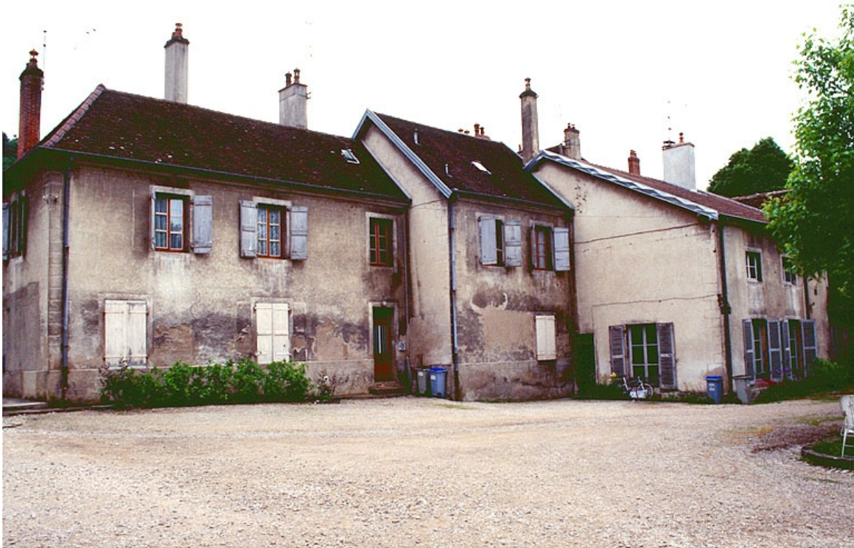
Logement et bureau depuis le nord-est.
