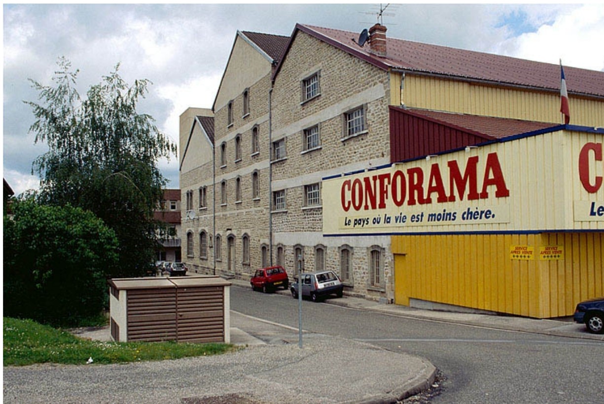
Vue d'ensemble de l'atelier de fabrication nord. 39, Montmorot rue des Salines
