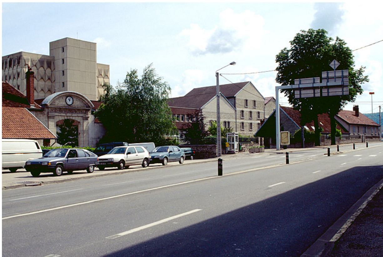
Vue d'ensemble depuis l'ouest. 39, Montmorot rue des Salines
