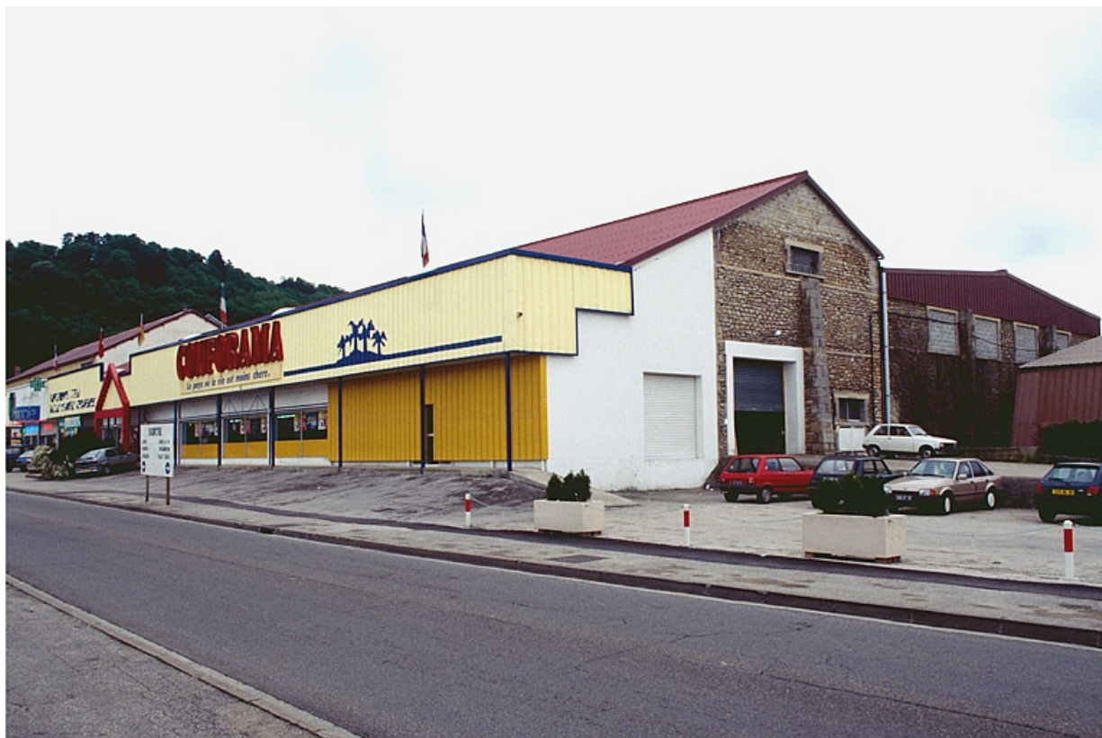
Atelier de fabrication nord vu de trois quarts arrière. 39, Montmorot rue des Salines
