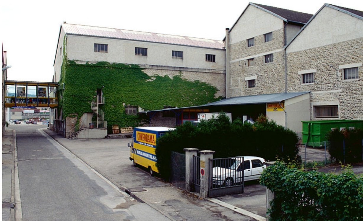
Atelier de fabrication depuis le nord-ouest.
