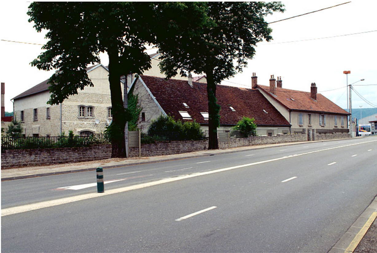
Atelier de fabrication et logements d'ouvriers. 39, Montmorot rue des Salines
