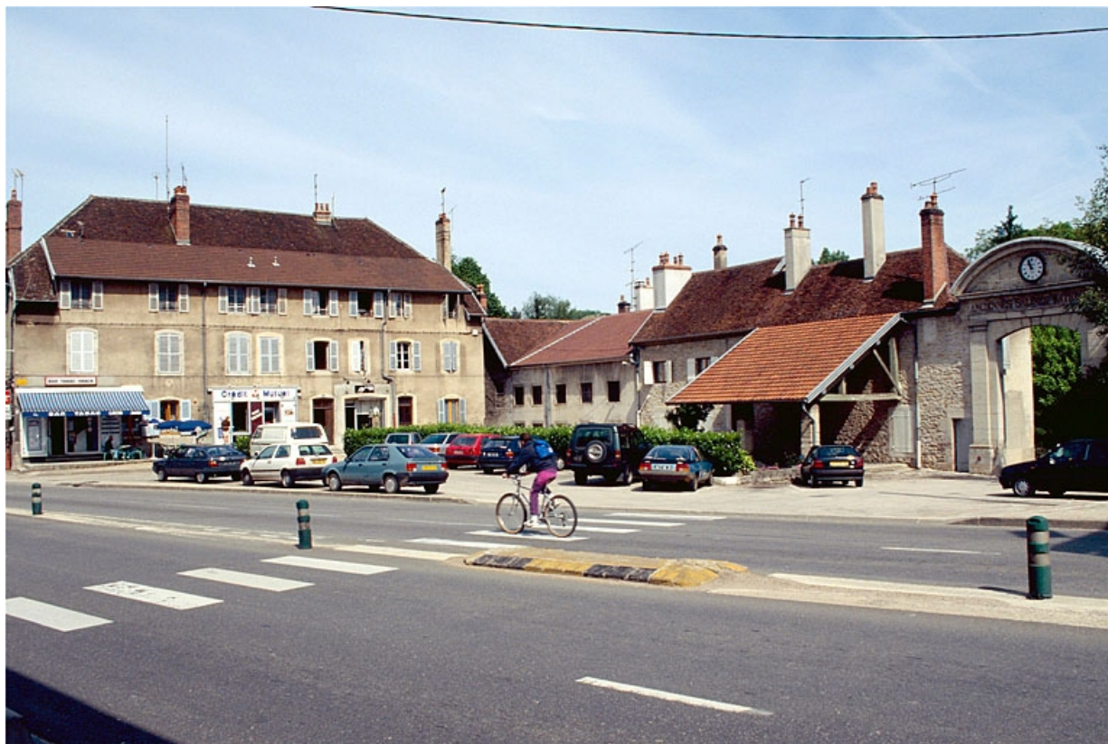
Logements d'ouvriers, bureau et portail. 39, Montmorot rue des Salines
