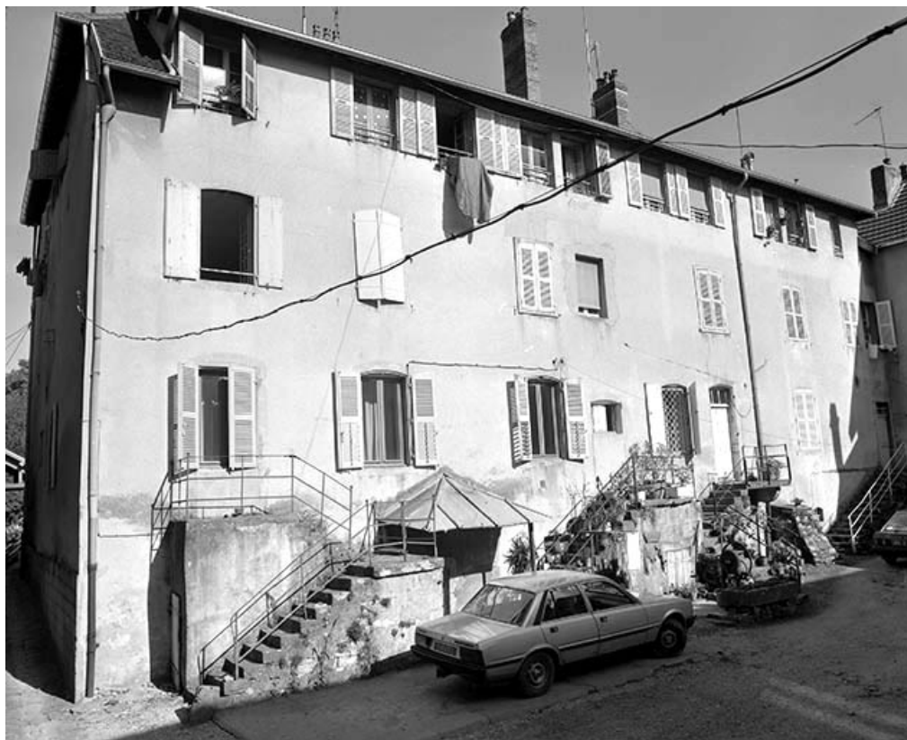
Façade postérieure du logement d'ouvriers.
