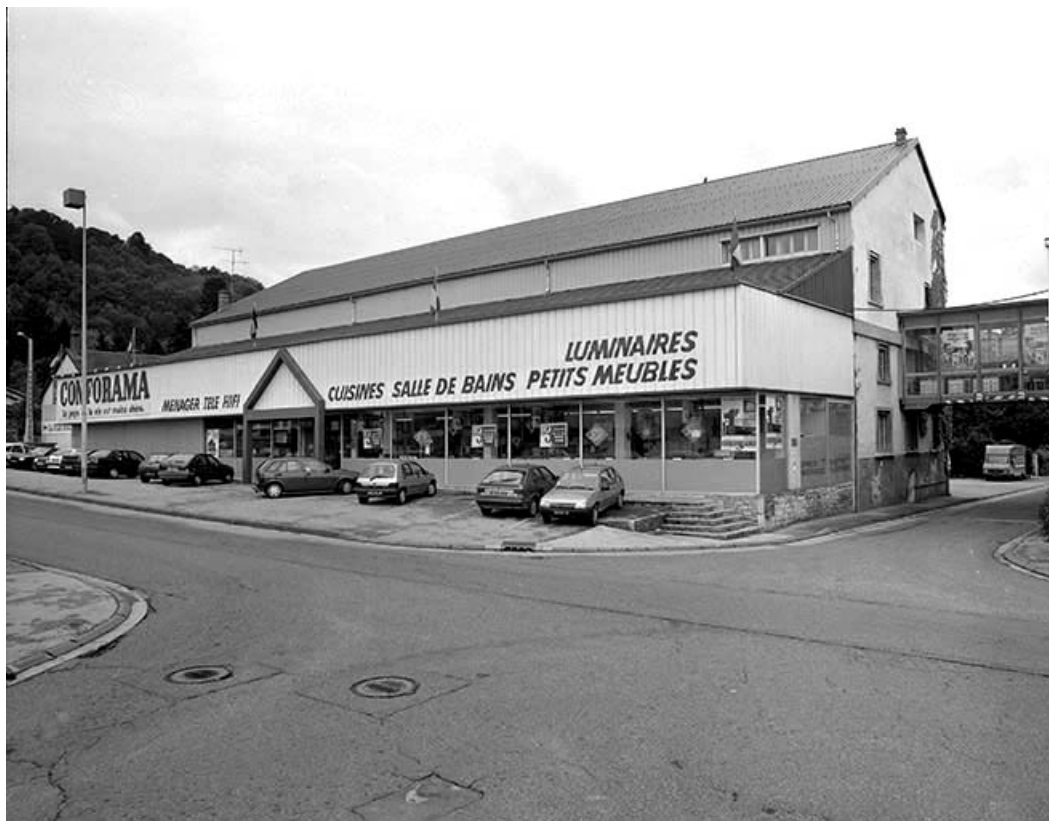
Atelier de fabrication depuis le nord-est. 39, Montmorot rue des Salines
