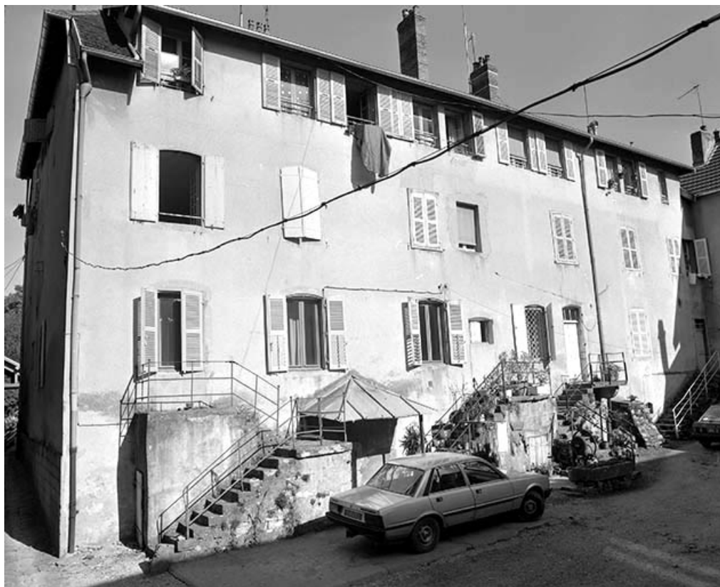
Façade postérieure du logement d'ouvriers.
