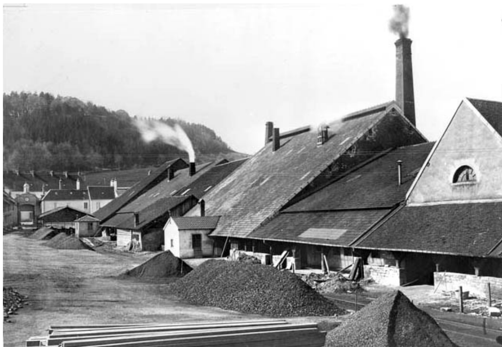
[Cour et bâtiment des poêles de la saline].
