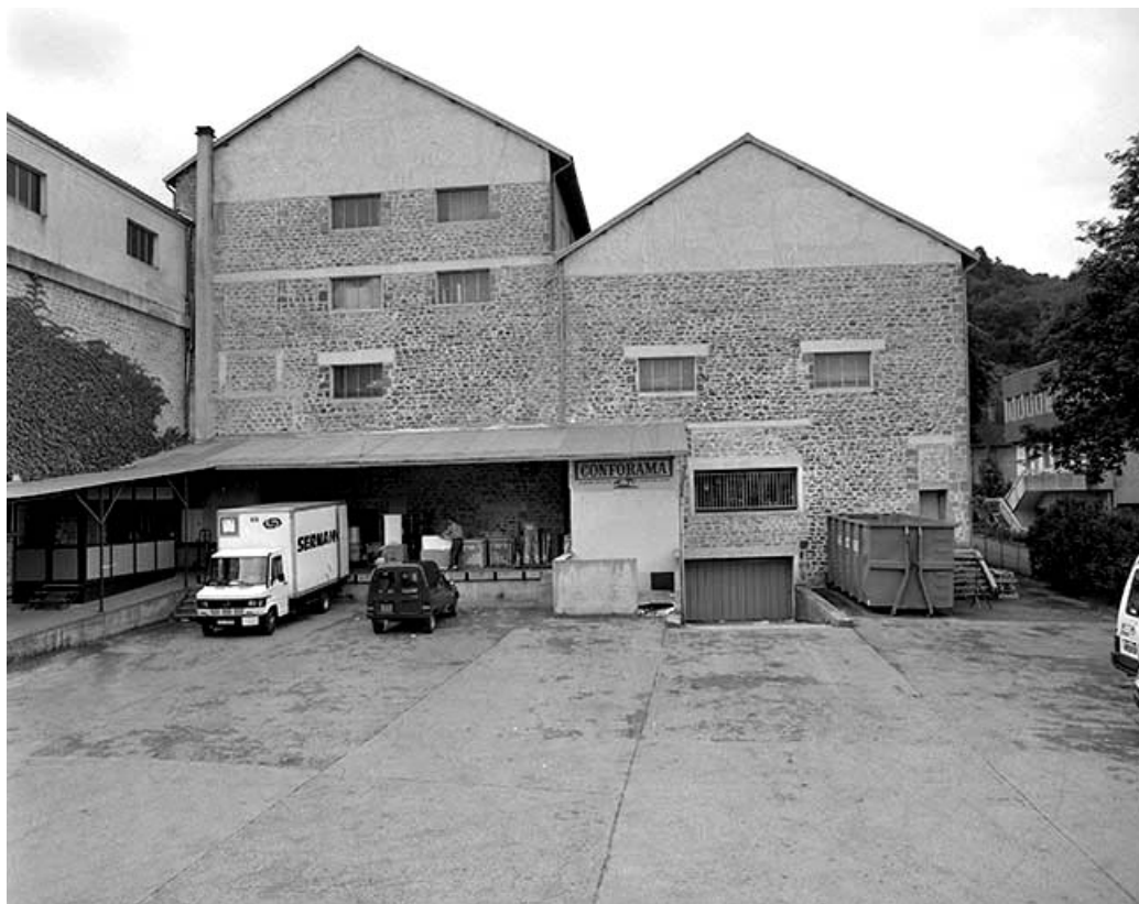
Murs-pignons postérieurs de l'atelier de fabrication.
