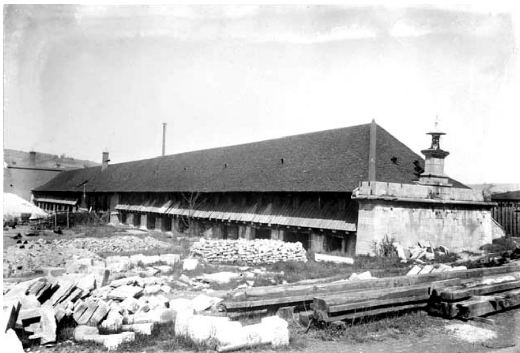
[Bâtiment de décantation de l'eau salée].
