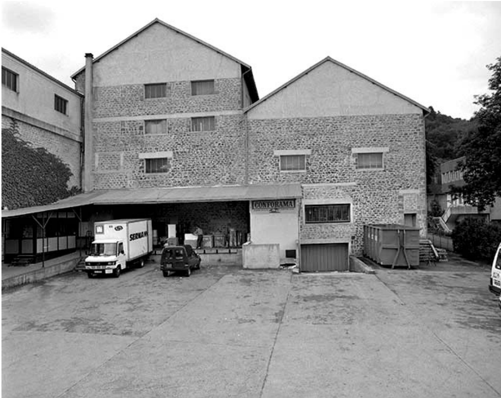
Murs-pignons postérieurs de l'atelier de fabrication.
