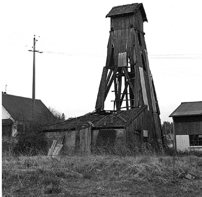
Chevalement du puits n° 10 en 1985.
