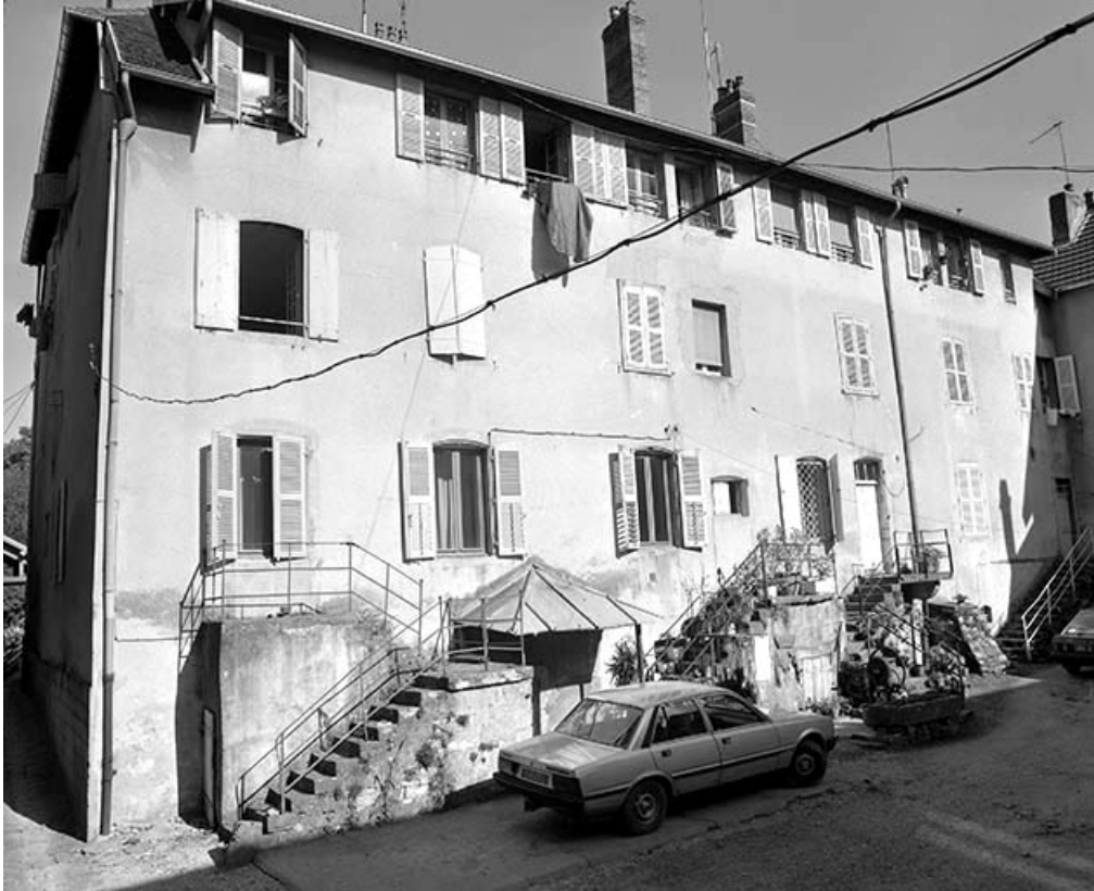
Façade postérieure du logement d'ouvriers.
