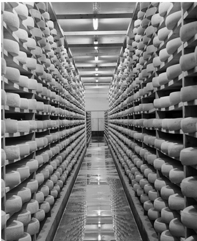
Travée d'une pièce d'affinage.
